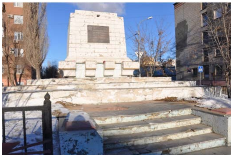
Фото объекта культурного наследия из ЕГР ОКН, № 341610740620005
