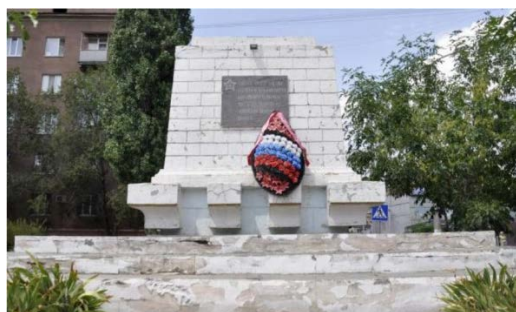
Памятник до проведения ремонтно-реставрационных работ. Дата съемки: до 2019 г.
