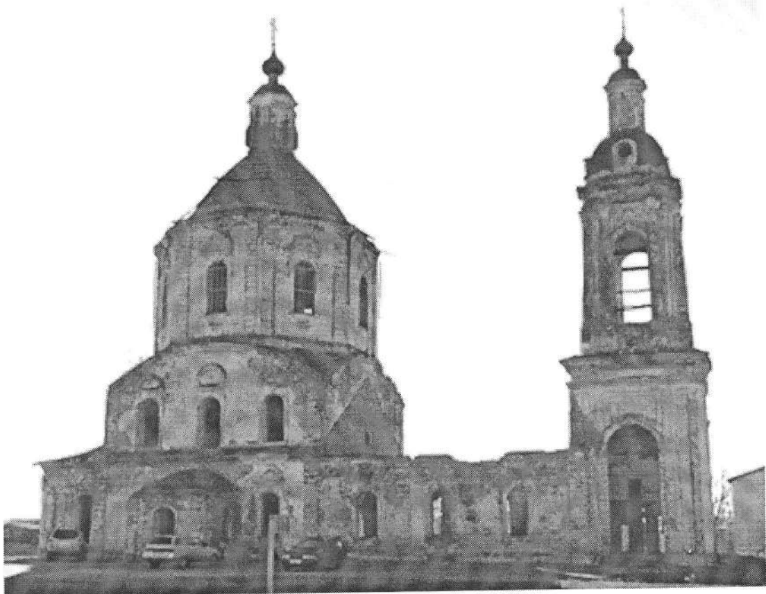
Фото 2. Северный фасад. 2015 г.
