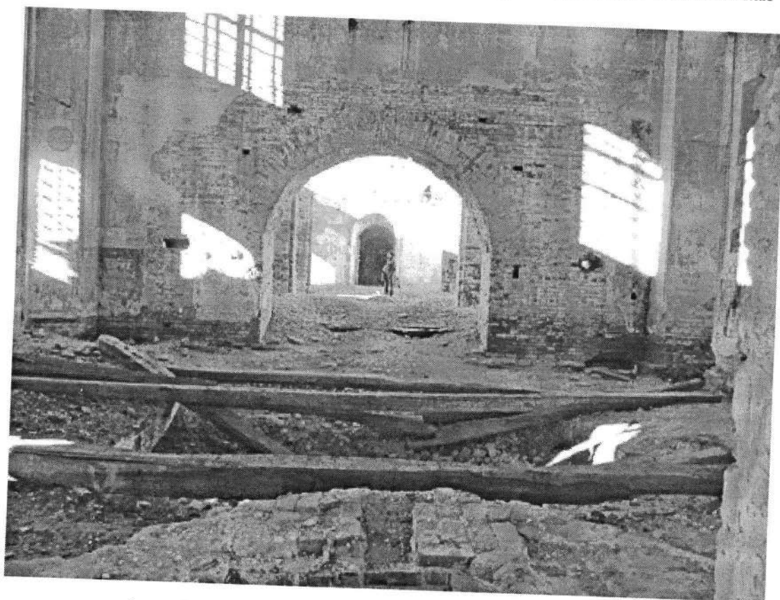
Фото 9. Интерьер. Церковь. Вид на запад. Фото 2015 г.
