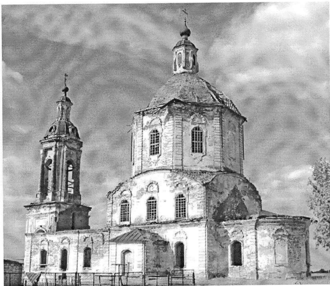
Фото 3. Вид с юго-востока. 2011 г.
