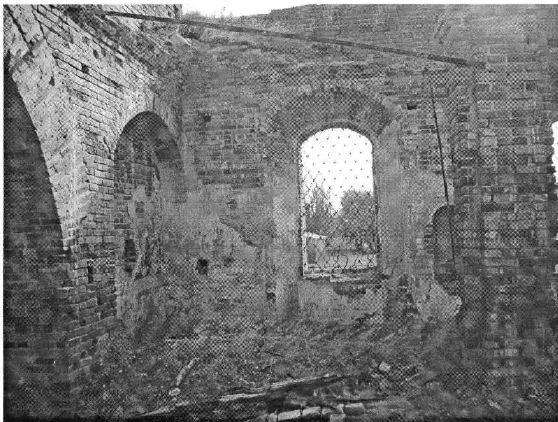
Фото 13. Трапезная. Юго-восточный угол. Фрагмент свода. 2015 г.
