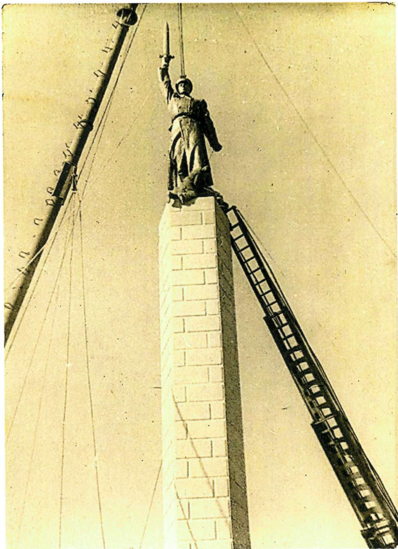
Монтаж поднятой на вершину пилона статуи. 1947 г.
