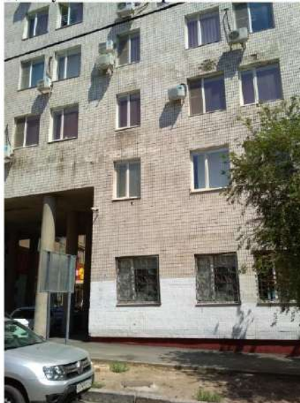
Рис. 2. Фасад по ул. Володарского после производства работ
