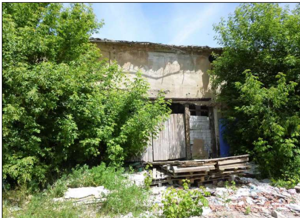
Вид с грунтовой дороги на юго-западный фасад здания цеха завода братьев Максимовых. Современное фото.
