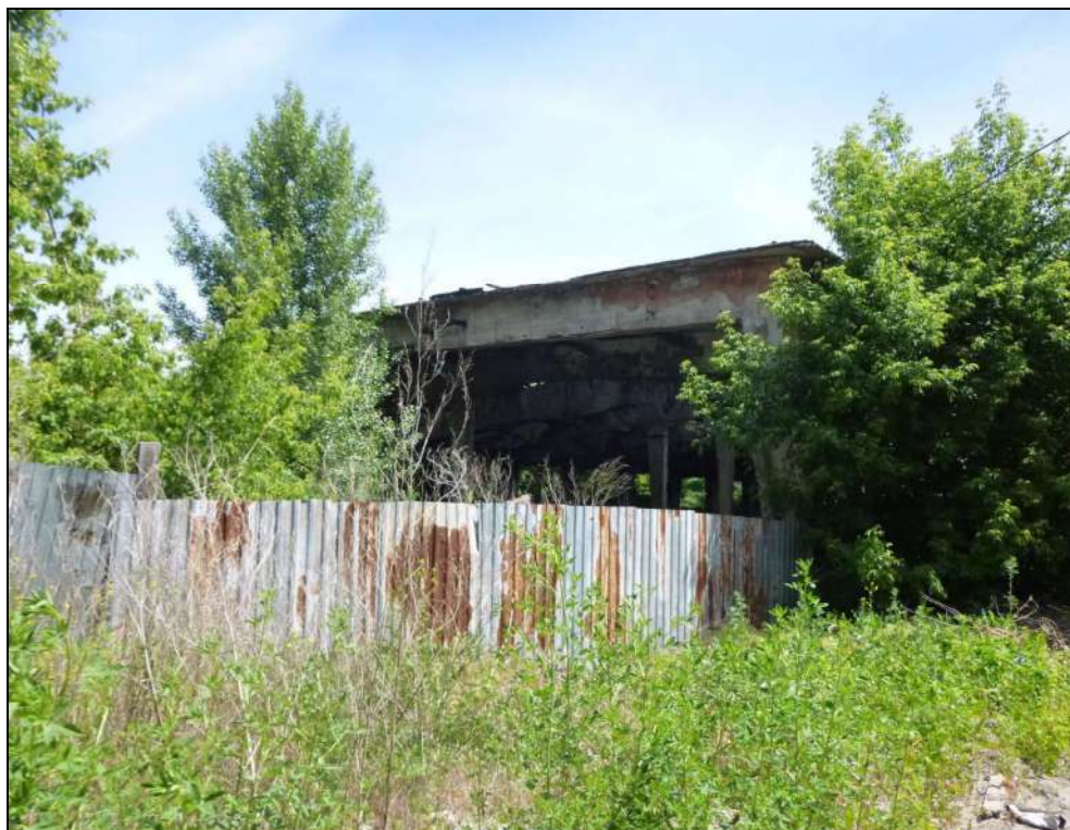
Вид с западной стороны на здание цеха завода братьев Максимовых.
