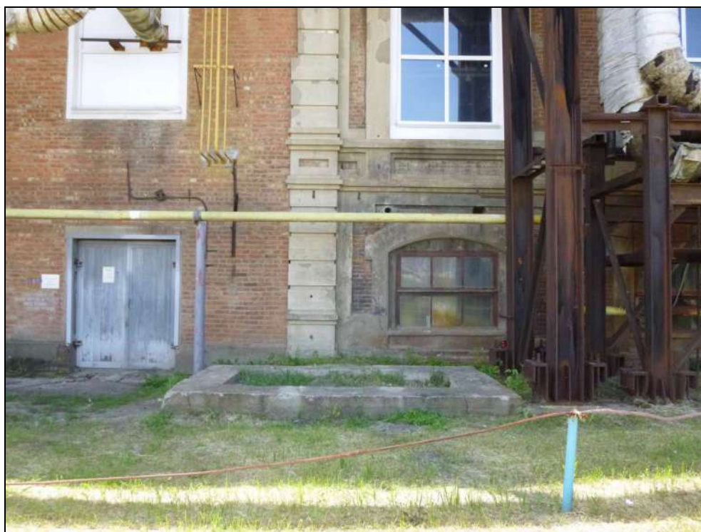
Фрагмент северо-восточного фасада здания котельной. Современное фото.
