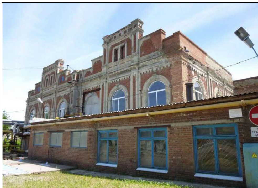
Вид с северо-западной стороны на здание котельной. Современное фото.
