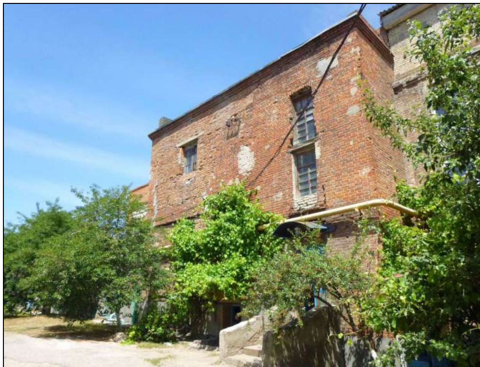
Фрагмент юго-западного фасада здания котельной. Современное фото.
