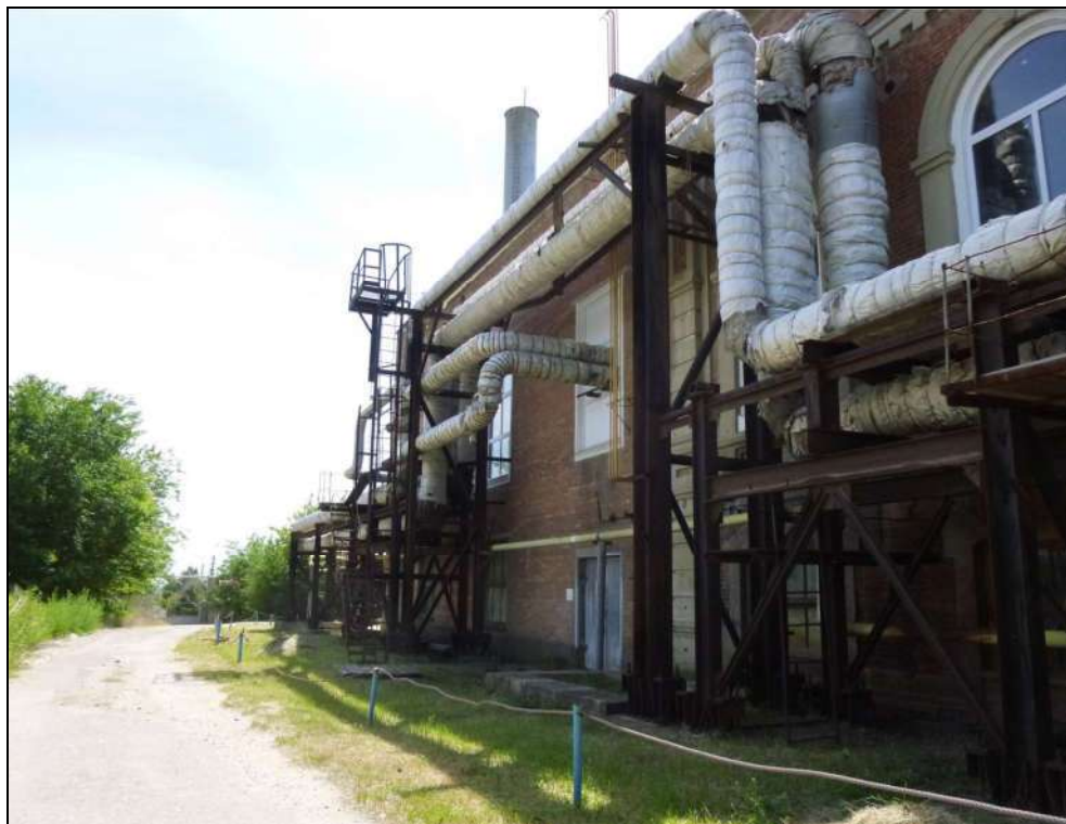
Вид с северо-запада на северо-восточный фасад. Современное фото.
