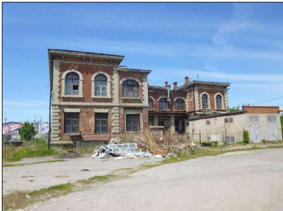
Вид с дворовой территории на боковой (юго-восточный) фасад здания заводууправления. Современное фото.
