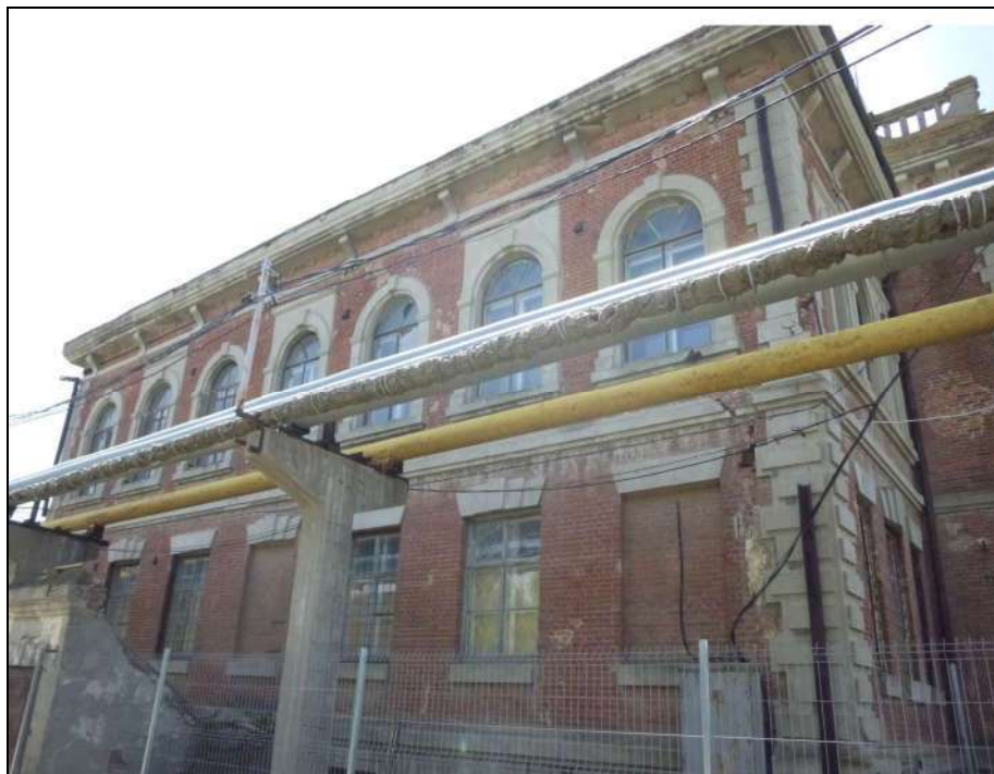
Вид на боковой (северо-восточного) фасад здания заводууправления. Современное фото.
