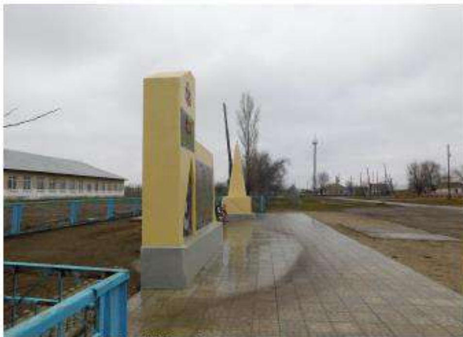
Фото 16. Общий вид на объект с юго-востока.
