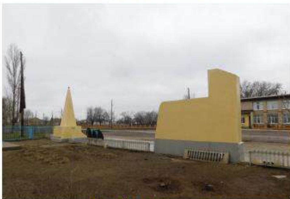
Фото 17. Общий вид на объект с юго-запада.
