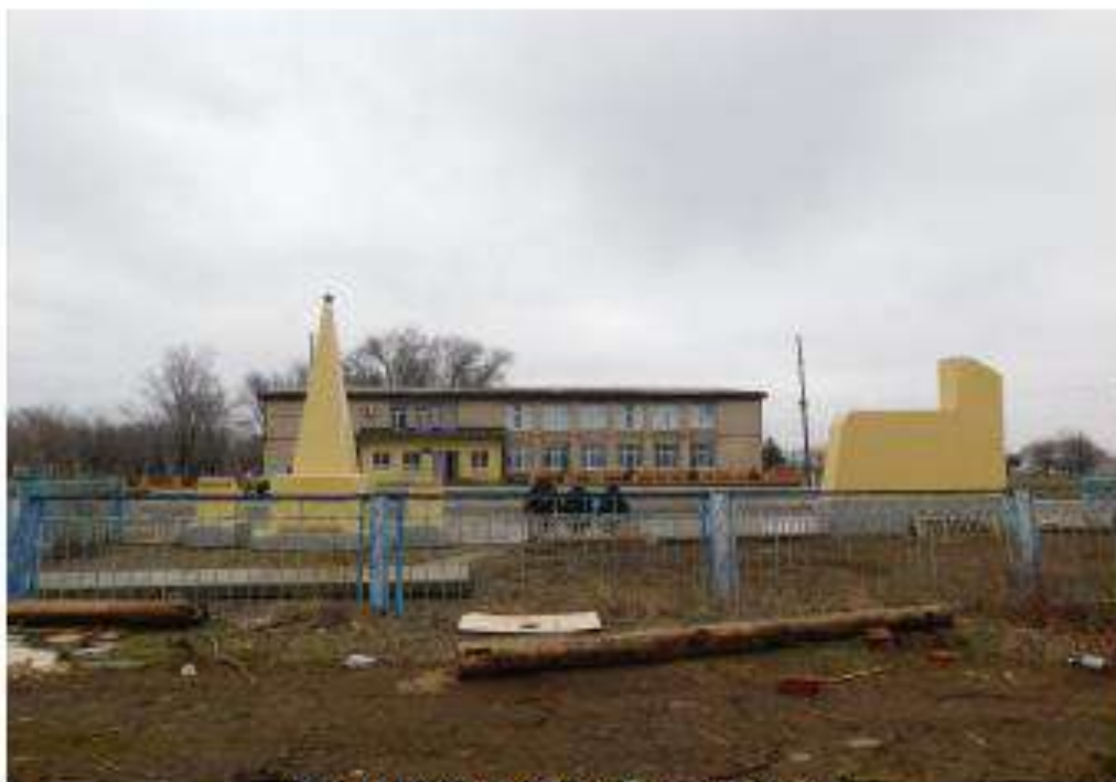
Фото 19. Общий вид на объект с юго-запада.
