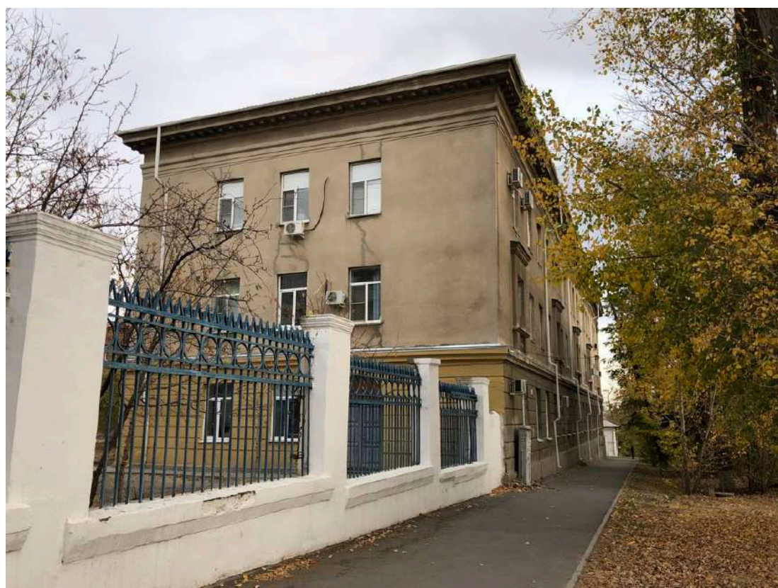
Фотография № 44.4. Здание по адресу ул. Пельшие, д. 2, корп. 1.
