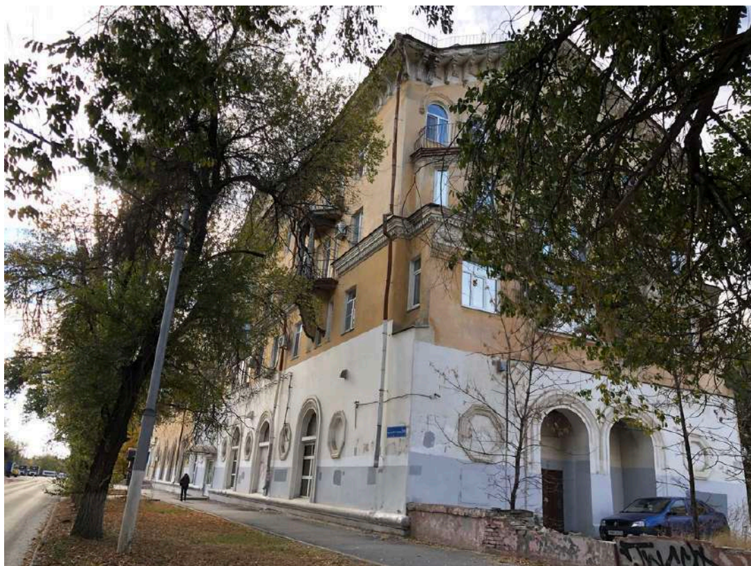
Фотография № 13.3. Здание по адресу пр-кт им. В.И. Ленина, д. 101.
