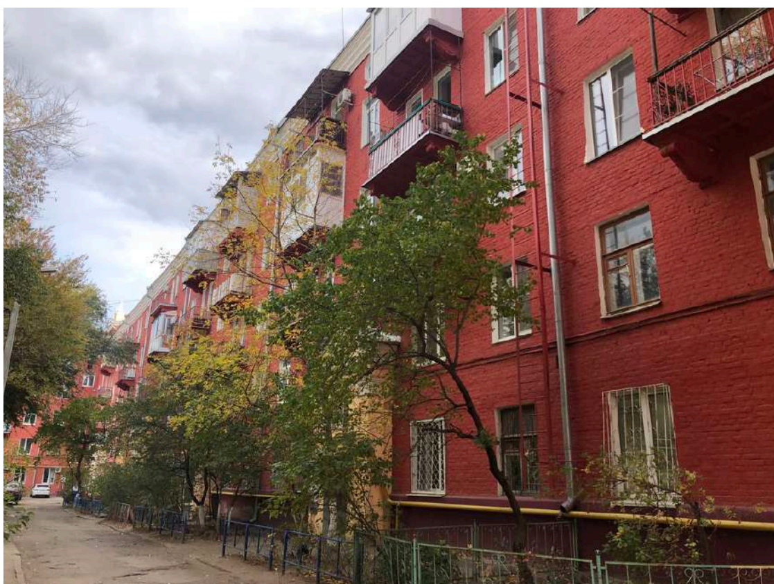
Фотография № 20.3. Здание по адресу пр-кт им. В.И. Ленина, д. 117.
