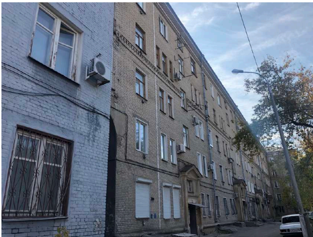
Фотография № 5.2. Здание по адресу пр-кт им. В.И. Ленина, д. 85.
