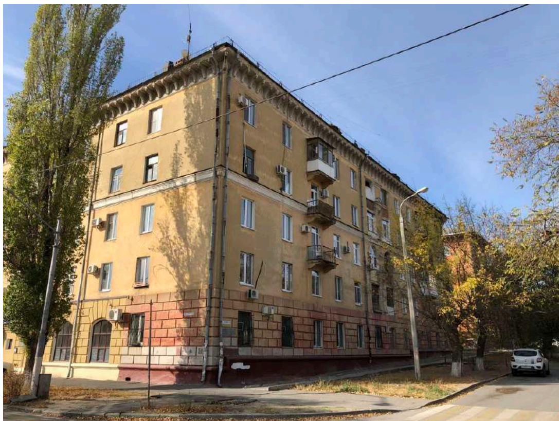
Фотография № 3.2. Здание по адресу пр-кт им. В.И. Ленина, д. 81.
