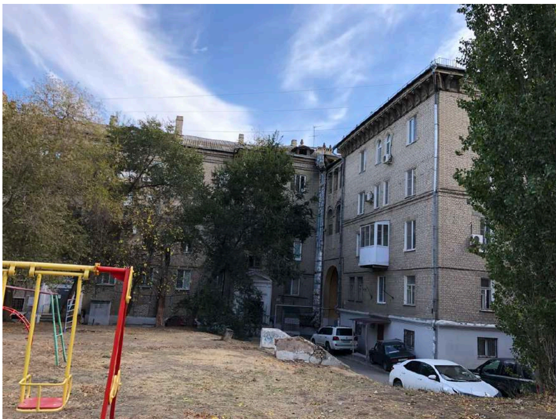
Фотография № 12.5. Здание по адресу пр-кт им. В.И. Ленина, д. 99.
