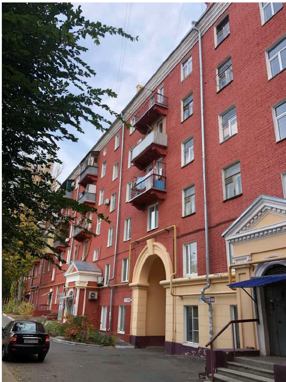
Фотография № 23.1. Здание по адресу пр-кт им. В.И. Ленина, д. 125.
