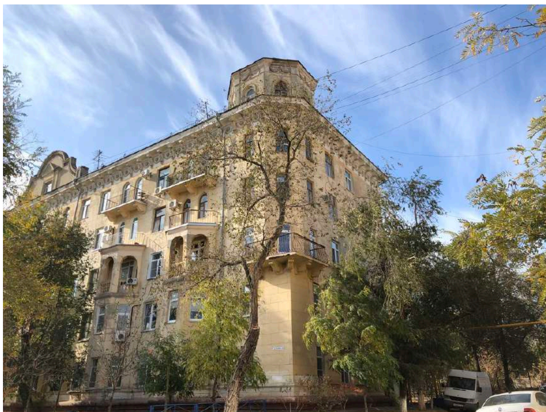
Фотография № 8.3. Здание по адресу пр-кт им. В.И. Ленина, д. 91.
