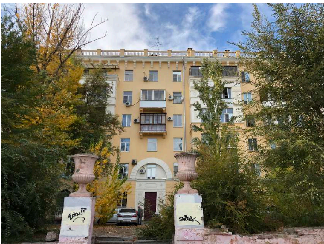
Фотография № 19.1. Здание по адресу пр-кт им. В.И. Ленина, д. 115.
