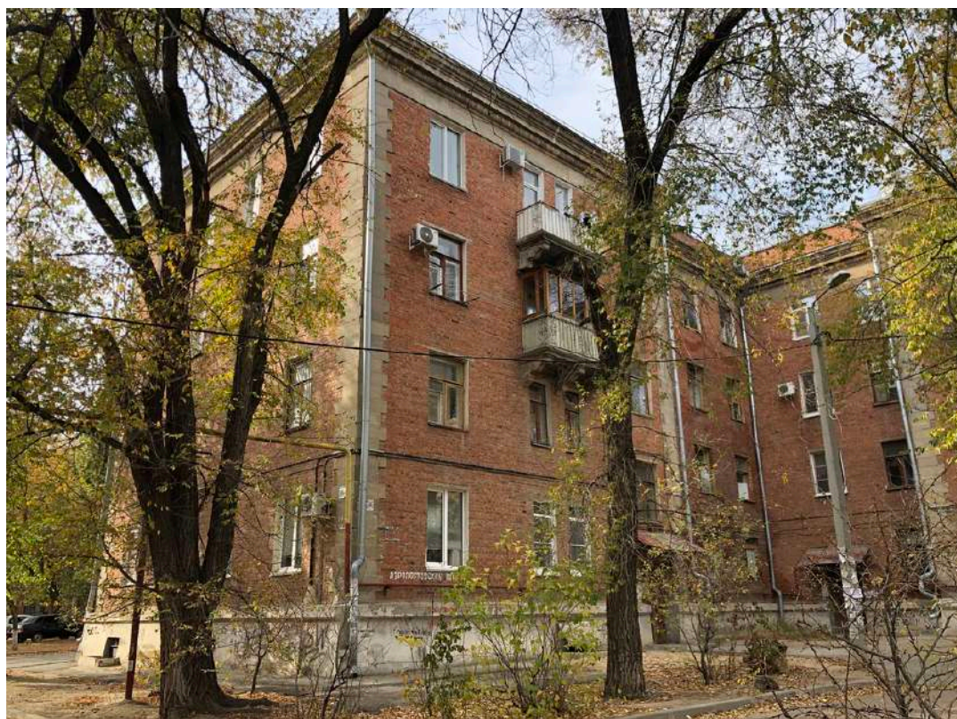
Фотография № 27.4. Здание по адресу Аэропортовский пер., д. 6.
