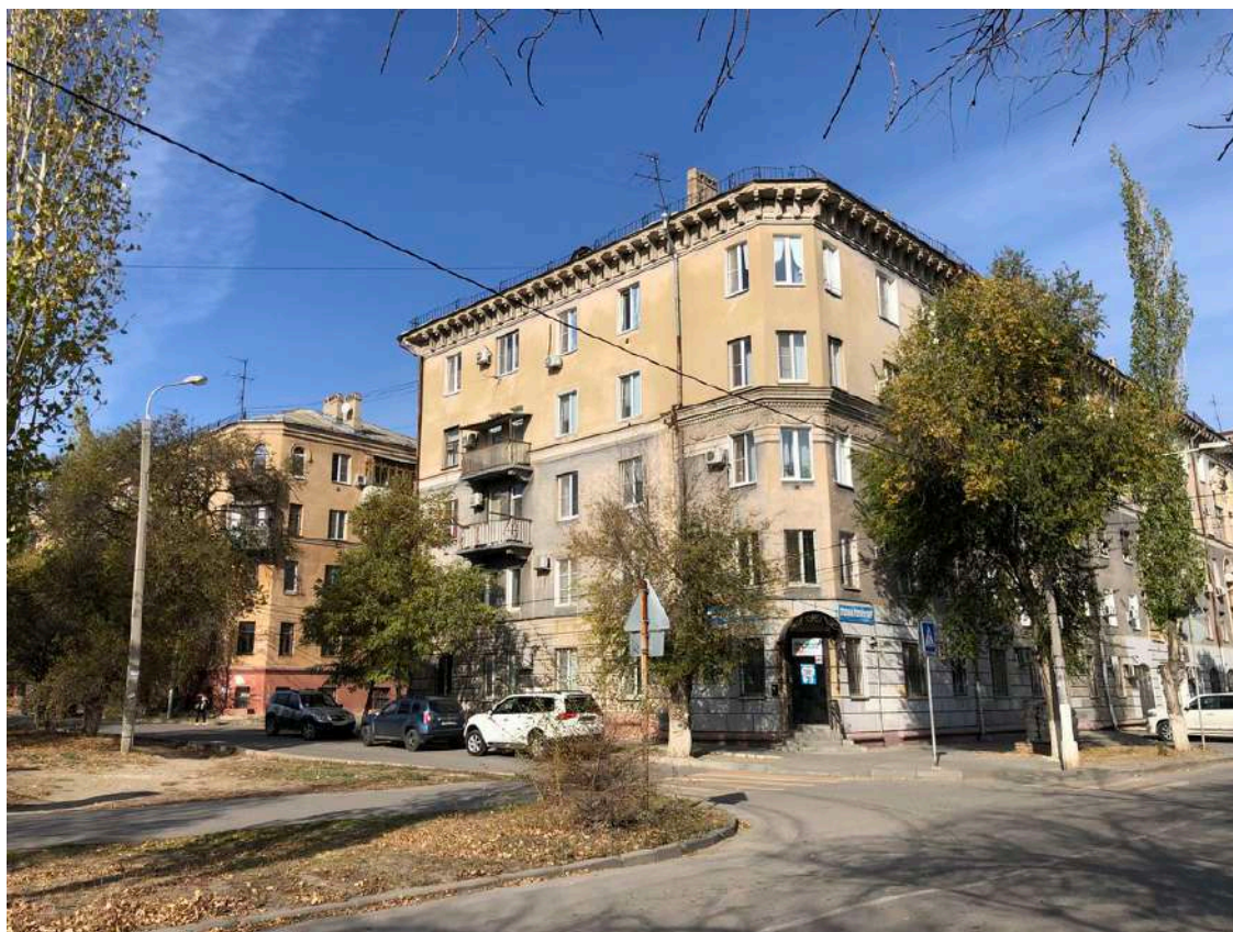
Фотография № 5.5. Здание по адресу пр-кт им. В.И. Ленина, д. 85.
