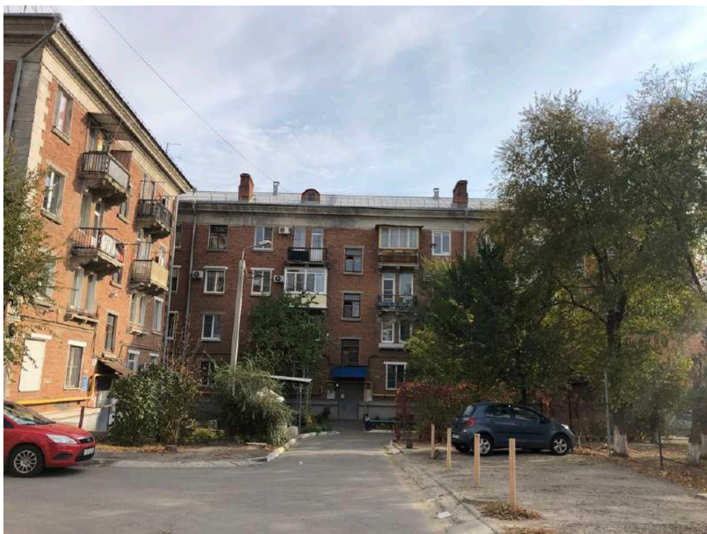
Фотография № 29.3. Здание по адресу ул. Титова, д. 4.
