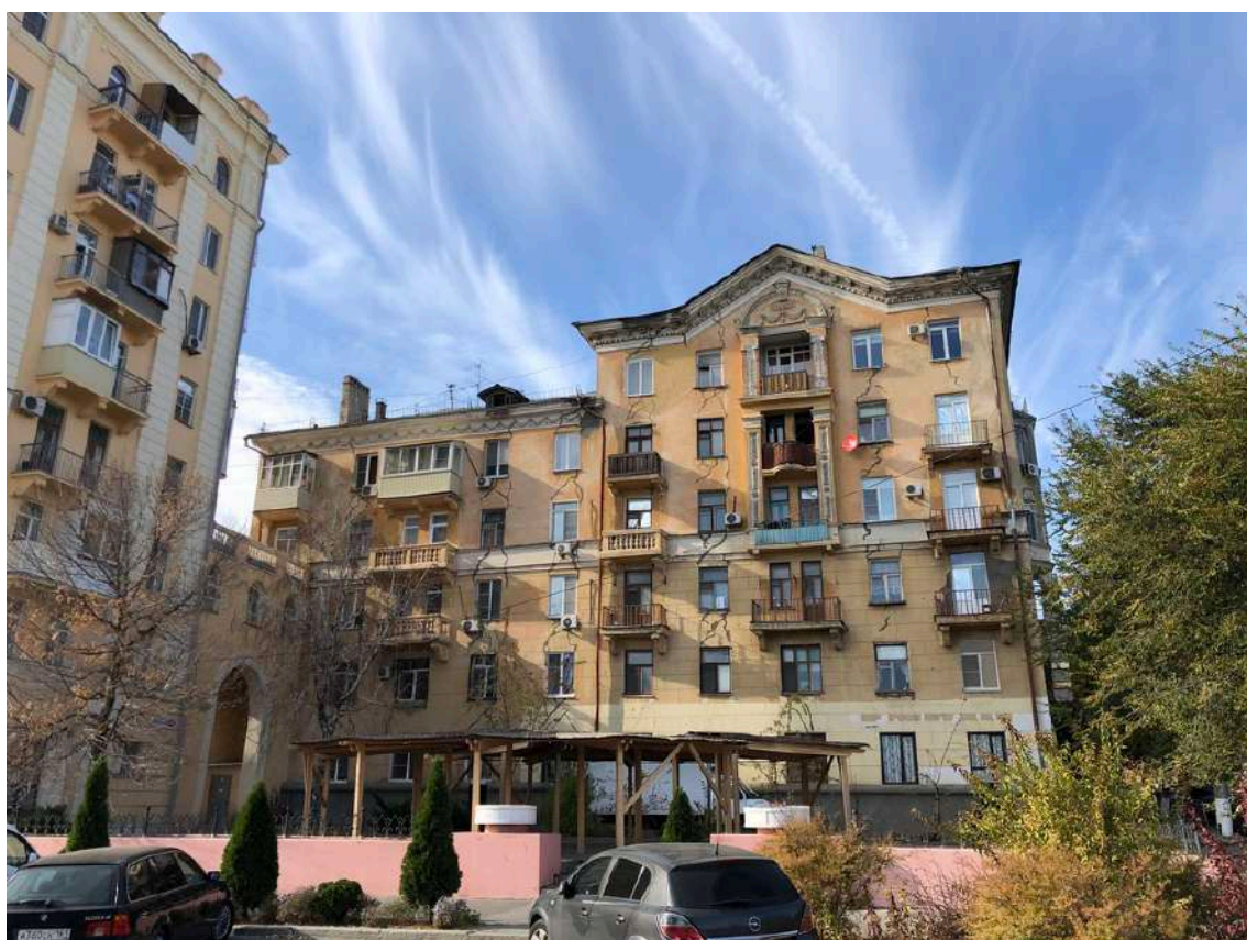
Фотография № 9.3. Здание по адресу пр-кт им. В.И. Ленина, д. 93.
