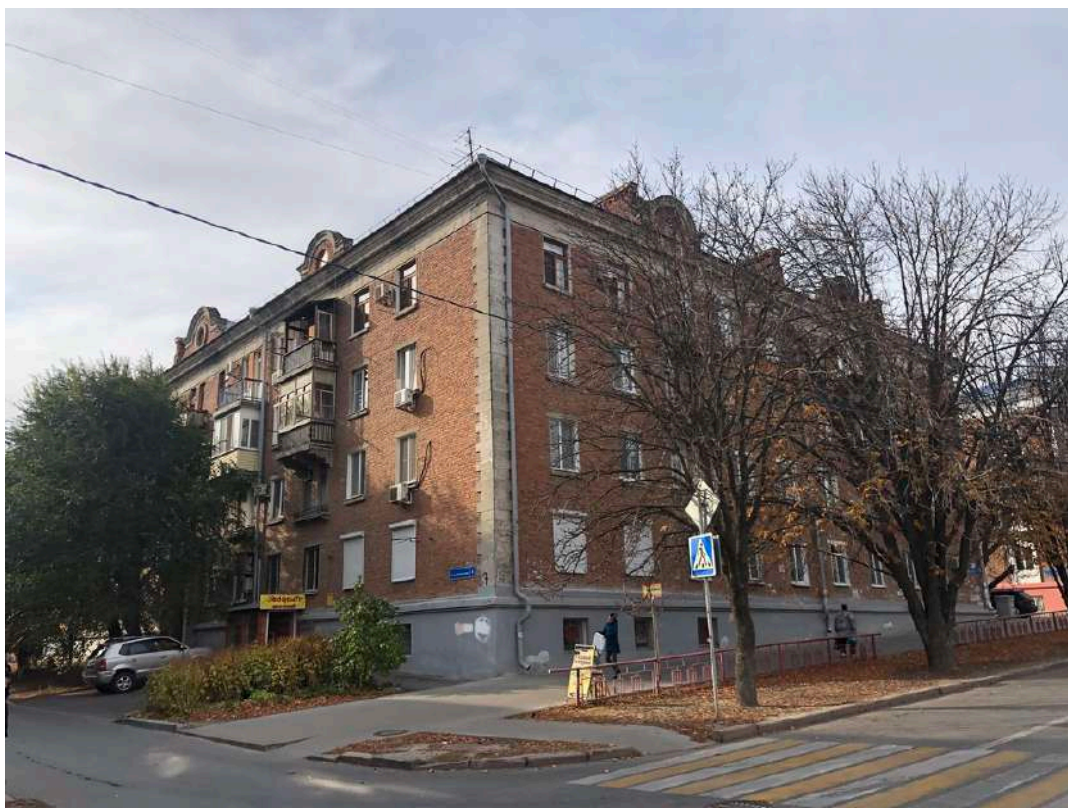
Фотография № 29.5. Здание по адресу ул. Титова, д. 4.
