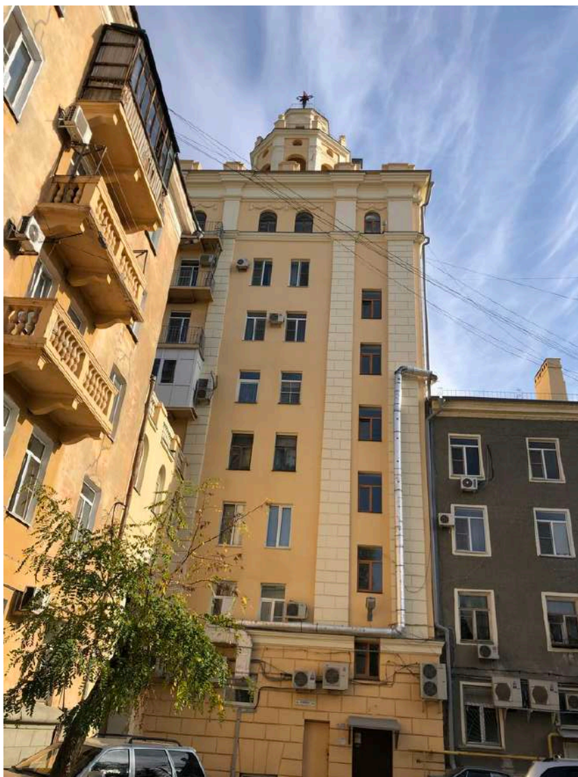
Фотография № 9.4. Здание по адресу пр-кт им. В.И. Ленина, д. 93.
