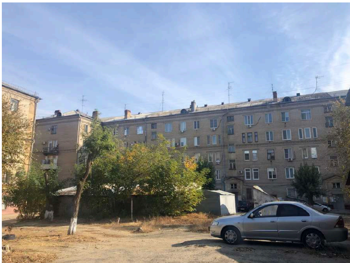
Фотография № 6.1. Здание по адресу пр-кт им. В.И. Ленина, д. 87.
