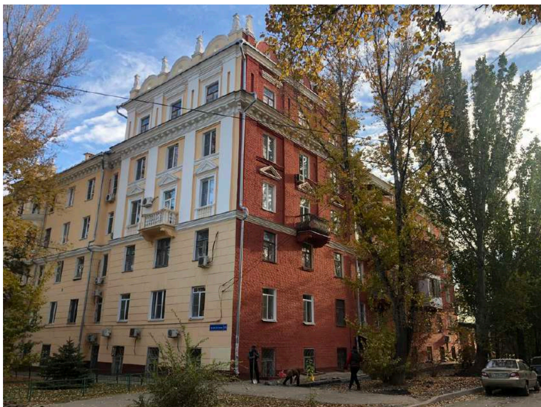
Фотография № 21.2. Здание по адресу пр-кт им. В.И. Ленина, д. 119.
