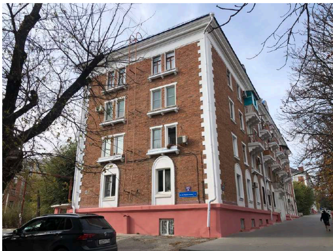
Фотография № 30.1. Здание по адресу ул. Титова, д. 6.
