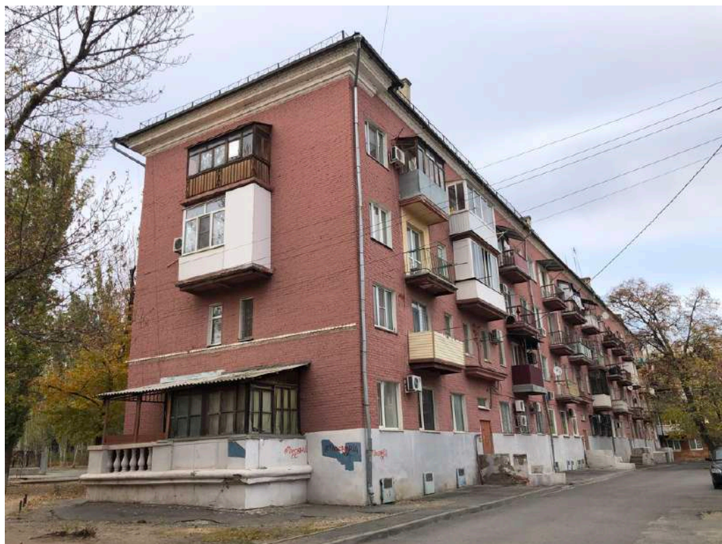
Фотография № 42.3. Здание по адресу ул. Гуртьева, д. 4.
