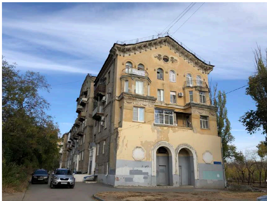
Фотография № 14.1. Здание по адресу пр-кт им. В.И. Ленина, д. 103.
