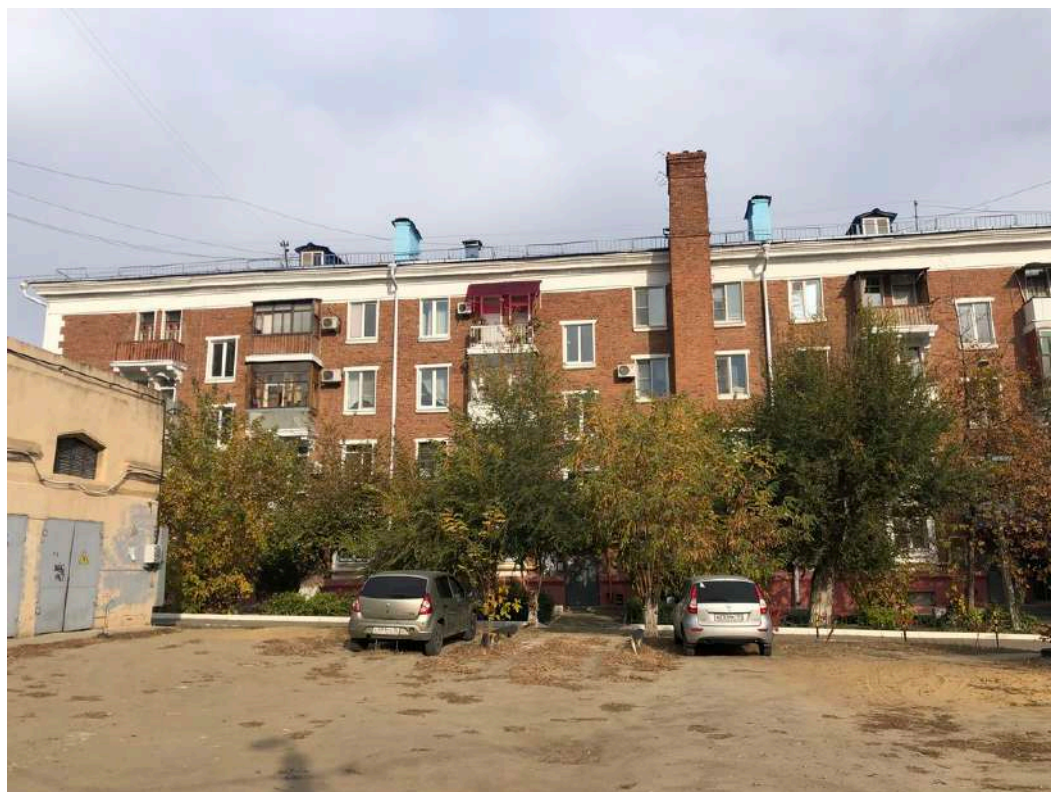
Фотография № 30.2. Здание по адресу ул. Титова, д. 6.
