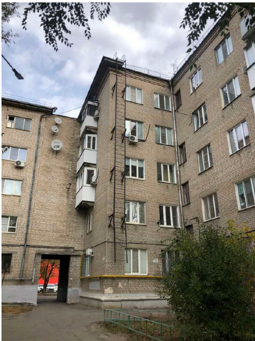
Фотография № 16.3. Здание по адресу пр-кт им. В.И. Ленина, д. 107.
