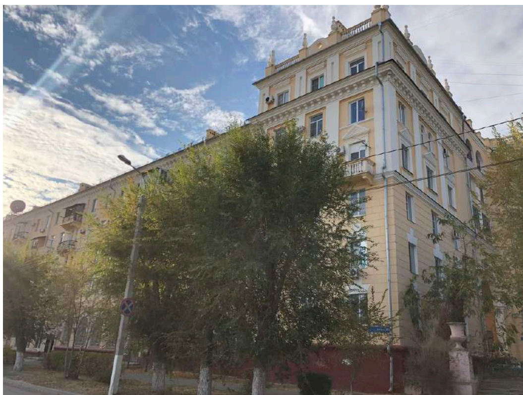
Фотография № 18.2. Здание по адресу пр-кт им. В.И. Ленина, д. 113.
