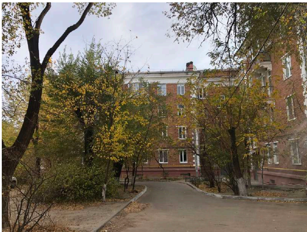
Фотография № 28.1. Здание по адресу ул. Гуртьева, д. 5.
