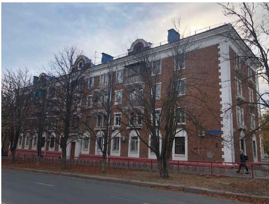
Фотография № 30.3. Здание по адресу ул. Титова, д. 6.
