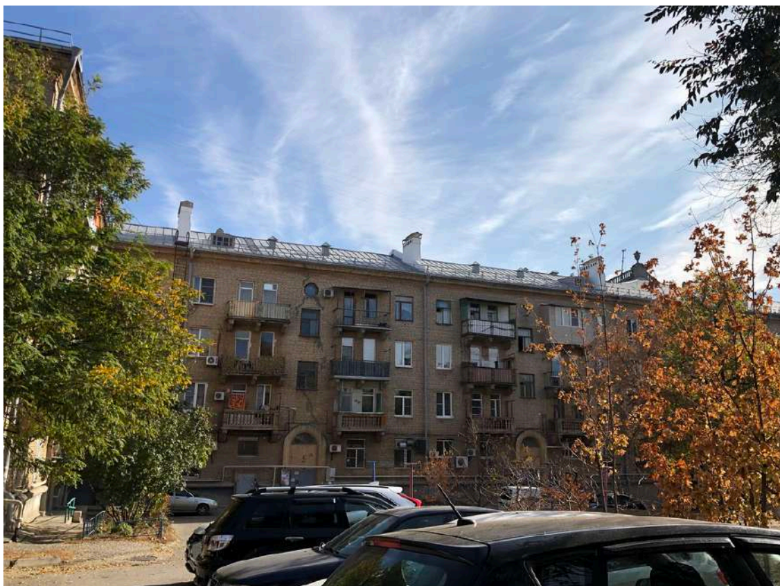
Фотография № 7.4. Здание по адресу пр-кт им. В.И. Ленина, д. 89.
