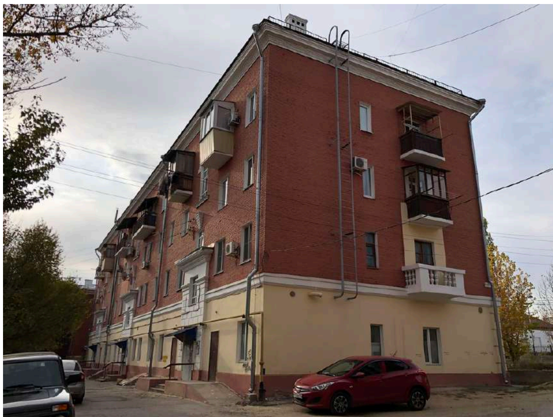
Фотография № 39.4. Здание по адресу ул. Гуртьева, д. 2.
