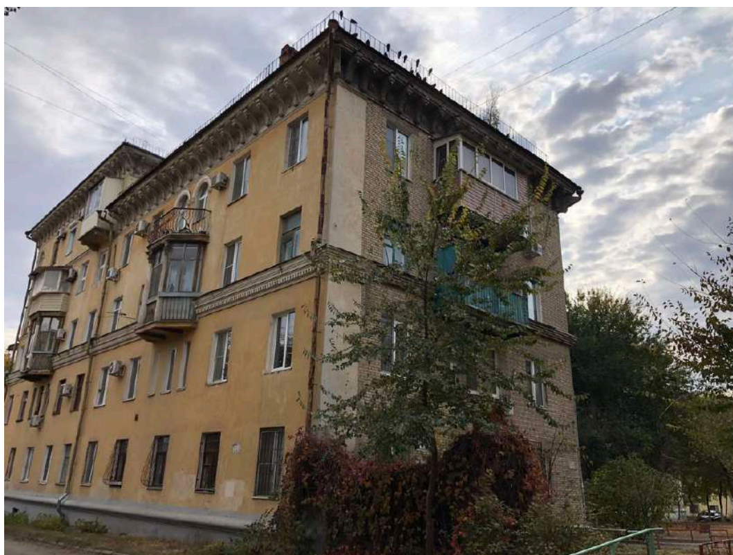
Фотография № 15.1. Здание по адресу пр-кт им. В.И. Ленина, д. 105.
