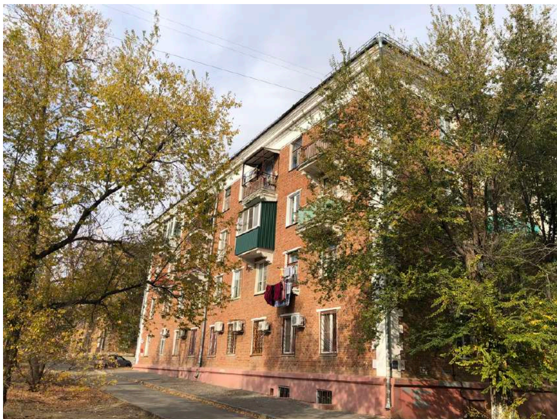
Фотография № 28.3. Здание по адресу ул. Гуртьева, д. 5.
