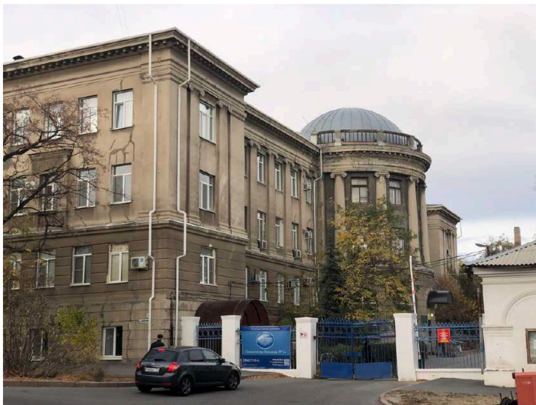
Фотография № 44.1. Здание по адресу ул. Пельше, д. 2, корп. 1.
