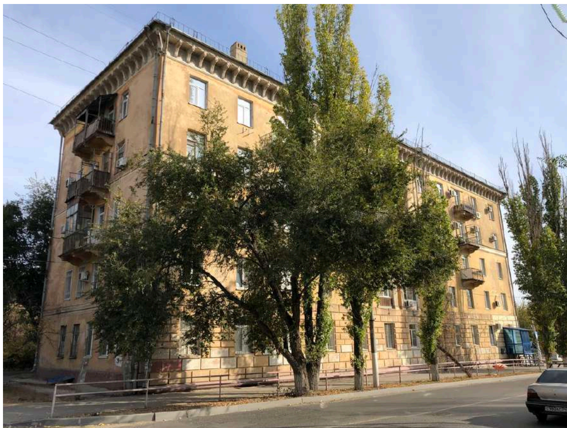
Фотография № 1.2. Здание по адресу пр-кт им. В.И. Ленина, д. 79.
