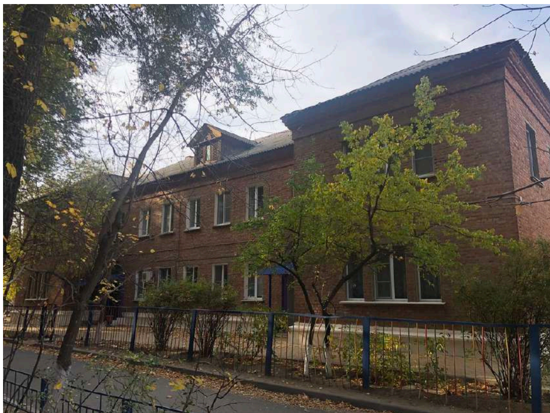
Фотография № 34.2. Здание по адресу просп. им. Ленина, д. 127а.
