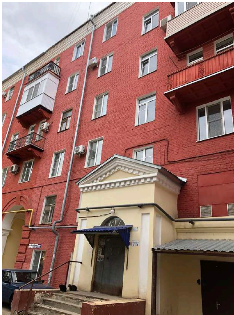
Фотография № 17.5. Здание по адресу пр-кт им. В.И. Ленина, д. 111.
