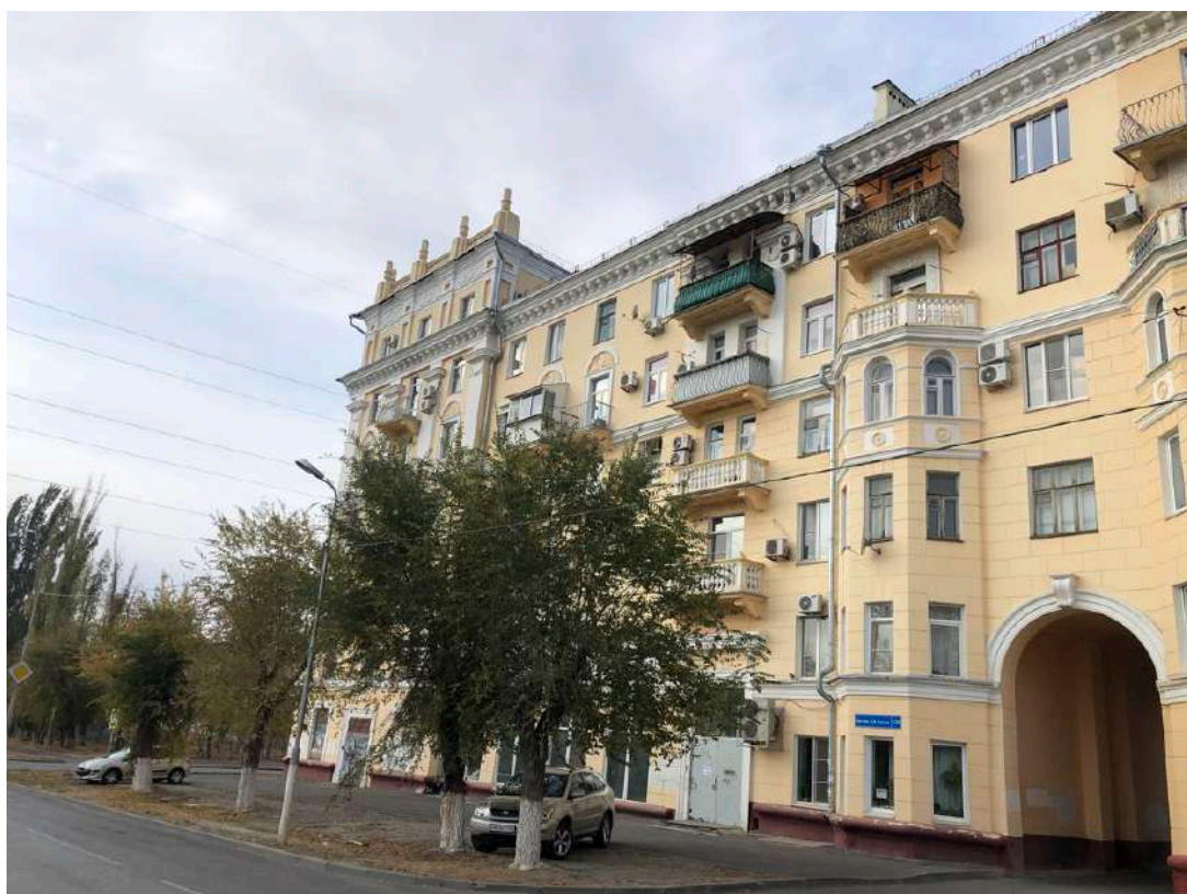
Фотография № 22.2. Здание по адресу пр-кт им. В.И. Ленина, д. 123.
