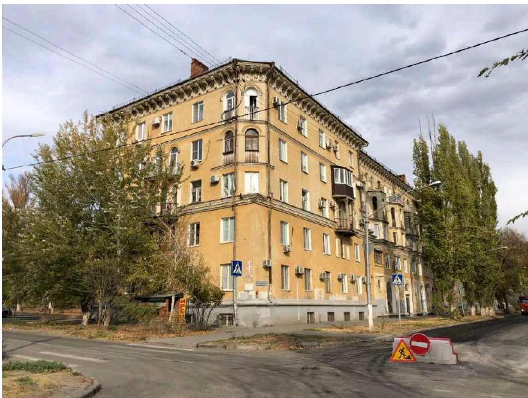
Фотография № 15.4. Здание по адресу пр-кт им. В.И. Ленина, д. 105.
