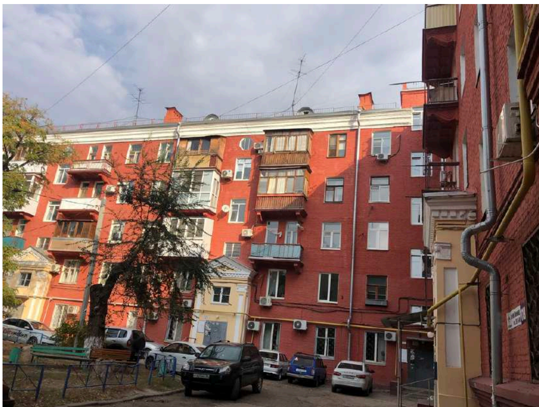
Фотография № 21.3. Здание по адресу пр-кт им. В.И. Ленина, д. 119.
