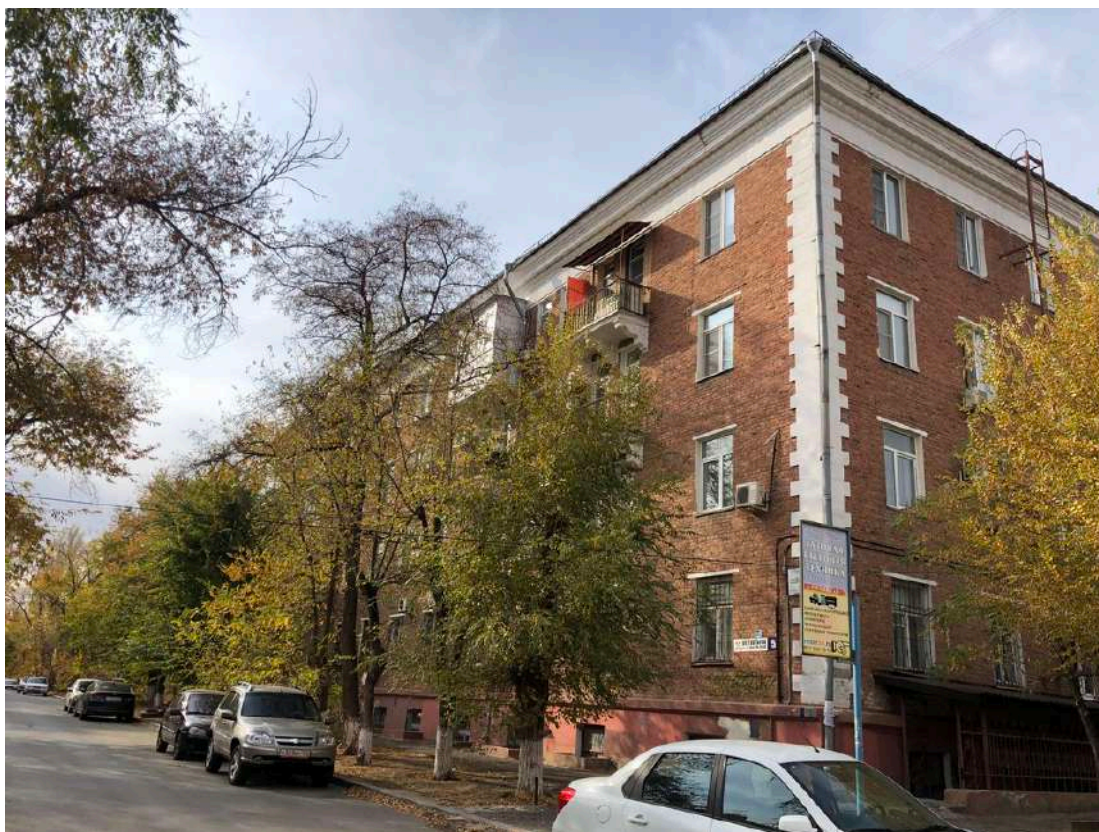
Фотография № 28.4. Здание по адресу ул. Гуртьева, д. 5.
