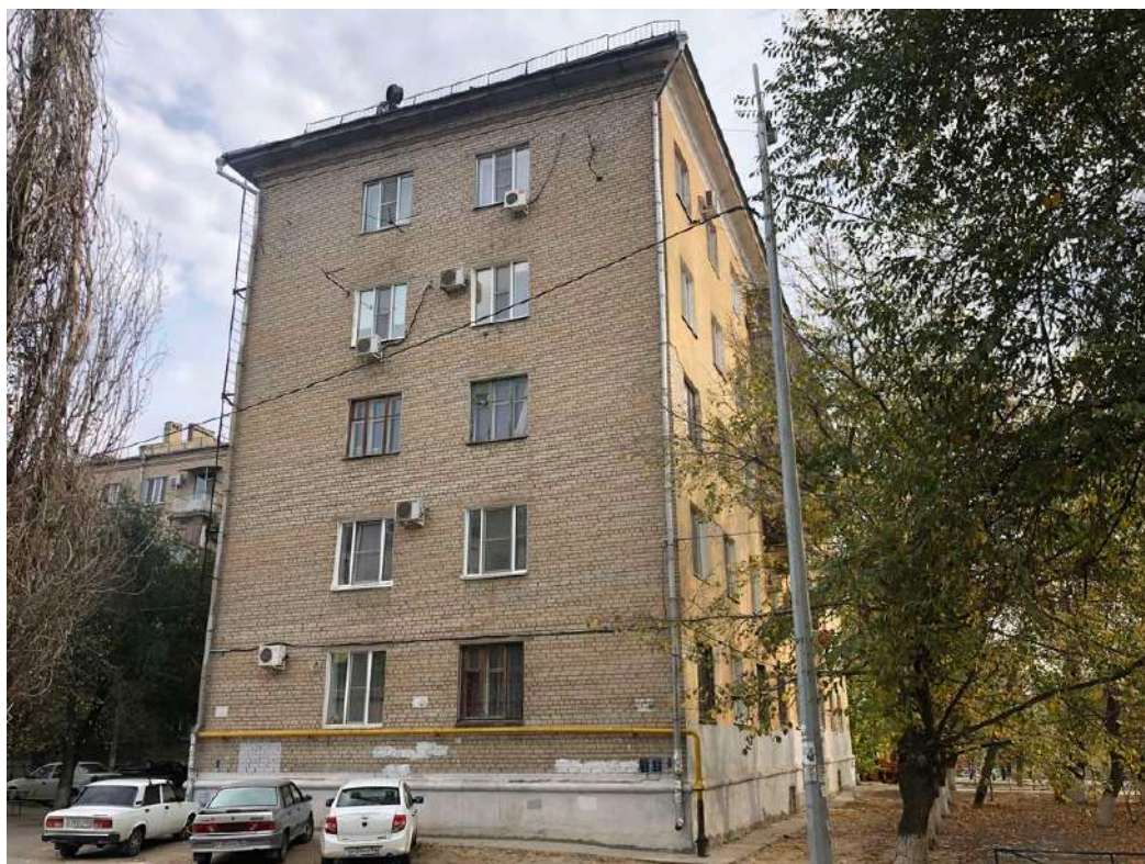
Фотография № 16.2. Здание по адресу пр-кт им. В.И. Ленина, д. 107.
