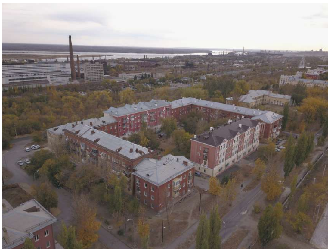
Аэрофотоснимок № 42. Застройка по ул. генерала Гуртьева
