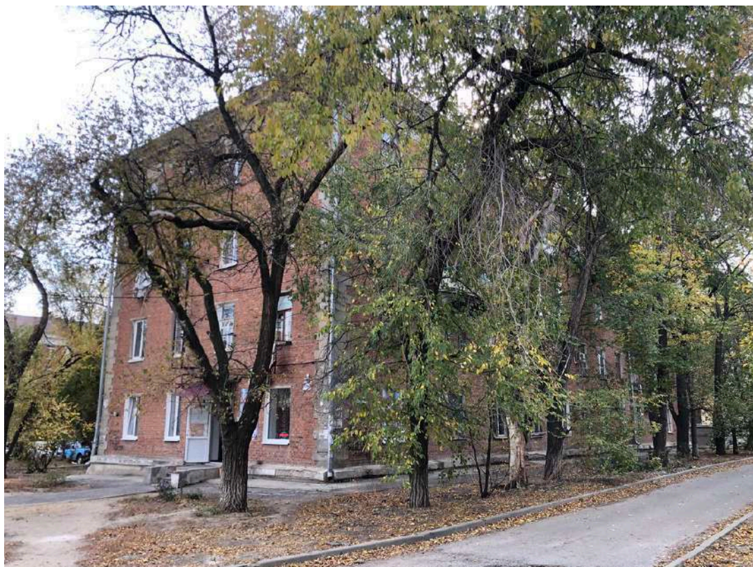
Фотография № 27.2. Здание по адресу Аэропортовский пер., д. 6.
