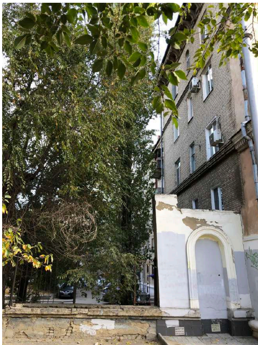
Фотография № 12.2. Здание по адресу пр-кт им. В.И. Ленина, д. 99.
