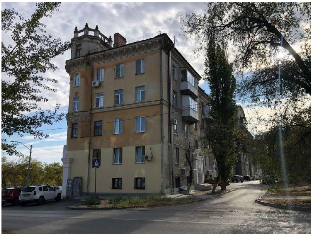
Фотография № 14.4. Здание по адресу пр-кт им. В.И. Ленина, д. 103.
