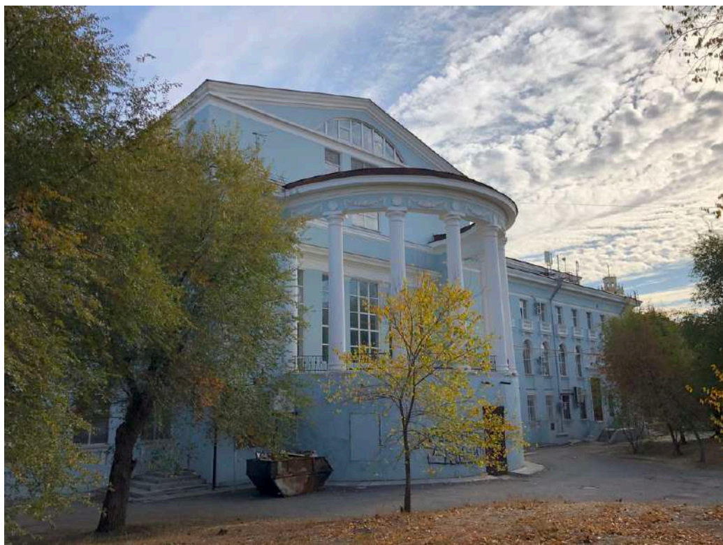
Фотография № 11.4. Здание по адресу пр-кт им. В.И. Ленина, д. 97.
