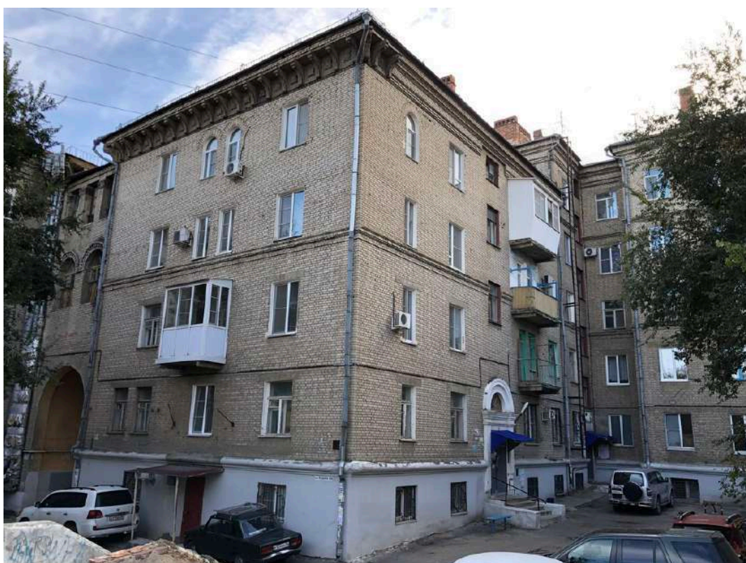
Фотография № 12.4. Здание по адресу пр-кт им. В.И. Ленина, д. 99.
