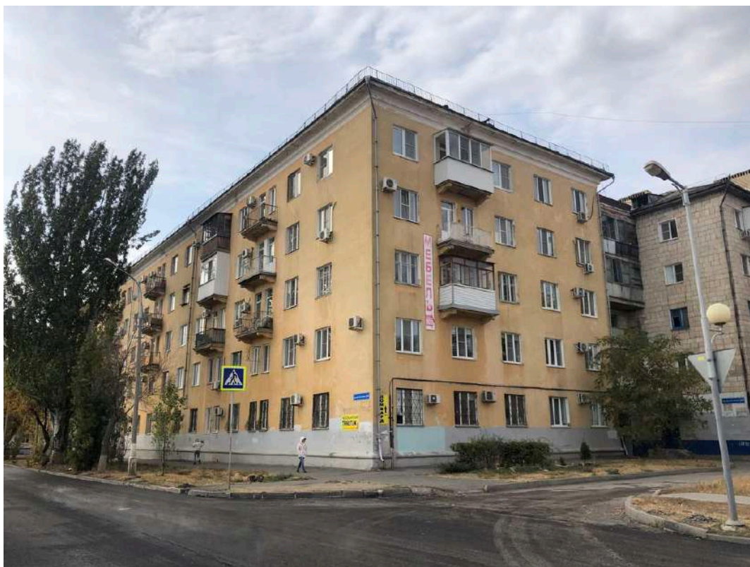
Фотография № 16.4. Здание по адресу пр-кт им. В.И. Ленина, д. 107.
