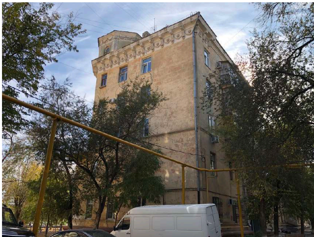
Фотография № 8.4. Здание по адресу пр-кт им. В.И. Ленина, д. 91.
