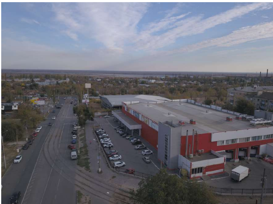
Аэрофотоснимок № 32. Объект незавершенного строительства и здание гипермаркета у перекрестка пр-кт им. В.И. Ленина и ул. им. Генерала Штеменко
