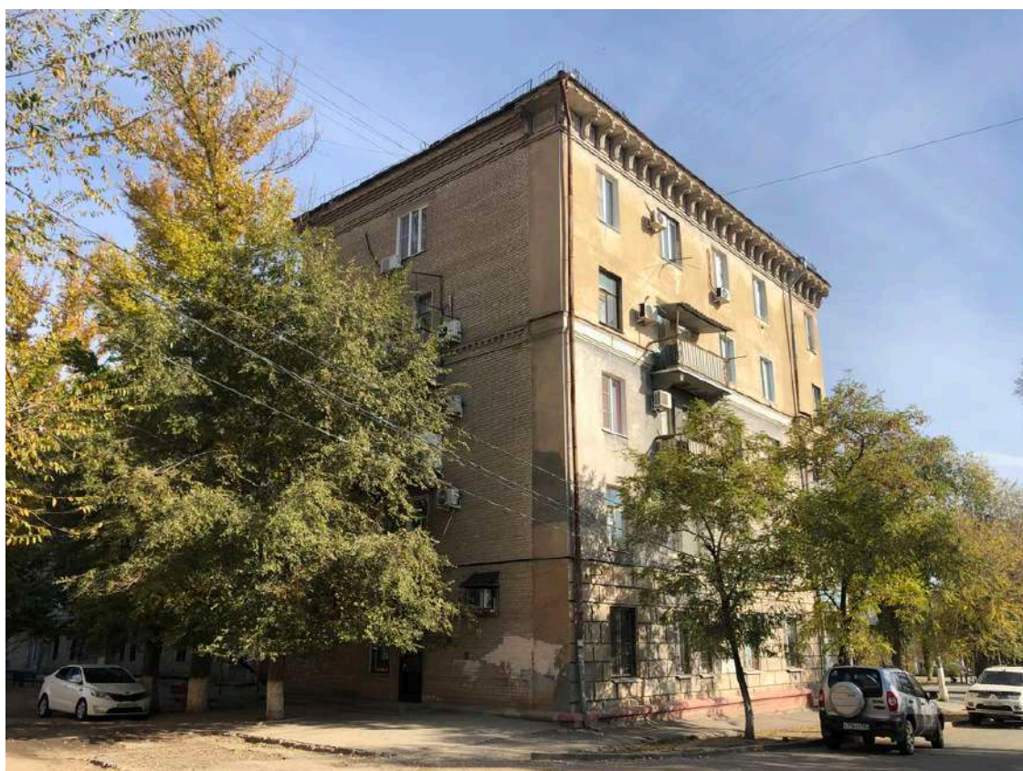
Фотография № 5.1. Здание по адресу пр-кт им. В.И. Ленина, д. 85.
