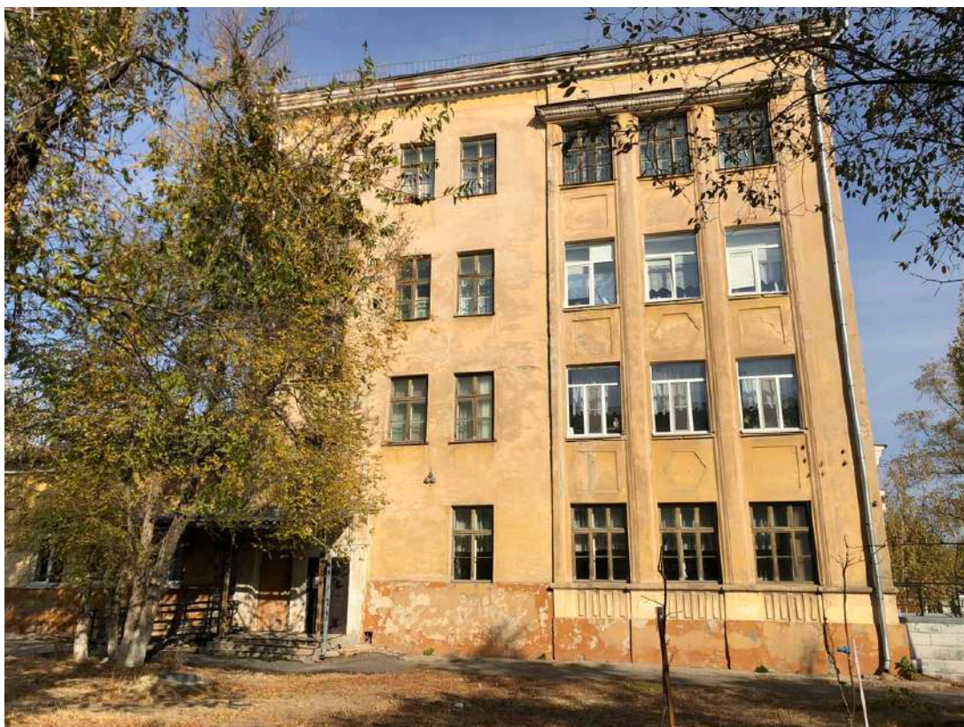
Фотография № 4.2. Здание по адресу пр-кт им. В.И. Ленина, д. 83.
