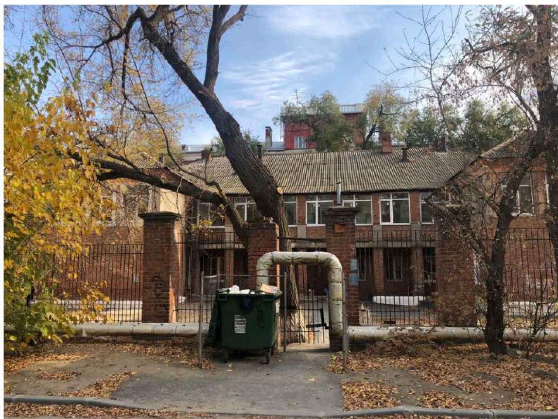
Фотография № 34.3. Здание по адресу просп. им. Ленина, д. 127а.
