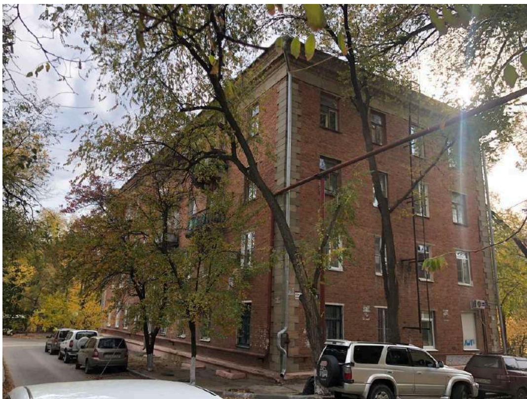
Фотография № 25.3. Здание по адресу ул. Гуртьева, д. 3.
