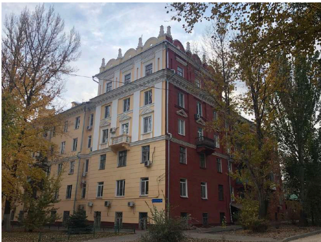
Фотография № 21.5. Здание по адресу пр-кт им. В.И. Ленина, д. 119.
