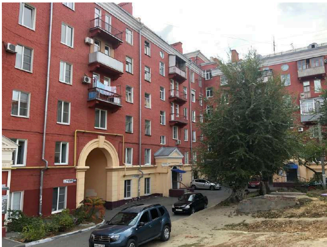
Фотография № 22.3. Здание по адресу пр-кт им. В.И. Ленина, д. 123.
