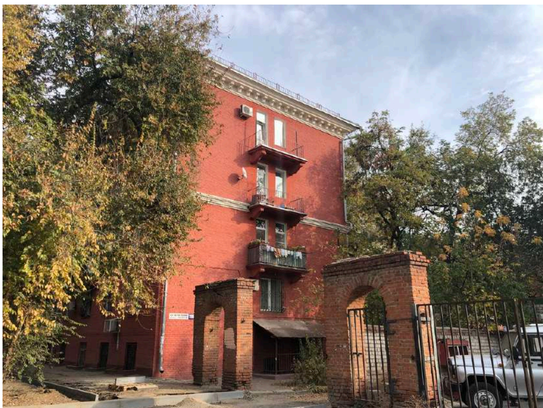
Фотография № 21.6. Здание по адресу пр-кт им. В.И. Ленина, д. 119.
