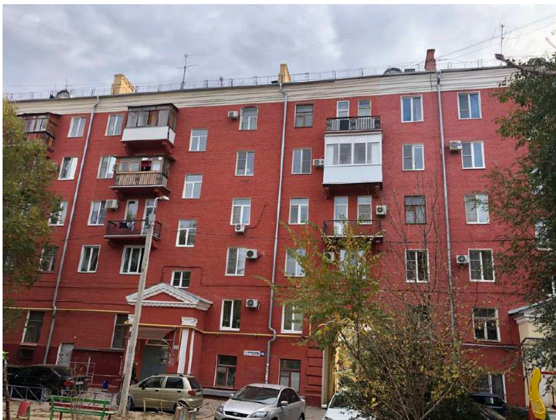
Фотография № 18.3. Здание по адресу пр-кт им. В.И. Ленина, д. 113.
