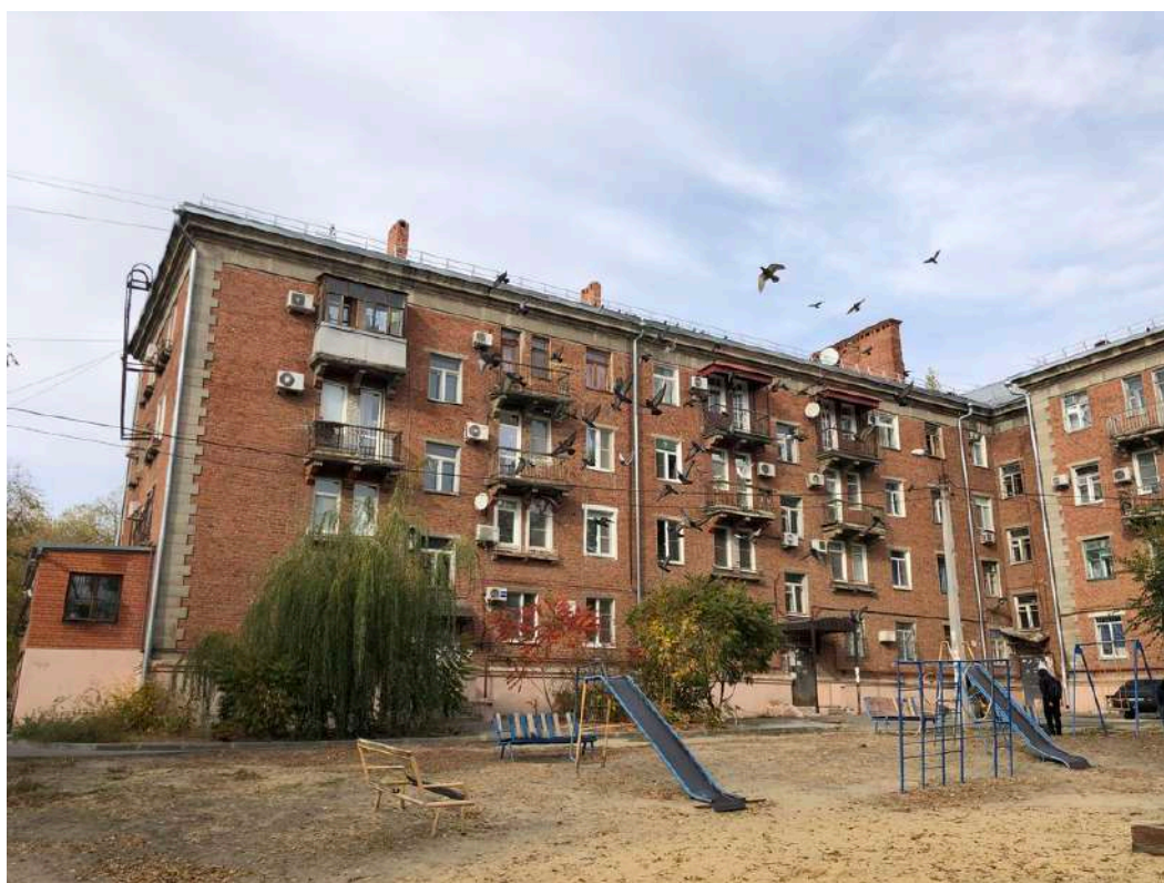
Фотография № 26.5. Здание по адресу Аэропортовский пер., д. 2.
