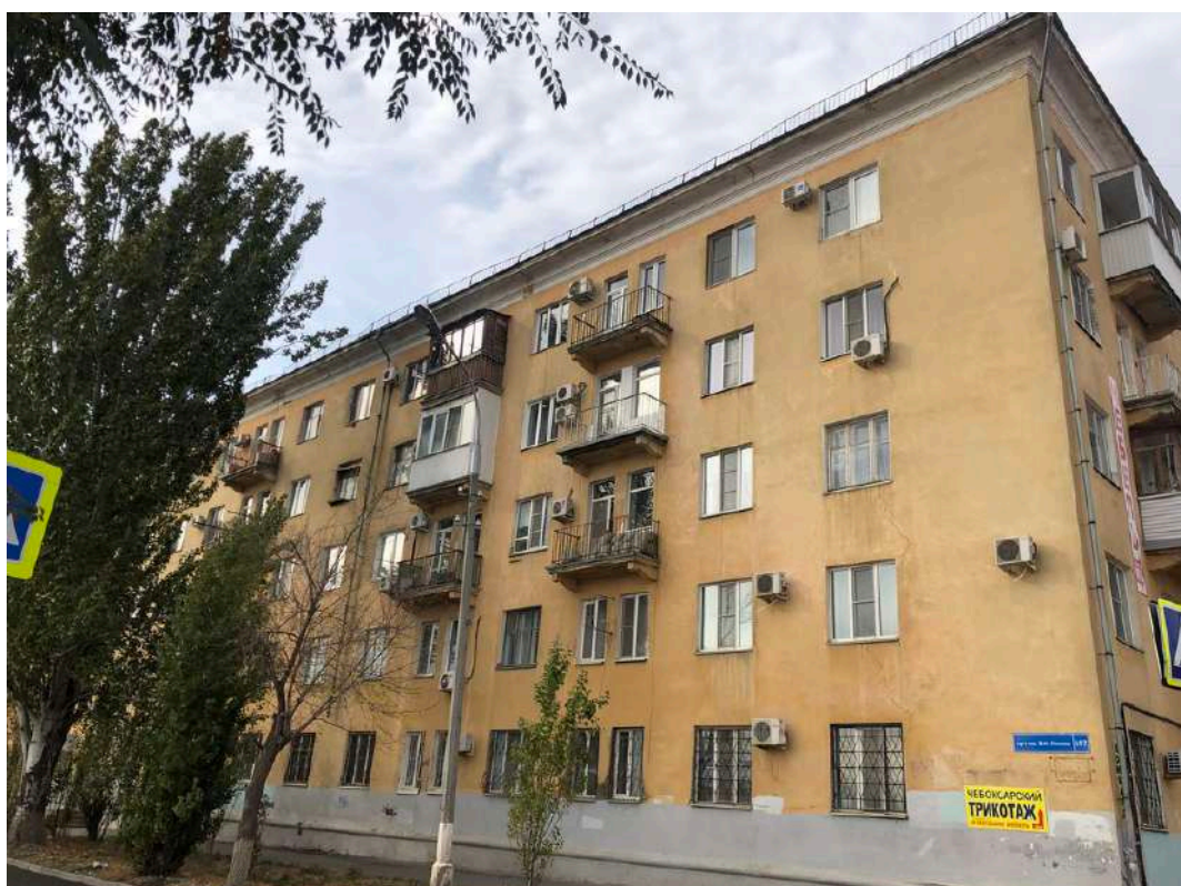
Фотография № 16.5. Здание по адресу пр-кт им. В.И. Ленина, д. 107.
