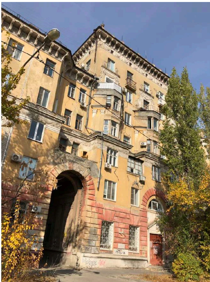
Фотография № 3.1. Здание по адресу пр-кт им. В.И. Ленина, д. 81.
