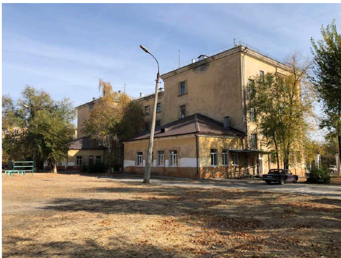
Фотография № 4.1. Здание по адресу пр-кт им. В.И. Ленина, д. 83.
