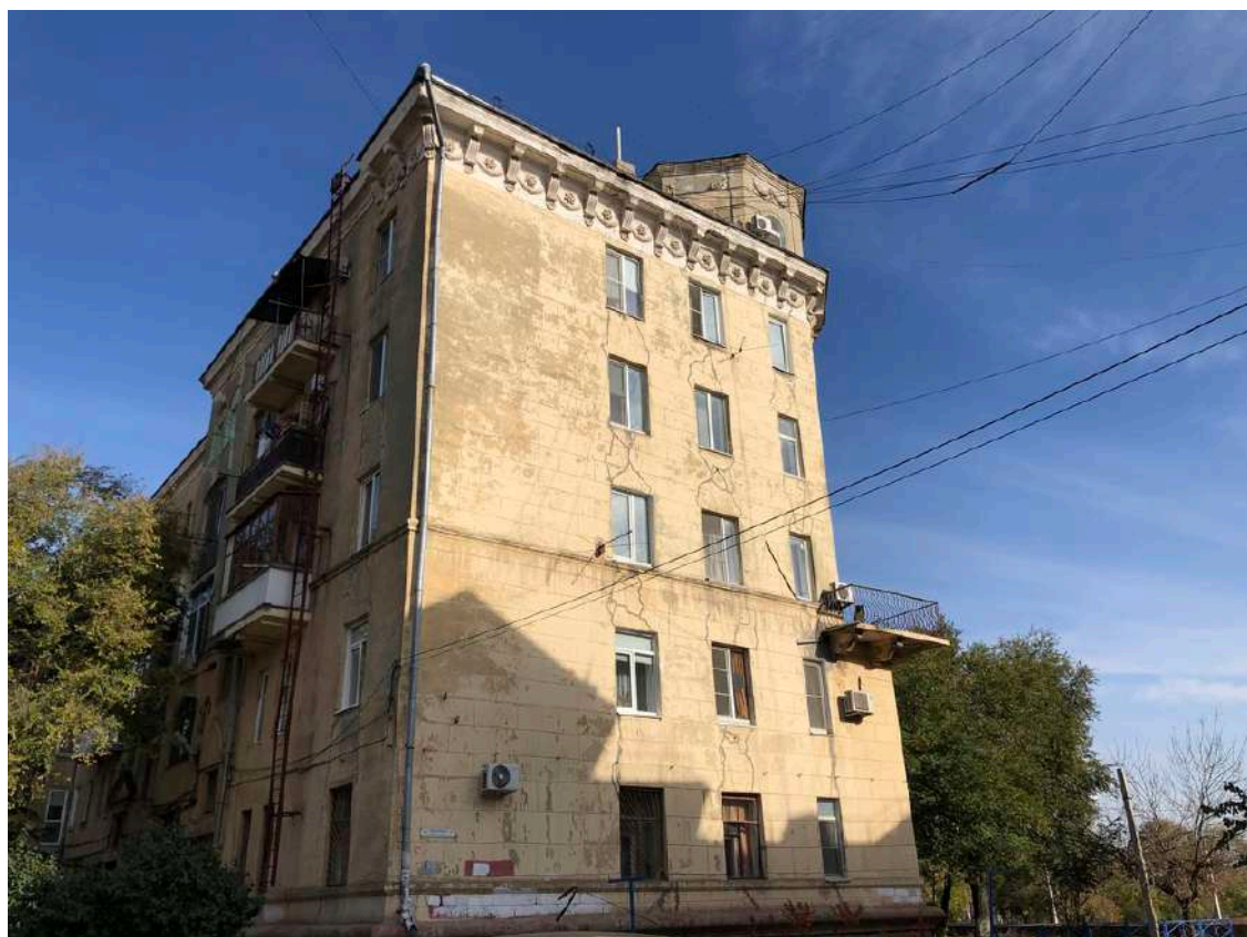
Фотография № 8.1. Здание по адресу пр-кт им. В.И. Ленина, д. 91.
