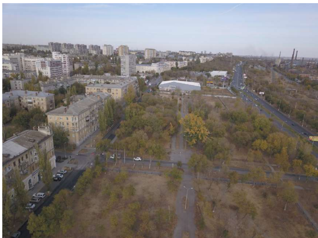
Аэрофотоснимок № 24. Вид на застройку пр-кт им. В.И. Ленина (д. 103, 105, 107) и пустырь с объектом незавершенного строительства на перекрестке ул. Генерала Штеменко и просп. им. Ленина
