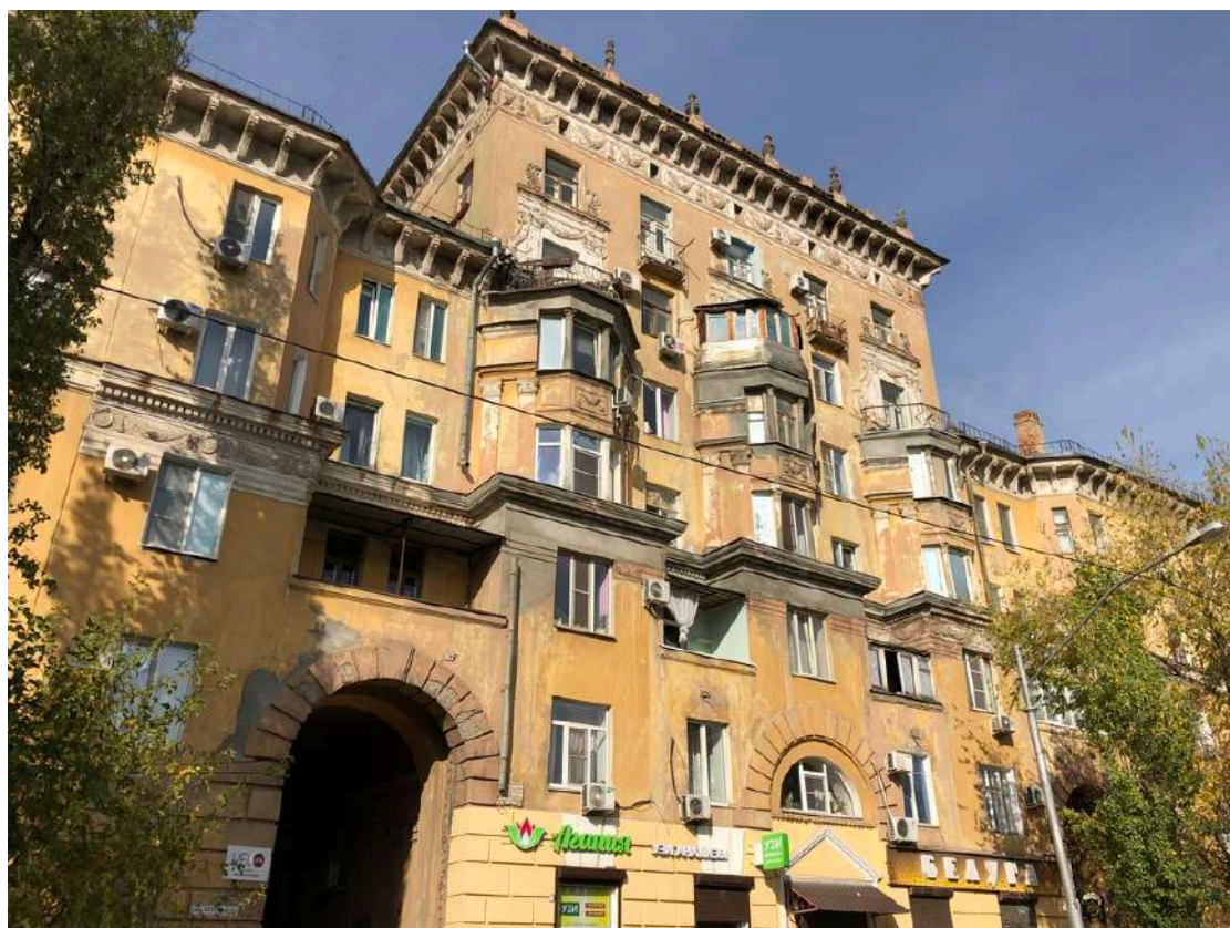
Фотография № 1.4. Здание по адресу пр-кт им. В.И. Ленина, д. 79.
