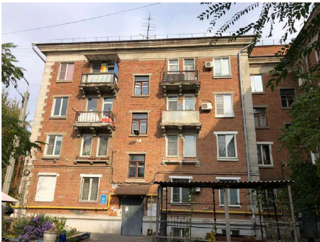
Фотография № 29.1. Здание по адресу ул. Титова, д. 4.
