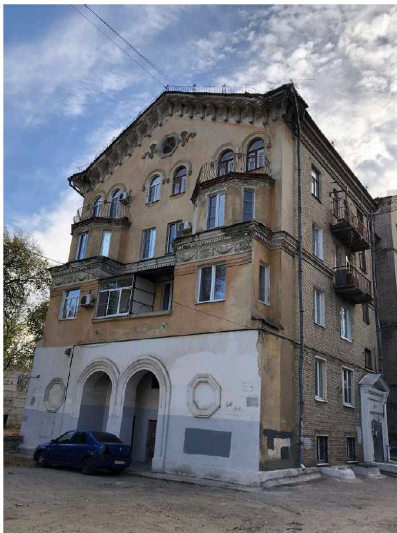
Фотография № 13.2. Здание по адресу пр-кт им. В.И. Ленина, д. 101.
