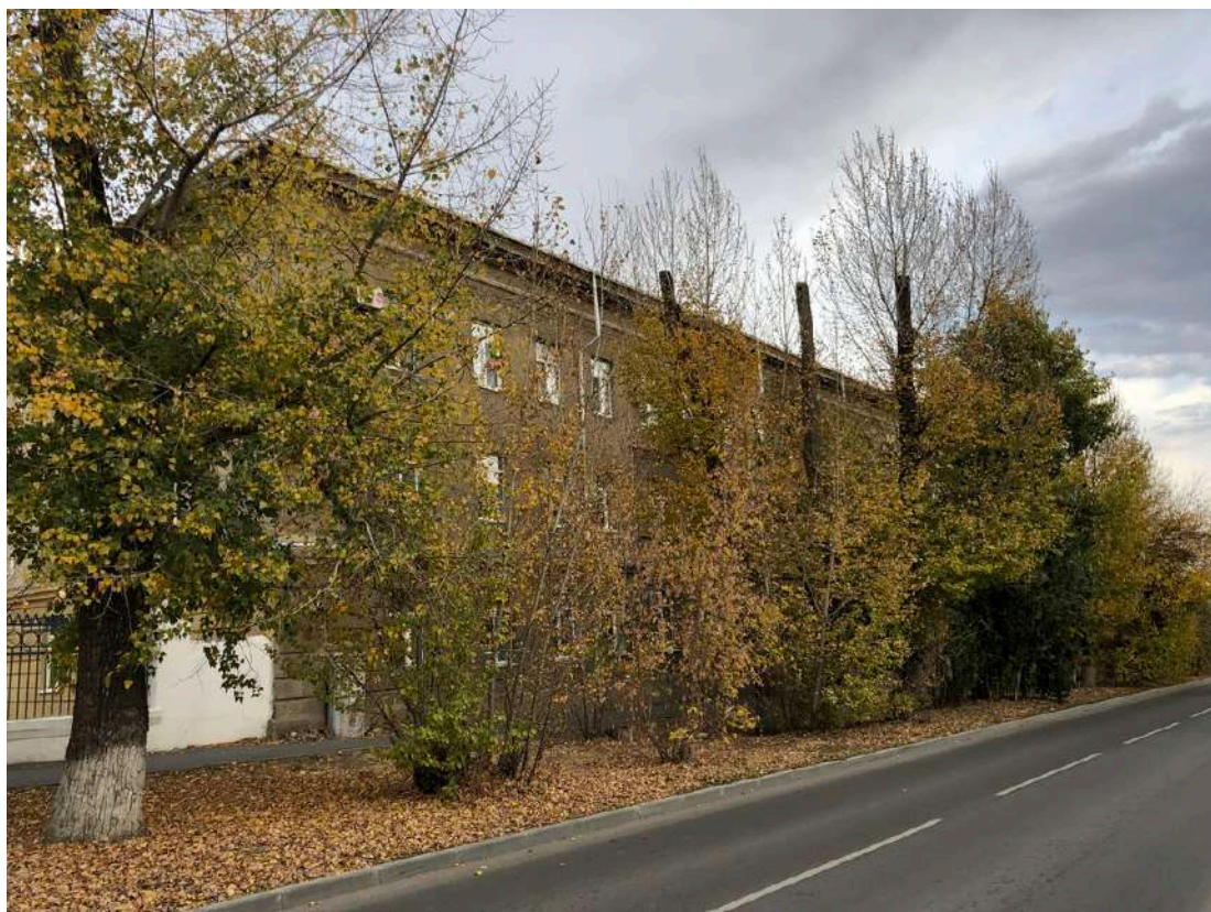
Фотография № 44.3. Здание по адресу ул. Пельшие, д. 2, корп. 1.
