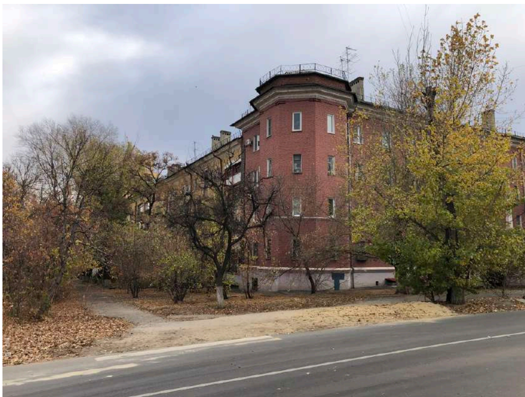
Фотография № 42.1. Здание по адресу ул. Гуртьева, д. 4.
