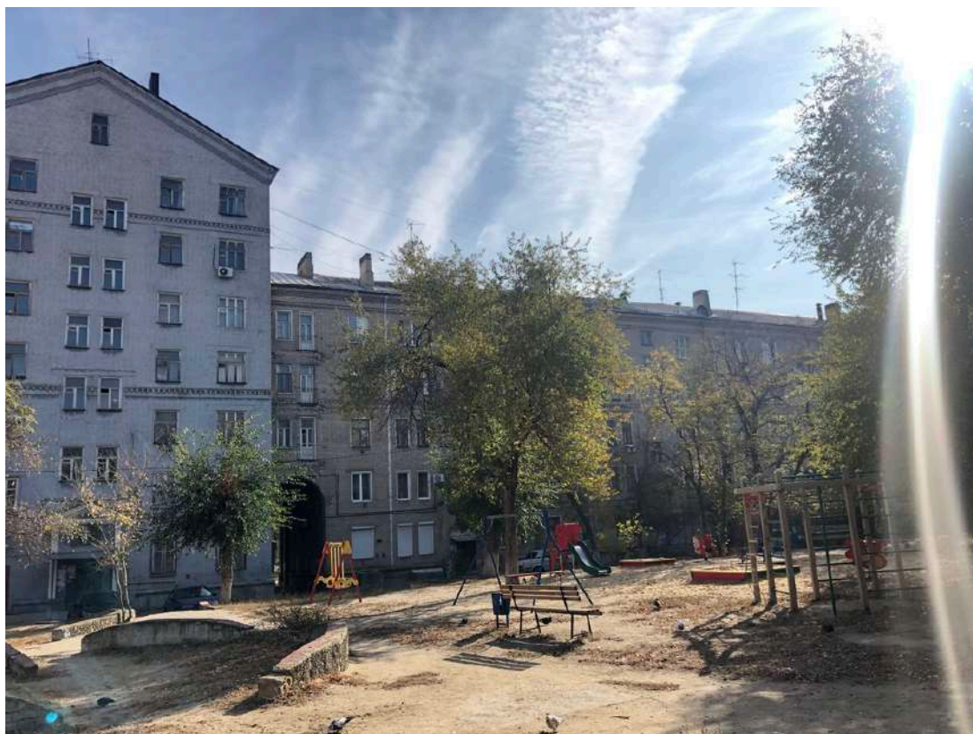
Фотография № 5.3. Здание по адресу пр-кт им. В.И. Ленина, д. 85.
