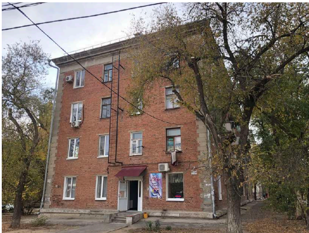
Фотография № 27.3. Здание по адресу Аэропортовский пер., д. 6.
