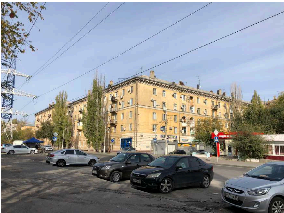
Фотография № 1.1. Здание по адресу пр-кт им. В.И. Ленина, д. 79.
