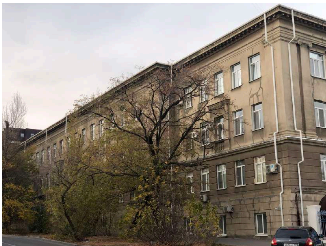
Фотография № 44.2. Здание по адресу ул. Пельше, д. 2, корп. 1.
