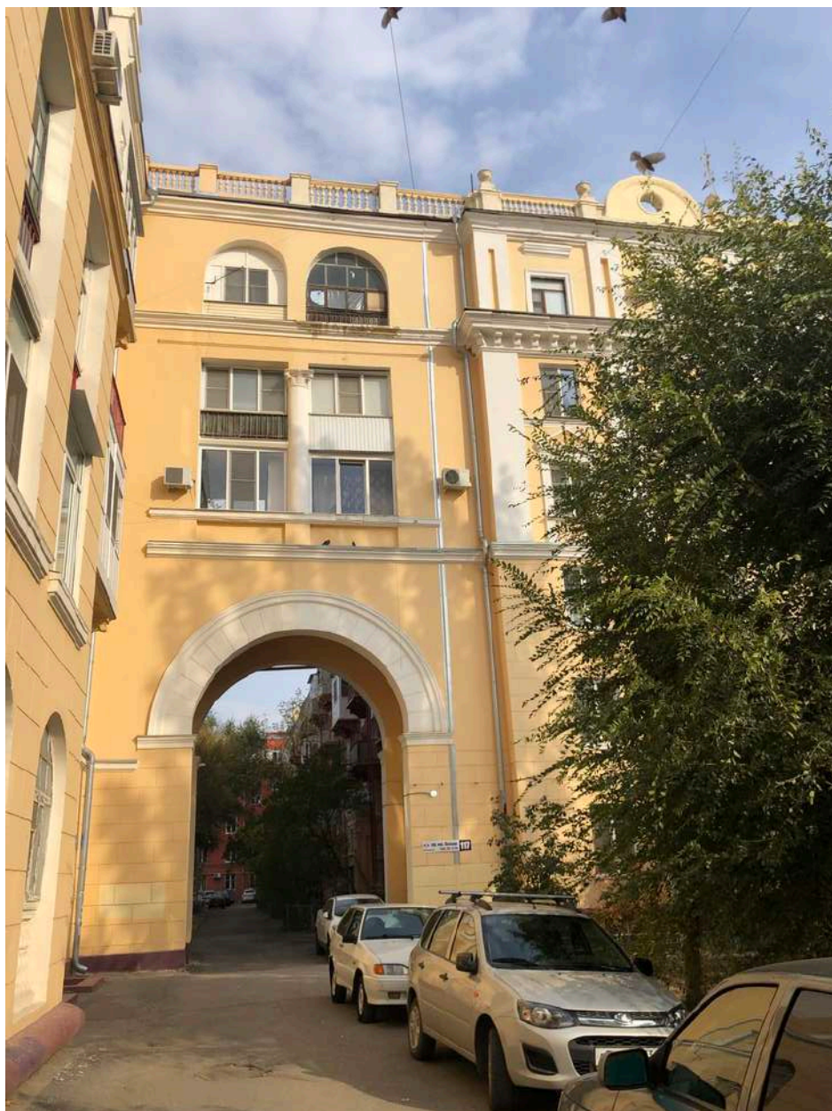
Фотография № 20.4. Здание по адресу пр-кт им. В.И. Ленина, д. 117.
