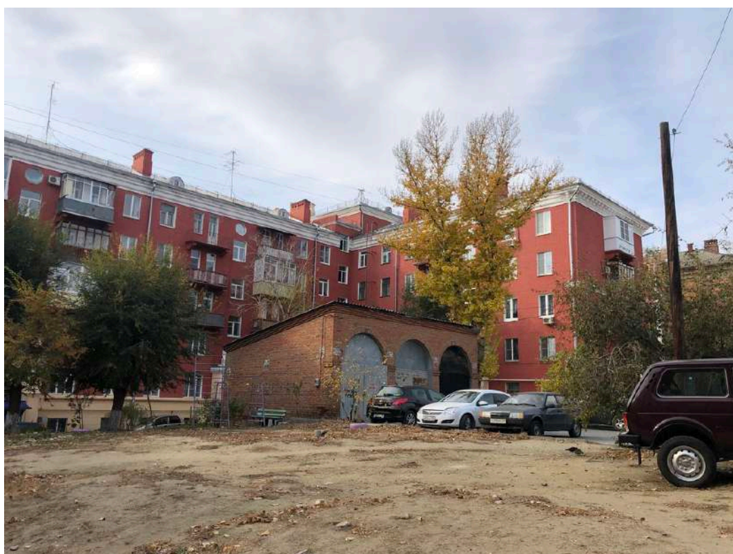
Фотография № 22.4. Здание по адресу пр-кт им. В.И. Ленина, д. 123.
