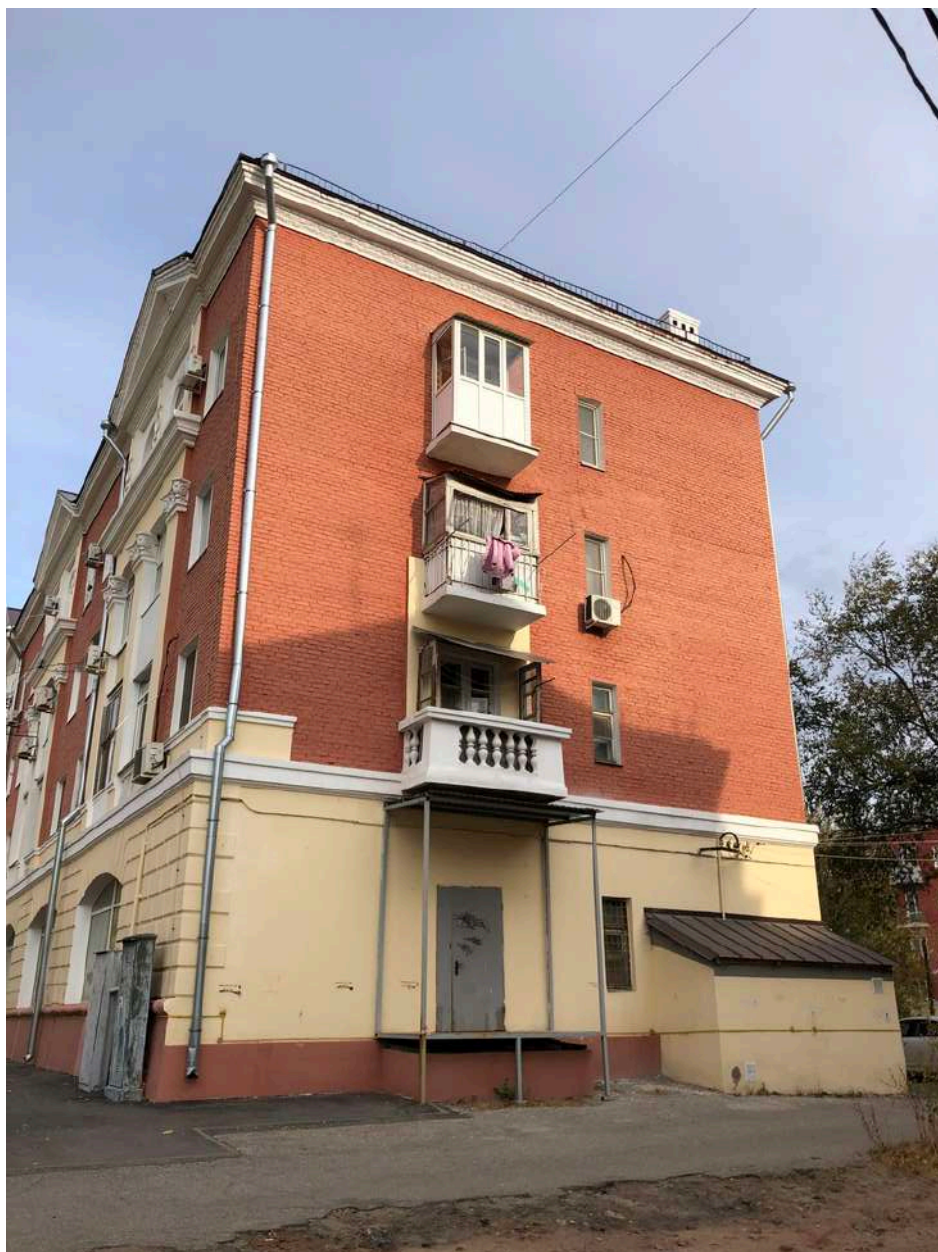
Фотография № 39.3. Здание по адресу ул. Гуртьева, д. 2.
