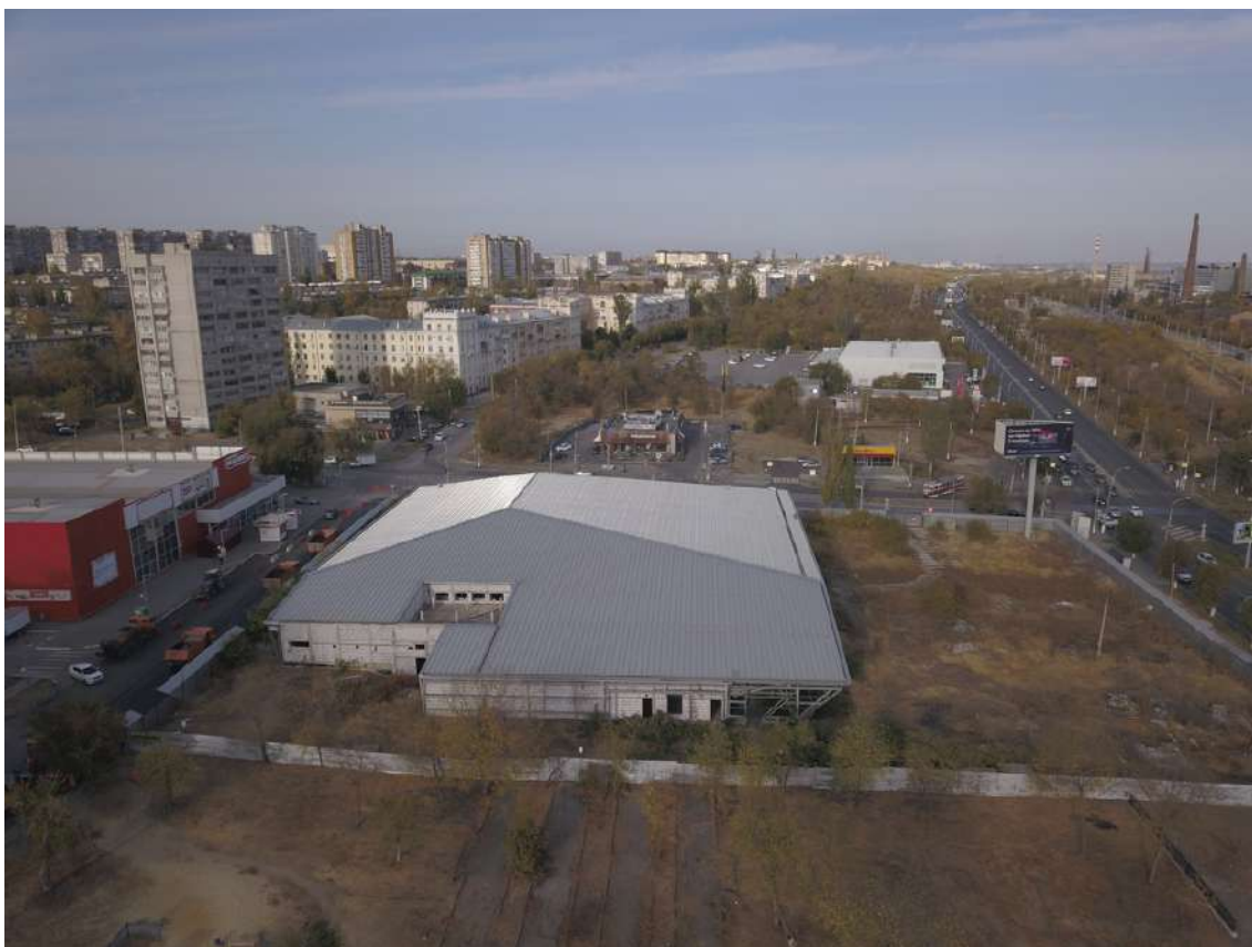
Аэрофотоснимок № 31. Объект незавершенного строительства на пустыре у перекрестка пр-кт им. В.И. Ленина и ул. им. Генерала Штеменко
