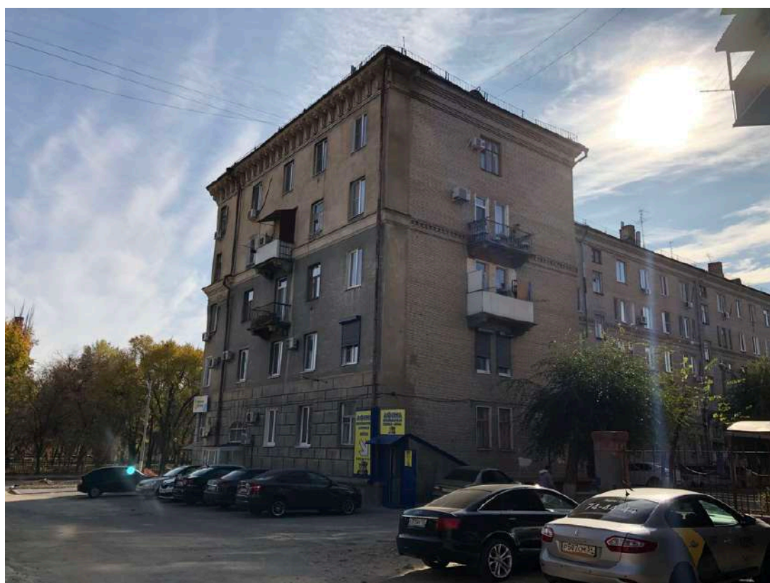
Фотография № 6.2. Здание по адресу пр-кт им. В.И. Ленина, д. 87.
