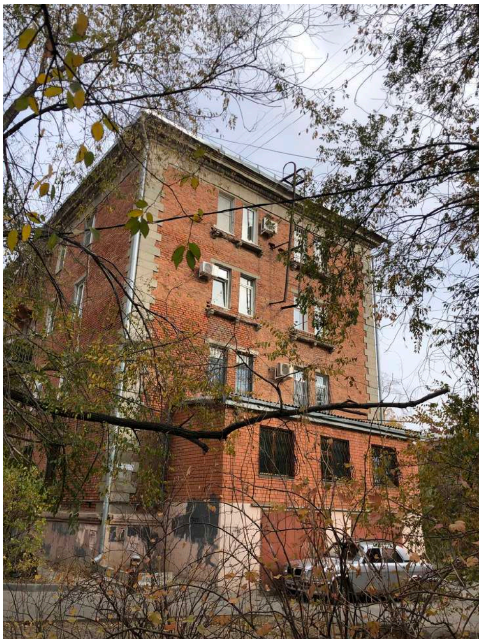
Фотография № 26.3. Здание по адресу Аэропортовский пер., д. 2.
