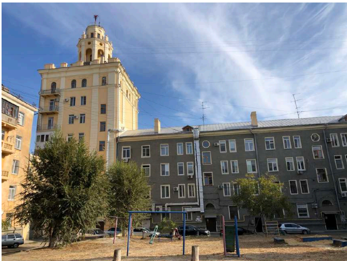
Фотография № 9.5. Здание по адресу пр-кт им. В.И. Ленина, д. 93.
