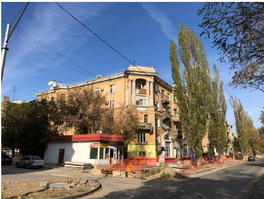
Фотография № 7.1. Здание по адресу пр-кт им. В.И. Ленина, д. 89.
