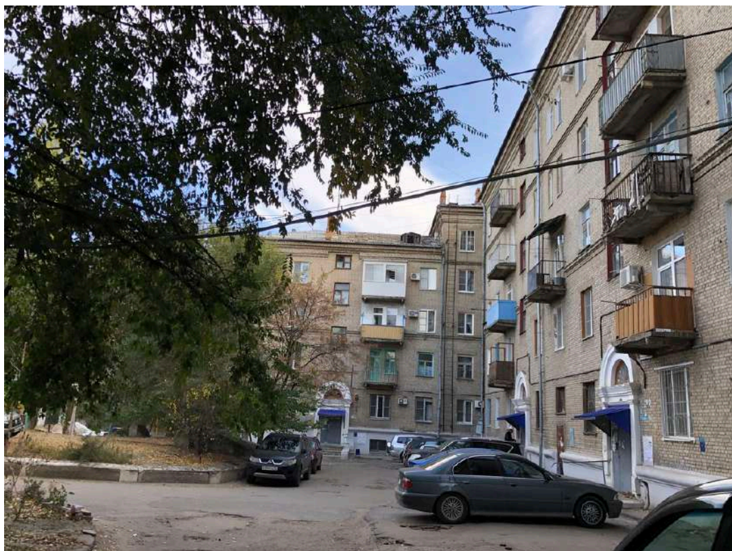
Фотография № 12.3. Здание по адресу пр-кт им. В.И. Ленина, д. 99.
