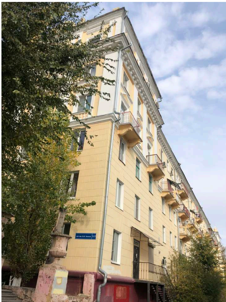
Фотография № 20.5. Здание по адресу пр-кт им. В.И. Ленина, д. 117.
