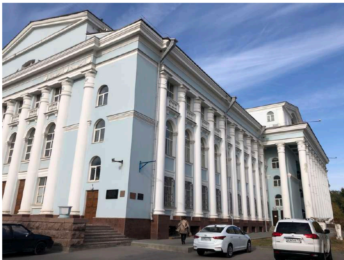
Фотография № 11.1. Здание по адресу пр-кт им. В.И. Ленина, д. 97.
