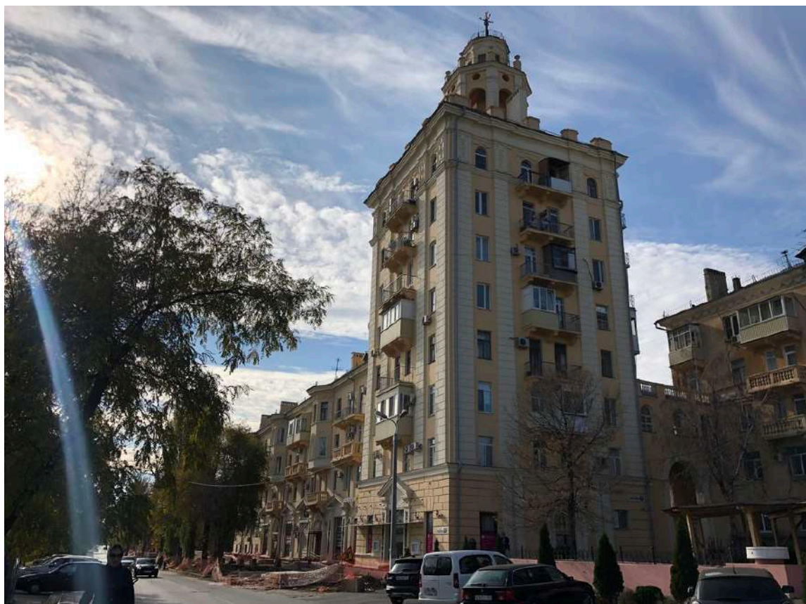
Фотография № 9.2. Здание по адресу пр-кт им. В.И. Ленина, д. 93.
