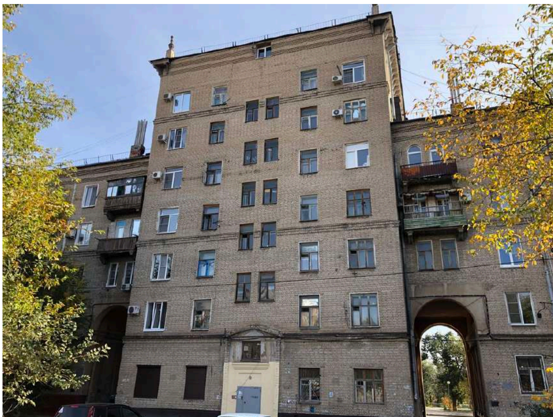
Фотография № 3.4. Здание по адресу пр-кт им. В.И. Ленина, д. 81.
