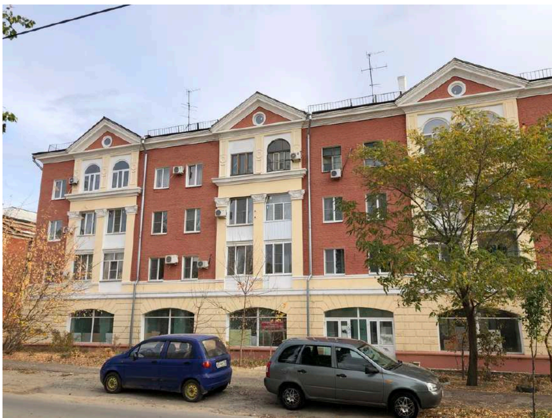
Фотография № 39.2. Здание по адресу ул. Гуртьева, д. 2.
