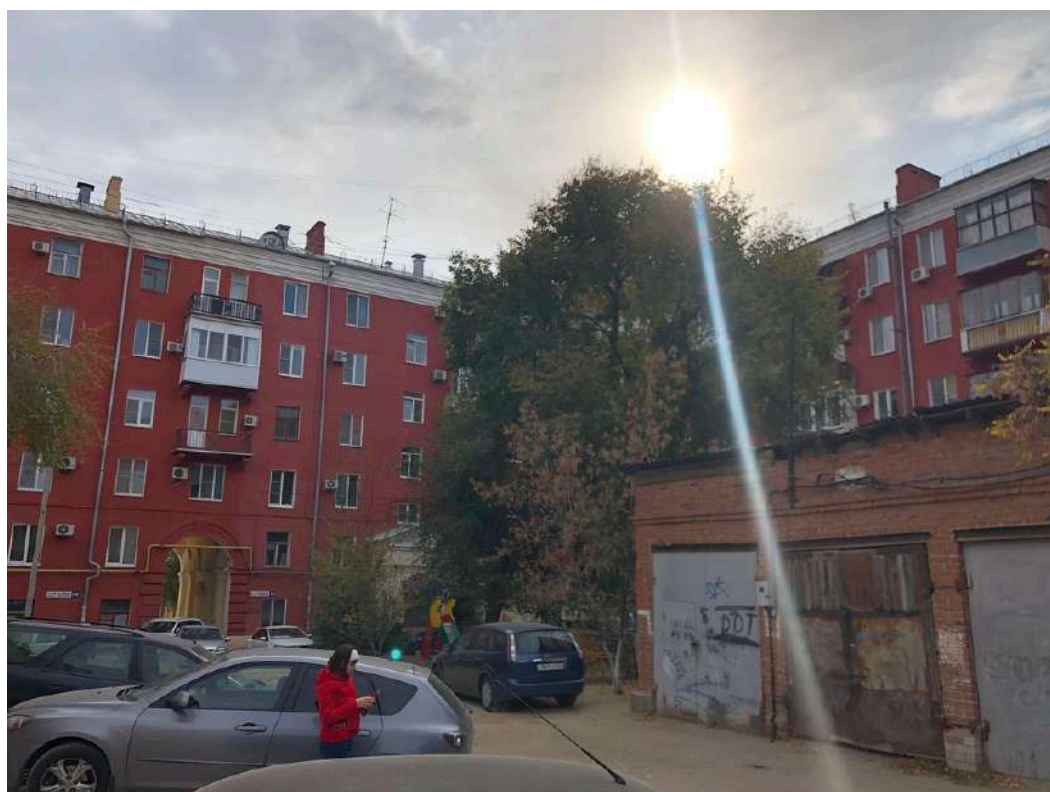
Фотография № 17.4. Здание по адресу пр-кт им. В.И. Ленина, д. 111.
