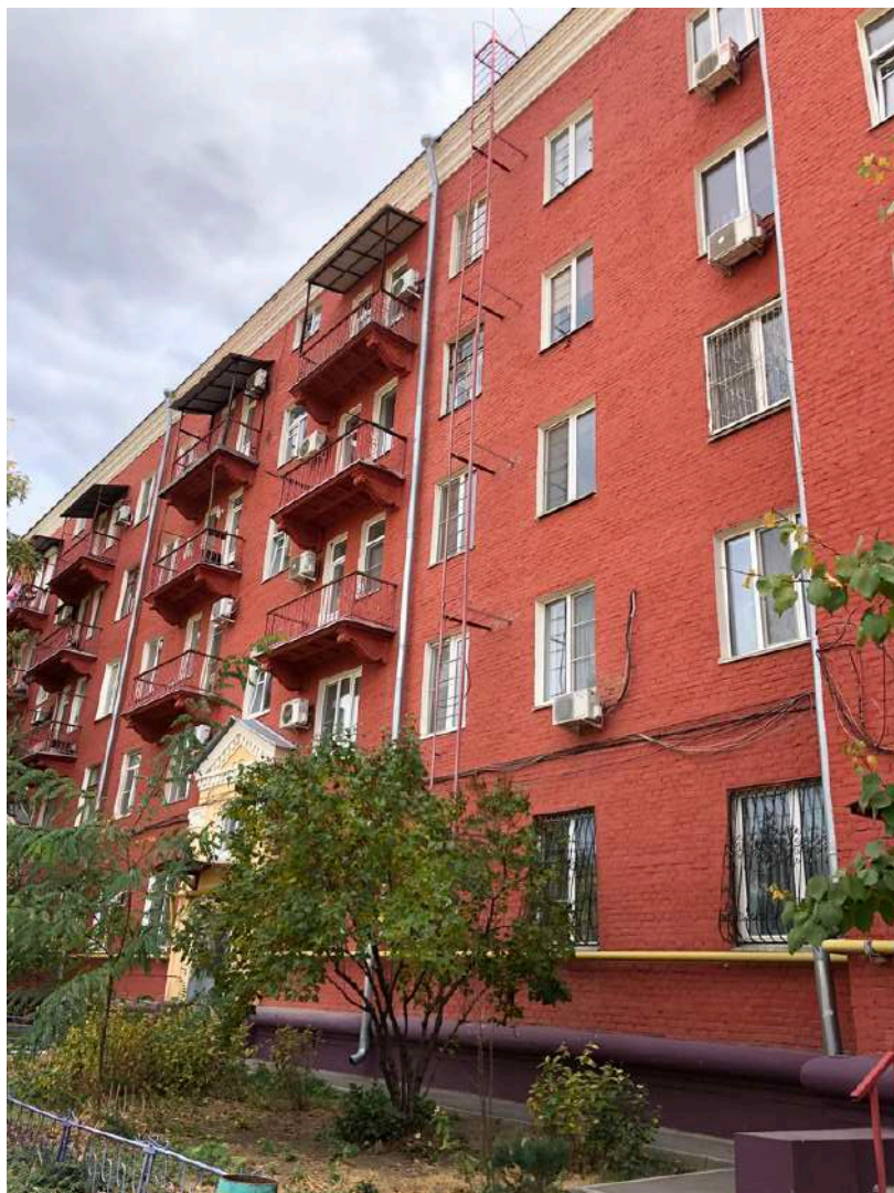
Фотография № 19.2. Здание по адресу пр-кт им. В.И. Ленина, д. 115.
