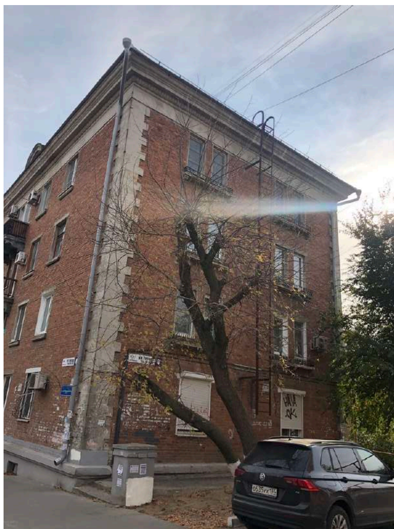
Фотография № 29.4. Здание по адресу ул. Титова, д. 4.
