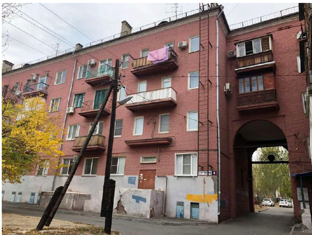
Фотография № 42.4. Здание по адресу ул. Гуртьева, д. 4.
