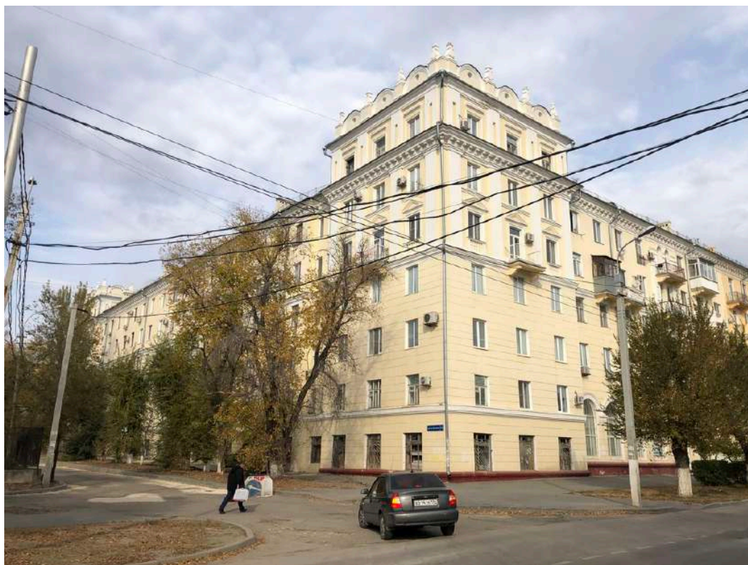
Фотография № 17.1. Здание по адресу пр-кт им. В.И. Ленина, д. 111.
