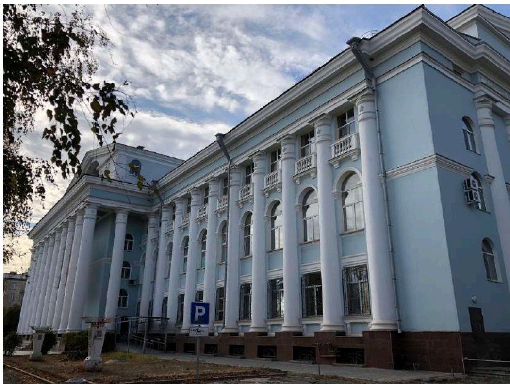
Фотография № 11.5. Здание по адресу пр-кт им. В.И. Ленина, д. 97.
