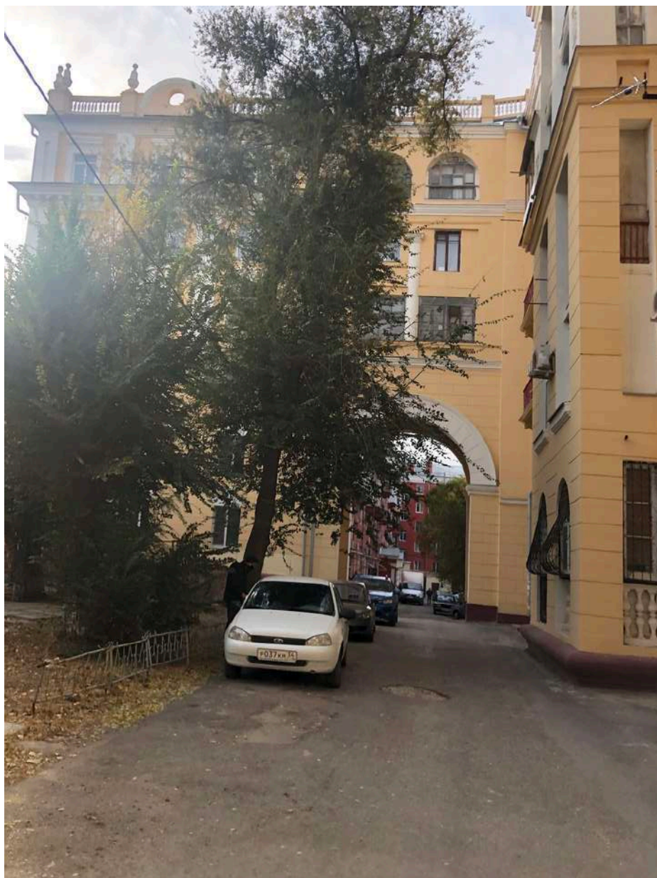
Фотография № 19.4. Здание по адресу пр-кт им. В.И. Ленина, д. 115.
