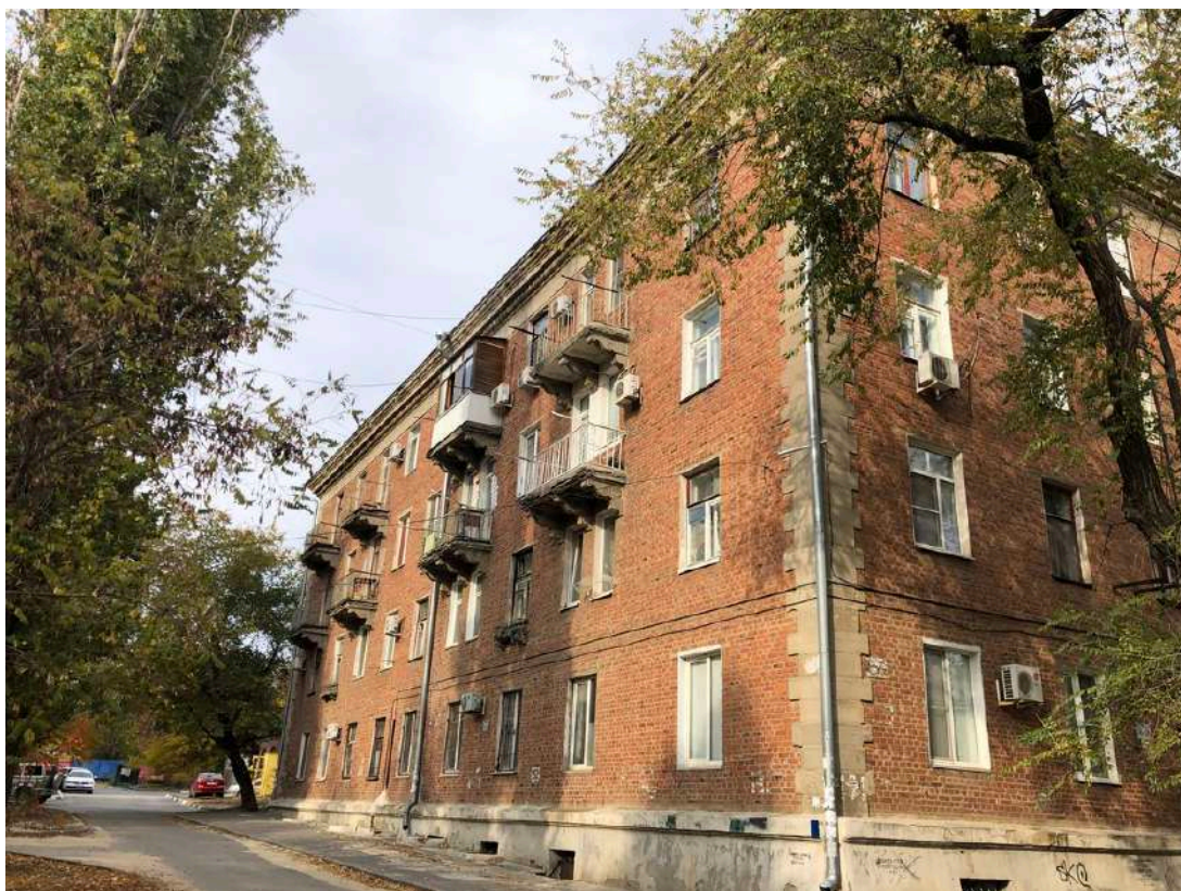
Фотография № 27.1. Здание по адресу Аэропортовский пер., д. 6.
