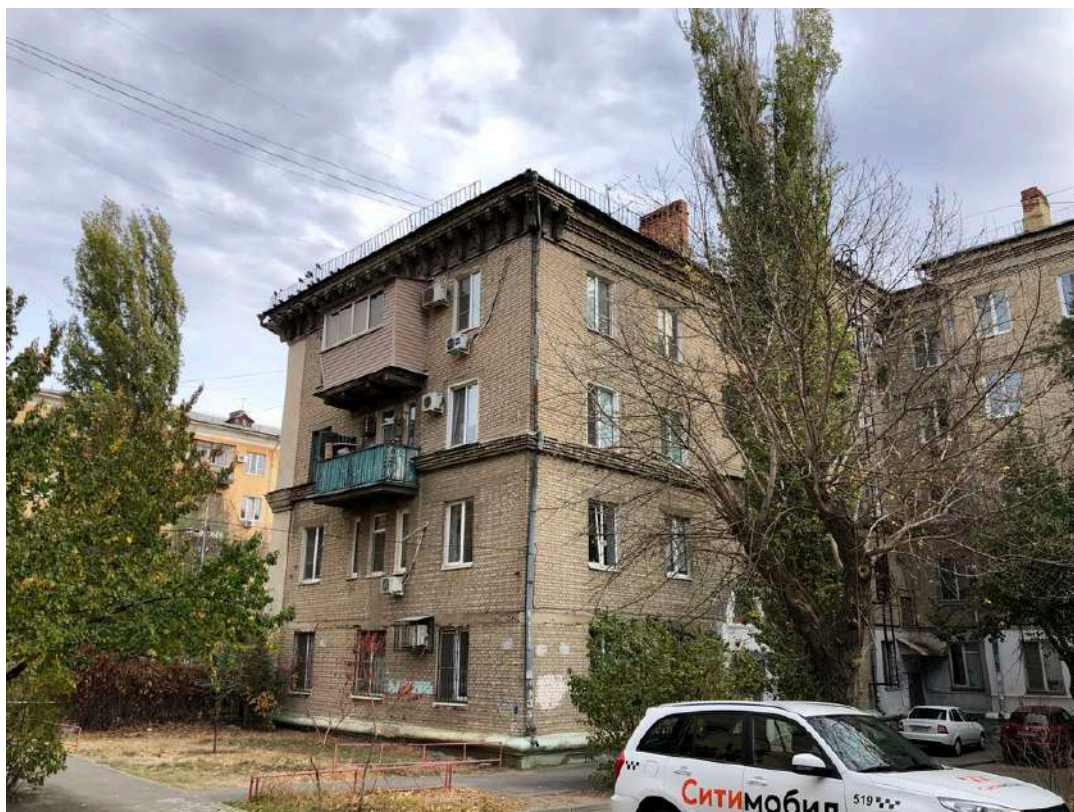
Фотография № 15.2. Здание по адресу пр-кт им. В.И. Ленина, д. 105.
