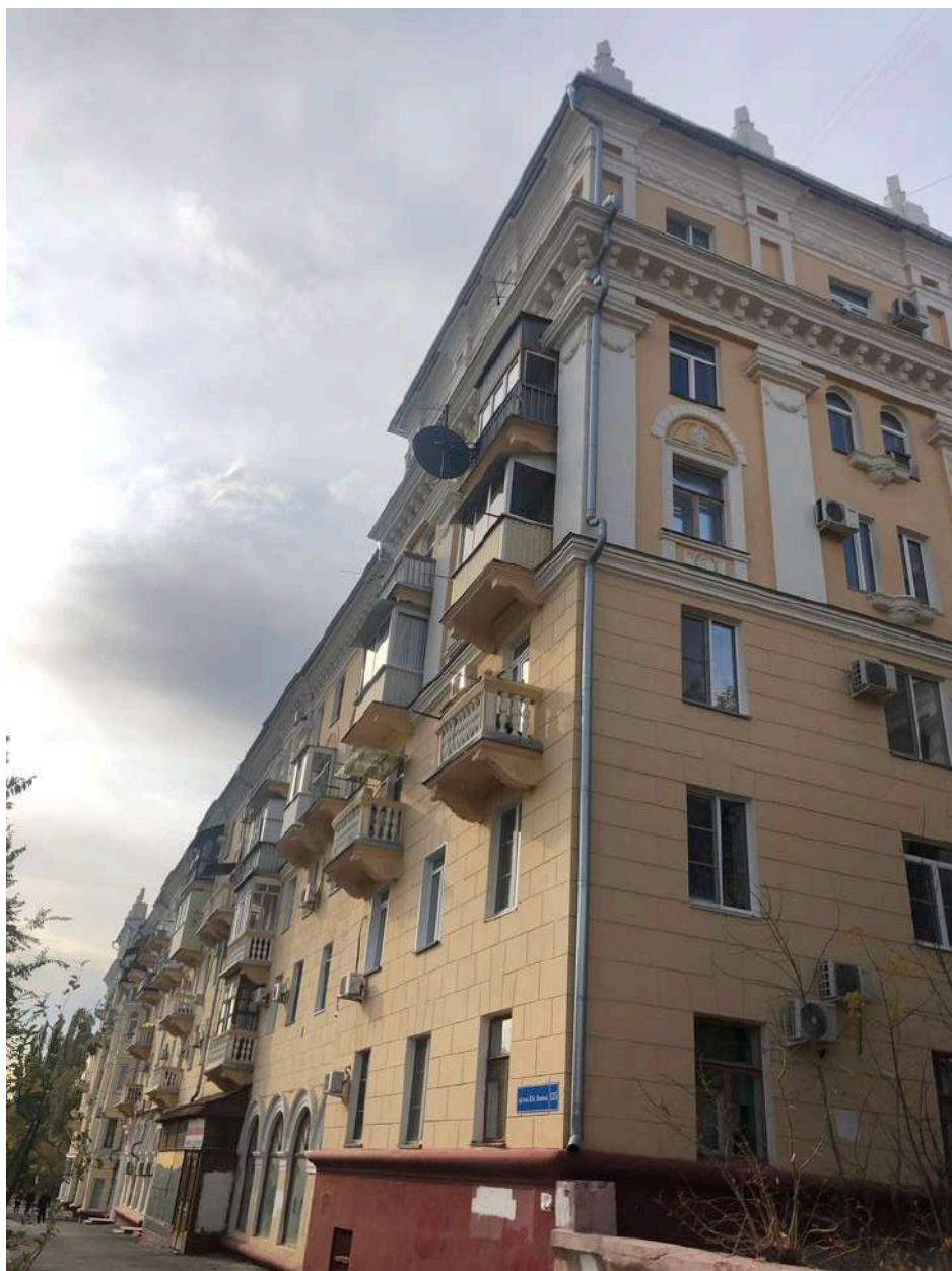
Фотография № 23.4. Здание по адресу пр-кт им. В.И. Ленина, д. 125.
