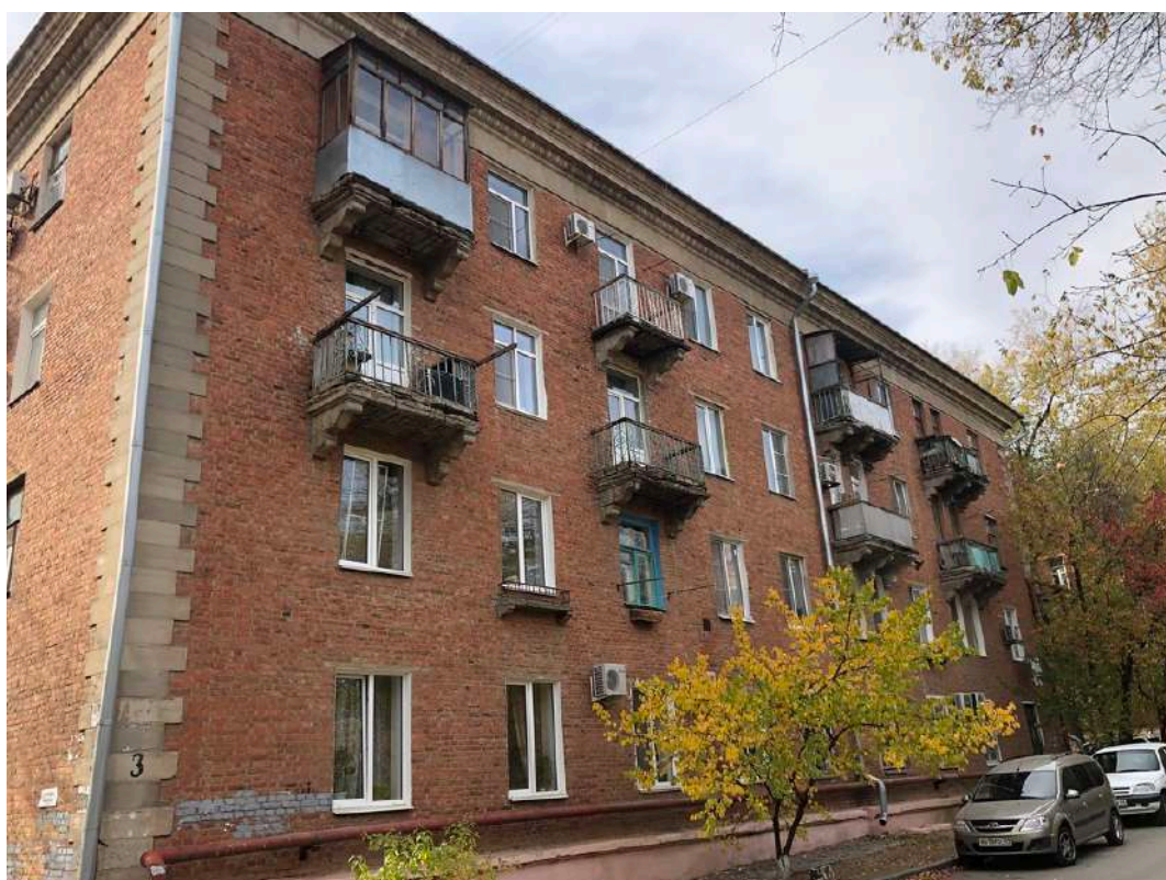
Фотография № 25.2. Здание по адресу ул. Гуртьева, д. 3.
