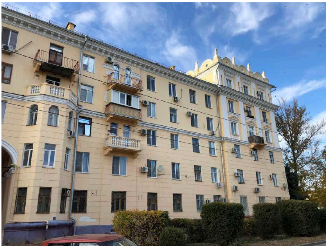
Фотография № 20.2. Здание по адресу пр-кт им. В.И. Ленина, д. 117.
