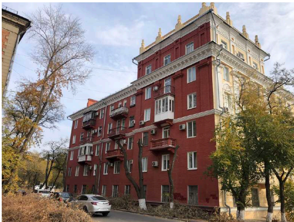
Фотография № 22.5. Здание по адресу пр-кт им. В.И. Ленина, д. 123.
