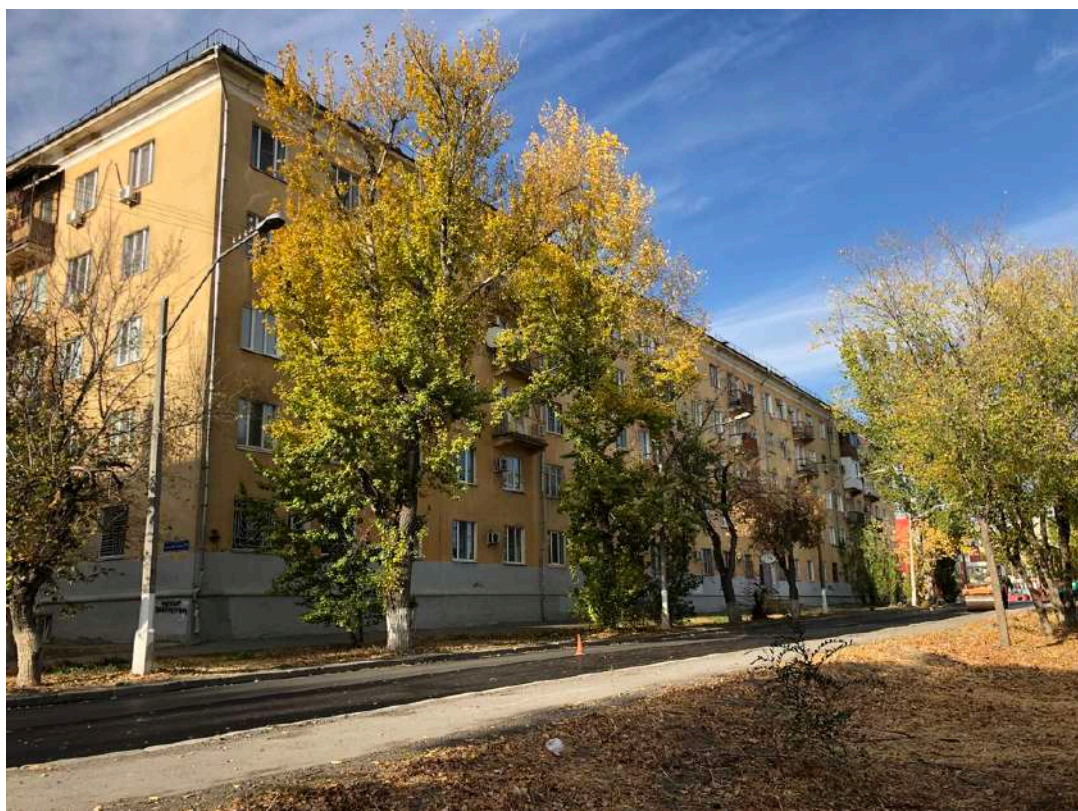
Фотография № 16.1. Здание по адресу пр-кт им. В.И. Ленина, д. 107.
