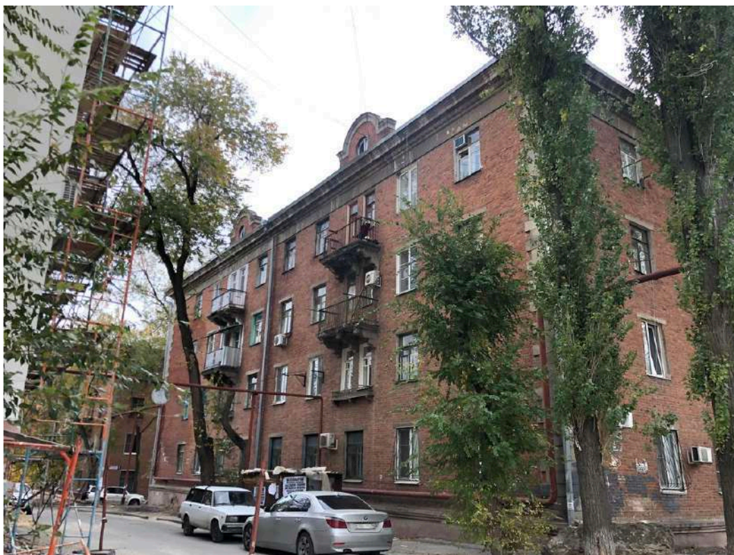
Фотография № 26.2. Здание по адресу Аэропортовский пер., д. 2.
