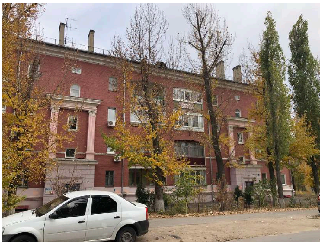
Фотография № 42.2. Здание по адресу ул. Гуртьева, д. 4.
