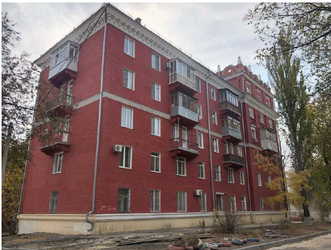
Фотография № 17.3. Здание по адресу пр-кт им. В.И. Ленина, д. 111.
