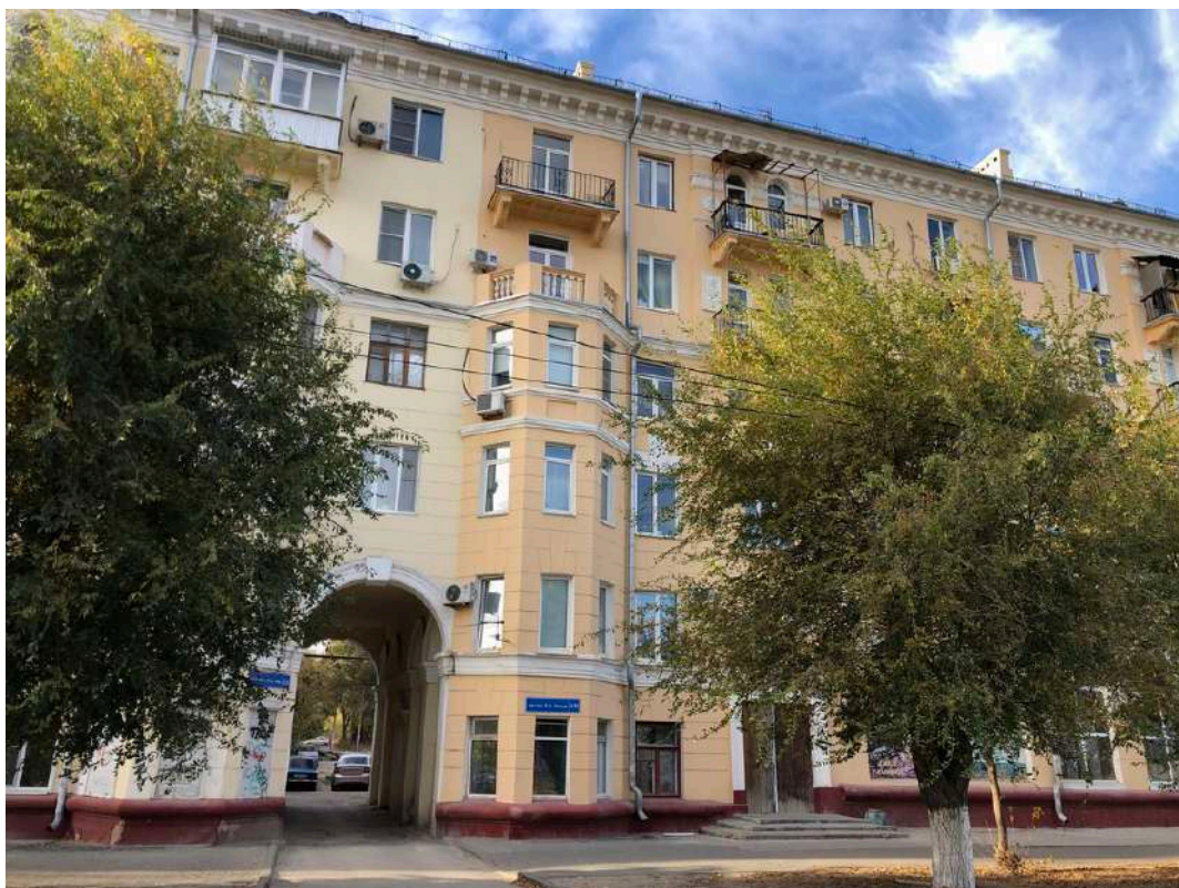
Фотография № 18.1. Здание по адресу пр-кт им. В.И. Ленина, д. 113.
