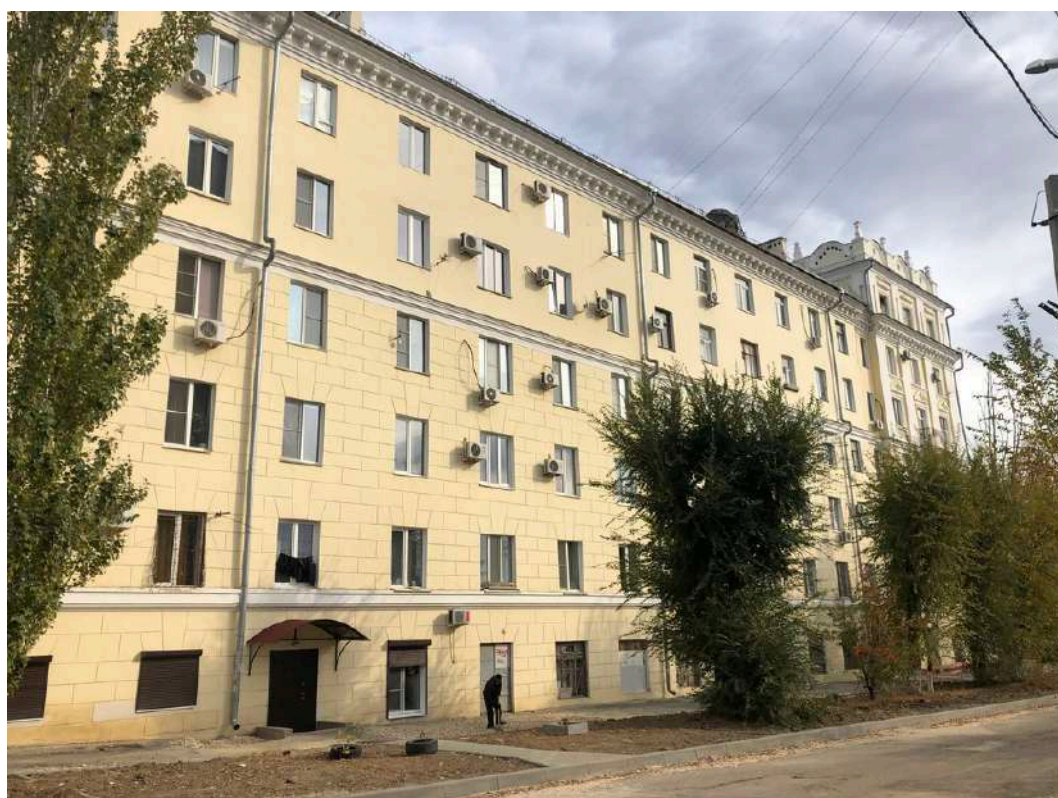
Фотография № 17.2. Здание по адресу пр-кт им. В.И. Ленина, д. 111.
