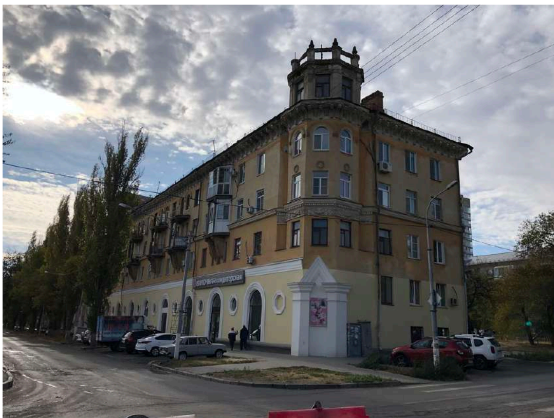
Фотография № 14.3. Здание по адресу пр-кт им. В.И. Ленина, д. 103.
