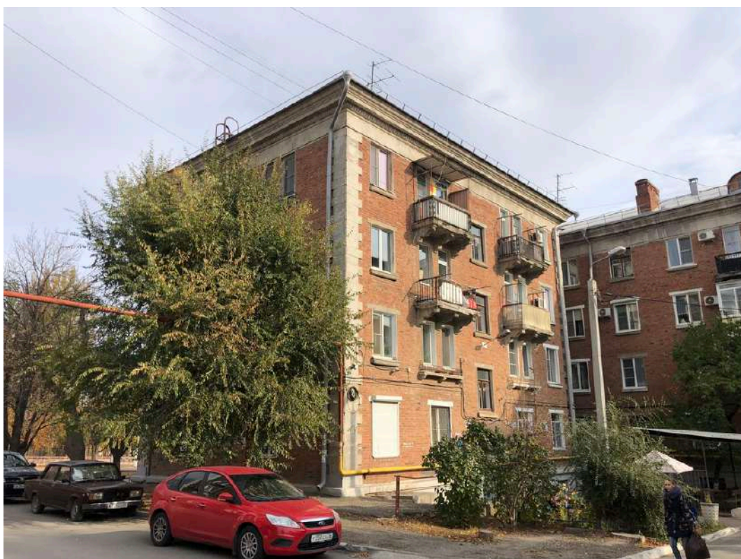
Фотография № 29.2. Здание по адресу ул. Титова, д. 4.
