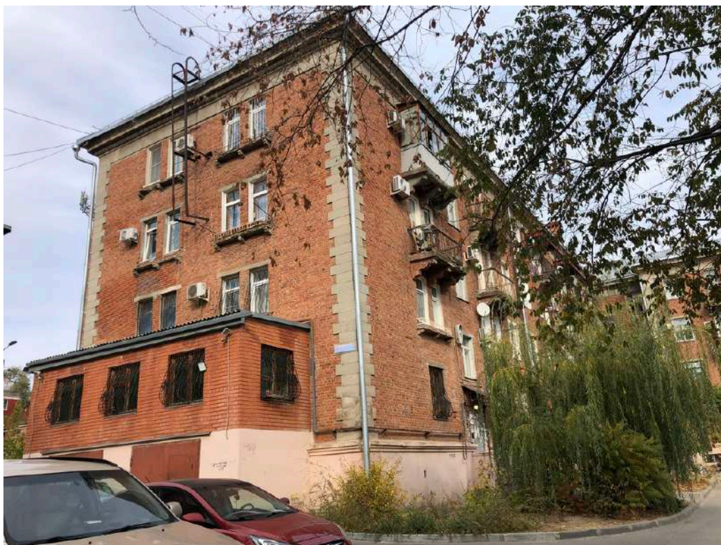
Фотография № 26.4. Здание по адресу Аэропортовский пер., д. 2.
