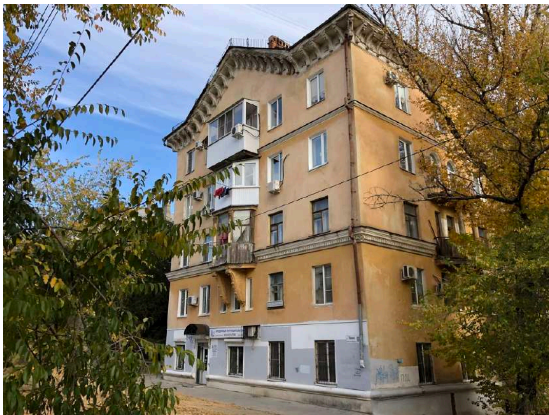
Фотография № 12.1. Здание по адресу пр-кт им. В.И. Ленина, д. 99.
