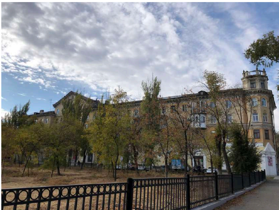
Фотография № 14.2. Здание по адресу пр-кт им. В.И. Ленина, д. 103.
