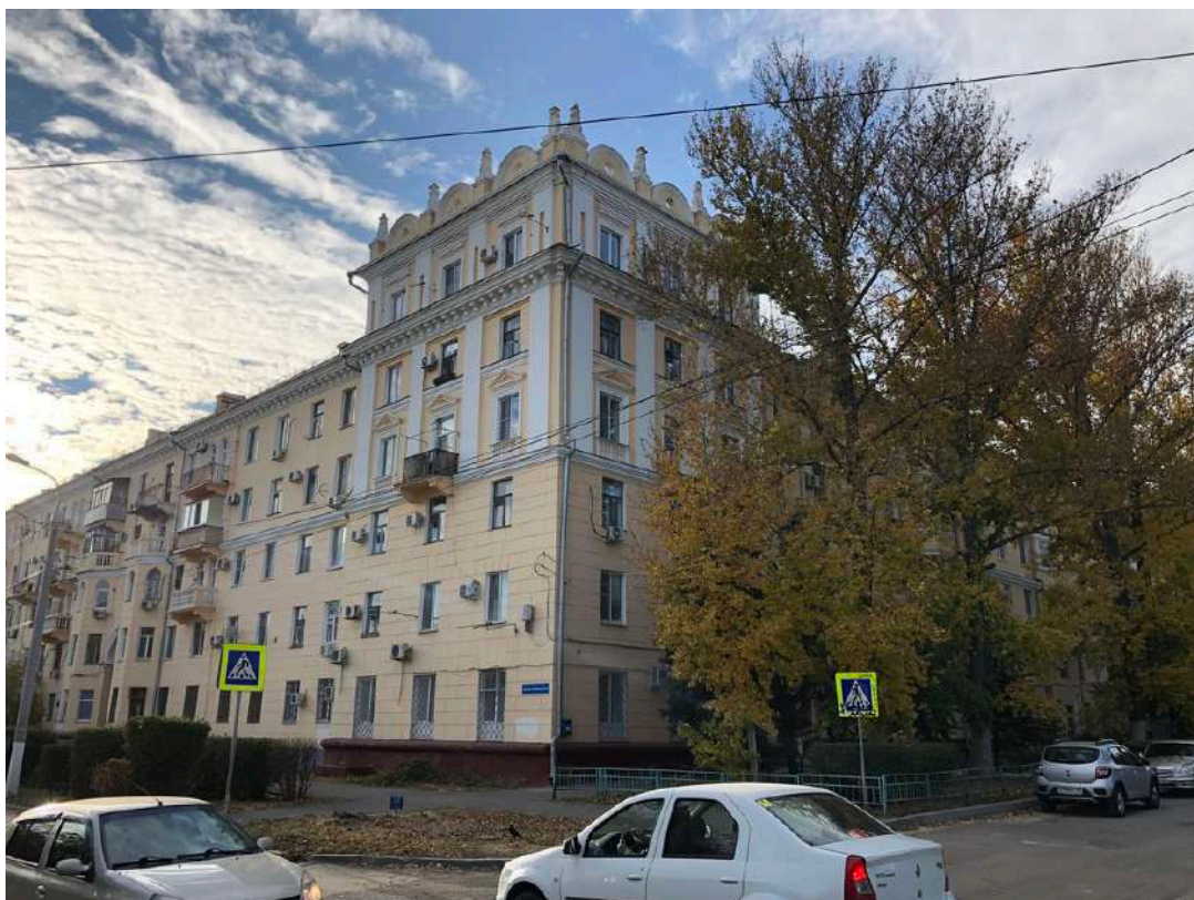
Фотография № 21.1. Здание по адресу пр-кт им. В.И. Ленина, д. 119.
