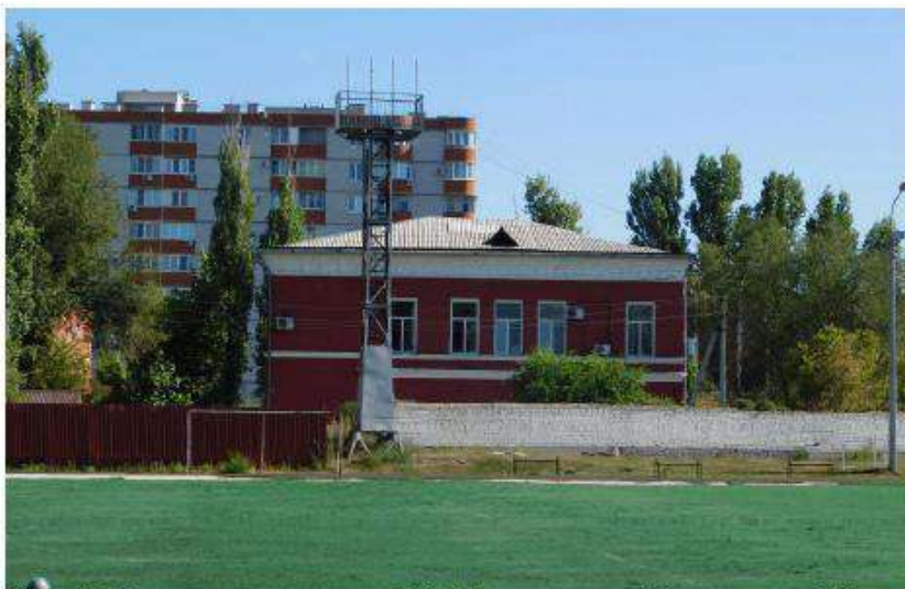
Фото 10. Территория, прилегающая ОКН «Начальная школа (Школа искусств N 3)», расположенного по адресу: г. Волгоград, ул. Социалистическая, 34
