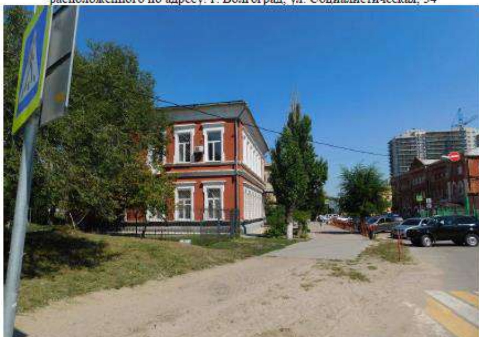
Фото 12. Территория, прилегающая к ОКН «Начальная школа (Школа искусств N 3)», расположенного по адресу: г. Волгоград, ул. Социалистическая, 34
