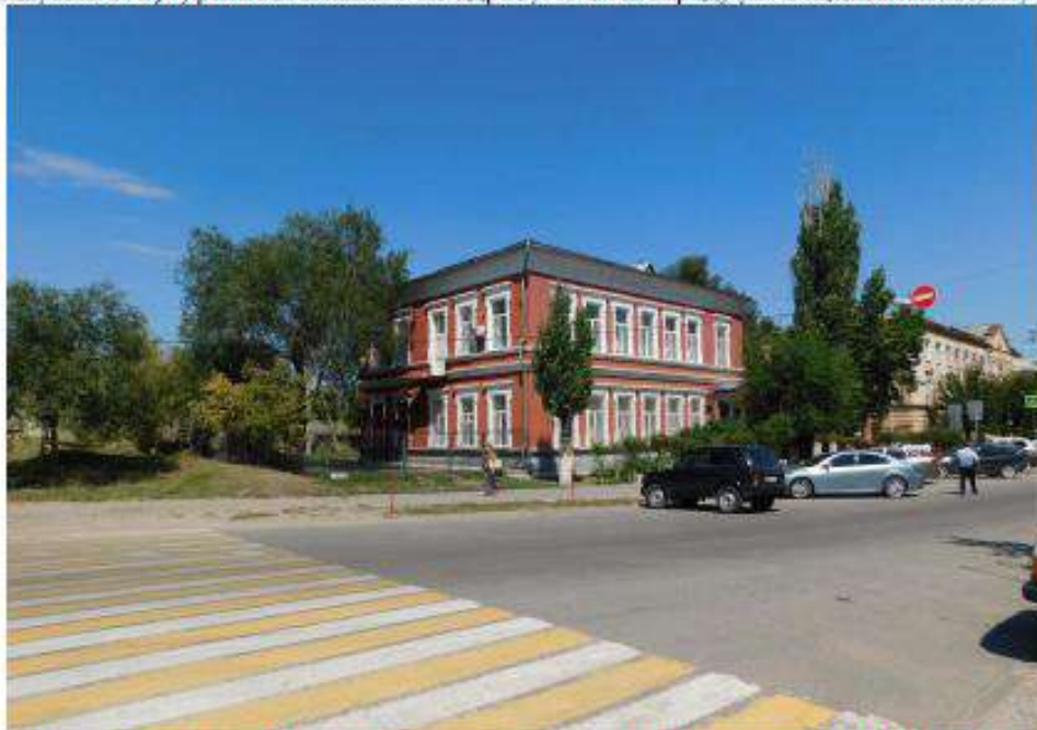
Фото 2. Территория, прилегающая ОКН «Начальная школа (Школа искусств N 3)», расположенного по адресу: г. Волгоград, ул. Социалистическая, 34
