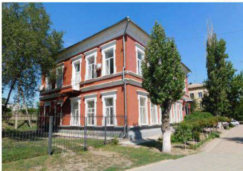
Фото 9. Территория, прилегающая к ОКН «Начальная школа (Школа искусств N 3)», расположенного по адресу: г. Волгоград, ул. Социалистическая, 34
