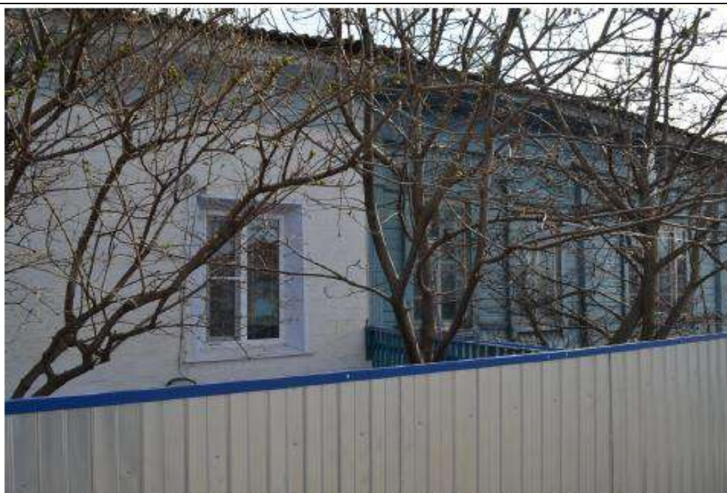
Фото 7. Граница между историческим зданием и позднейшей пристройкой Дата съемки – апрель 2021 г.
