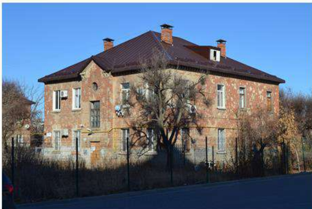
Фото 3. Вид на объект культурного наследия
