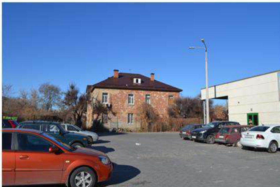
Фото 1. Вид на объект культурного наследия
