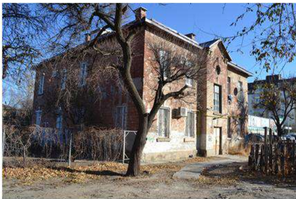
Фото 4. Вид на объект культурного наследия
