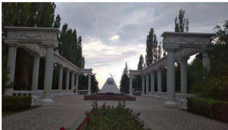
25. Комплекс застройки города гидростроителей. Волгоградская область, г. Волжский, 1-ая очередь города. Колоннады центральной аллеи парка.
