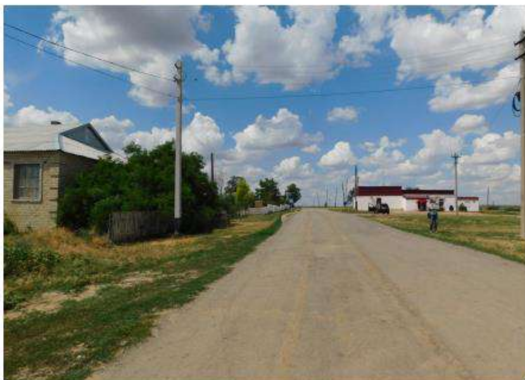
Фото 45. Фото окружающей архитектурно-градостроительной среды.
