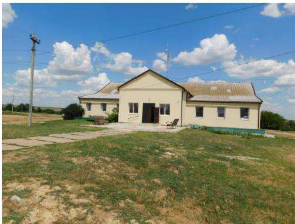
Фото 44. Фото окружающей архитектурно-градостроительной среды.
