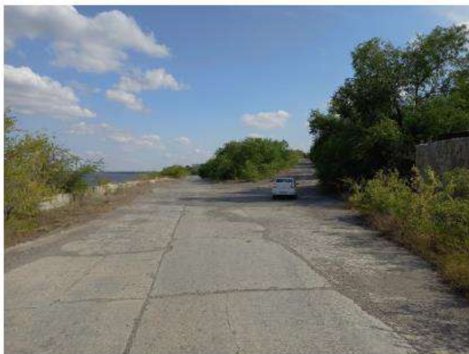
Вид на территорию объекта культурного наследия, сентябрь 2021
