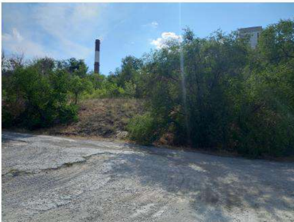
Вид на территорию объекта культурного наследия, сентябрь 2021
