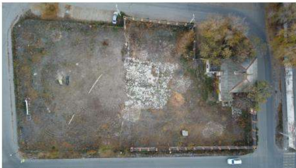
Фото 29. 3-й участок проектирования. Вид с квадрокоптера.
