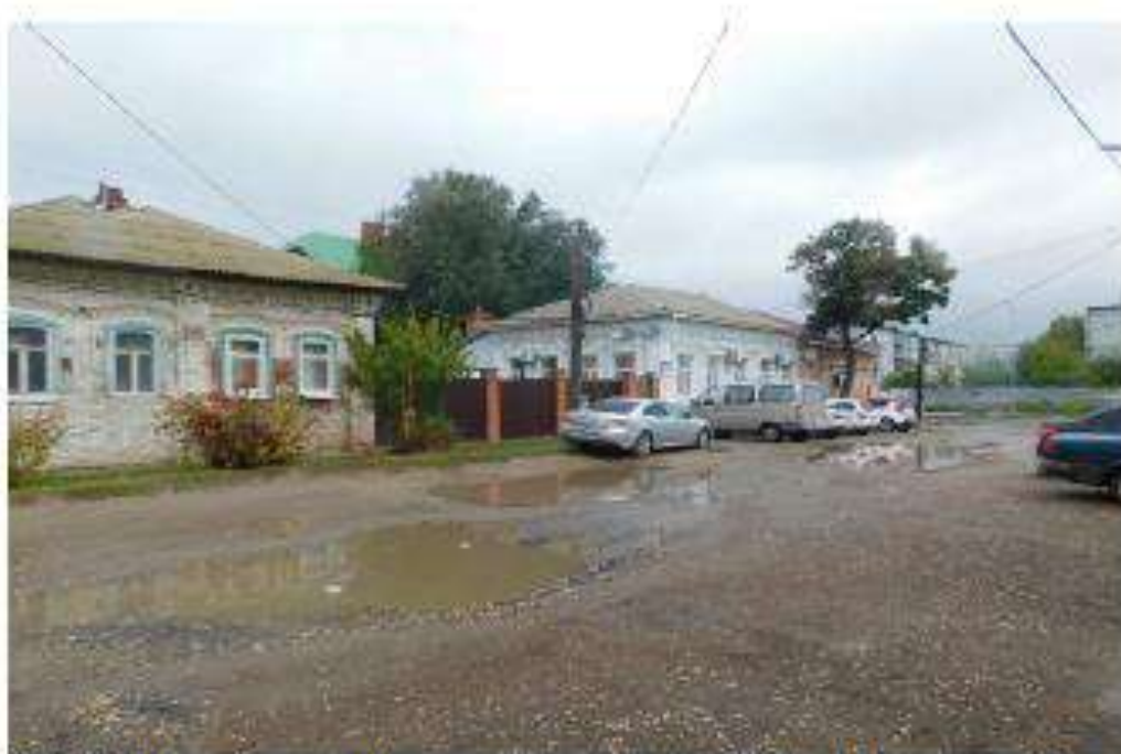
Ф11. 04. Владение Ведыкина (главный дом, склады), кон. XIX в., ул. Гражданская, 52
