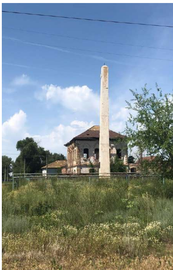
Вид с восточной стороны
