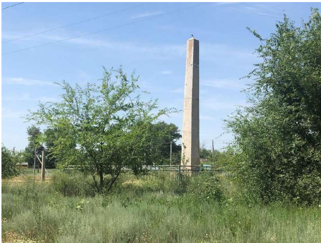
Вид с северо-восточной стороны.
