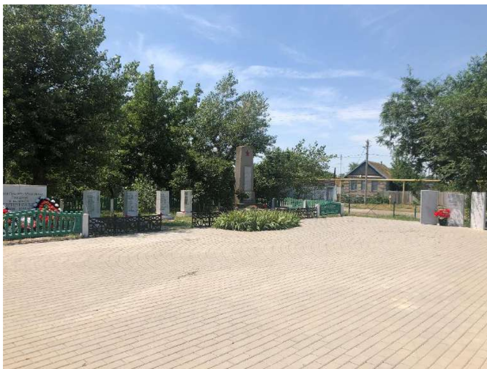
Вид на весь ансамбль с северо-восточной стороны
