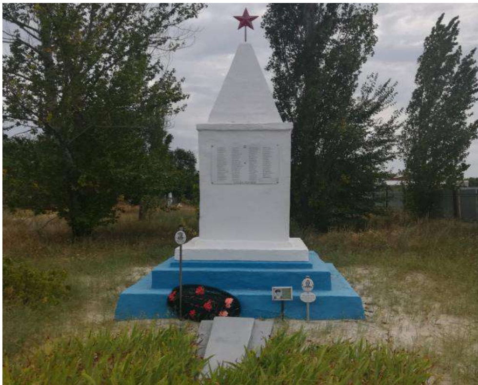
Общий вид Объекта исследования
