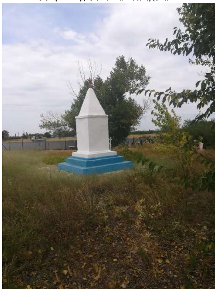
Общий вид Объекта исследования
