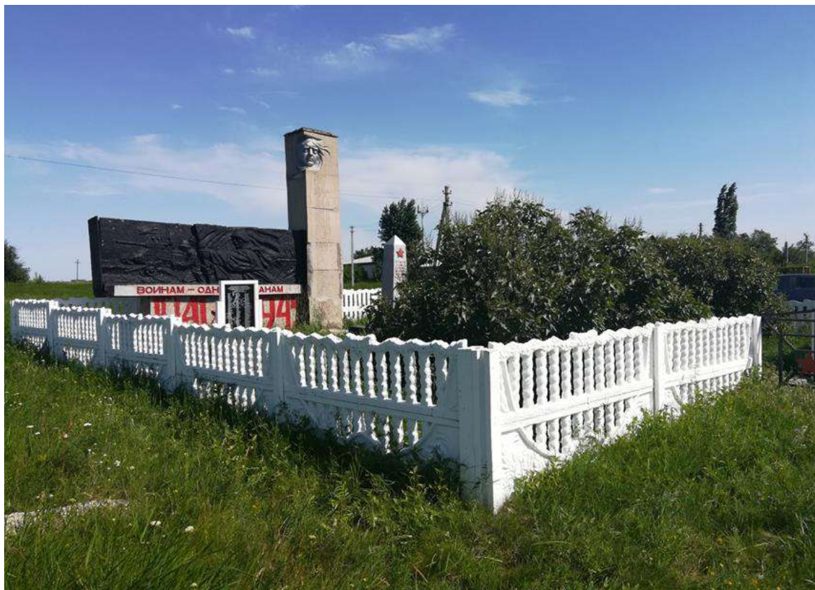
Общий вид с северо-западной стороны.
