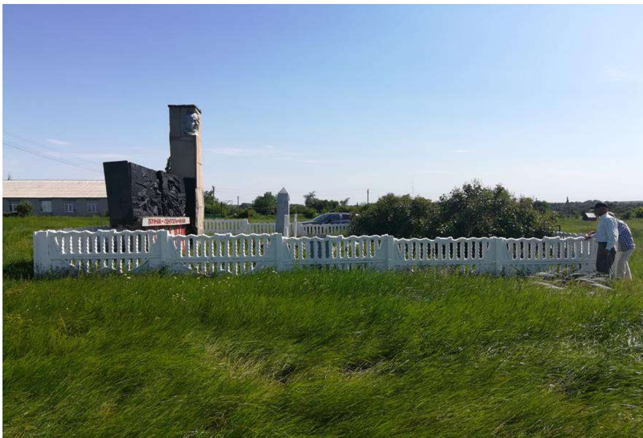
Общий вид с северной стороны.
