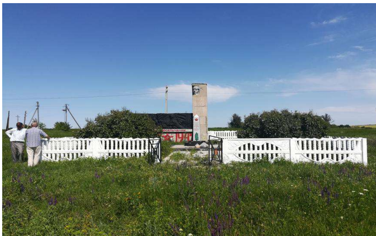
Общий вид с западной стороны.
