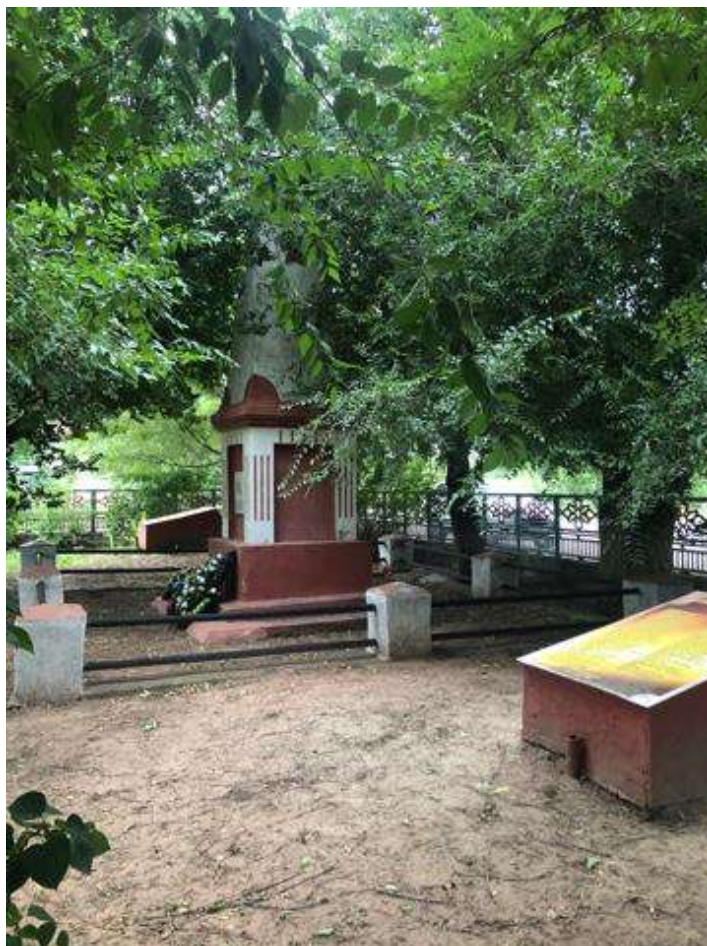
Общий вид Объекта исследования
