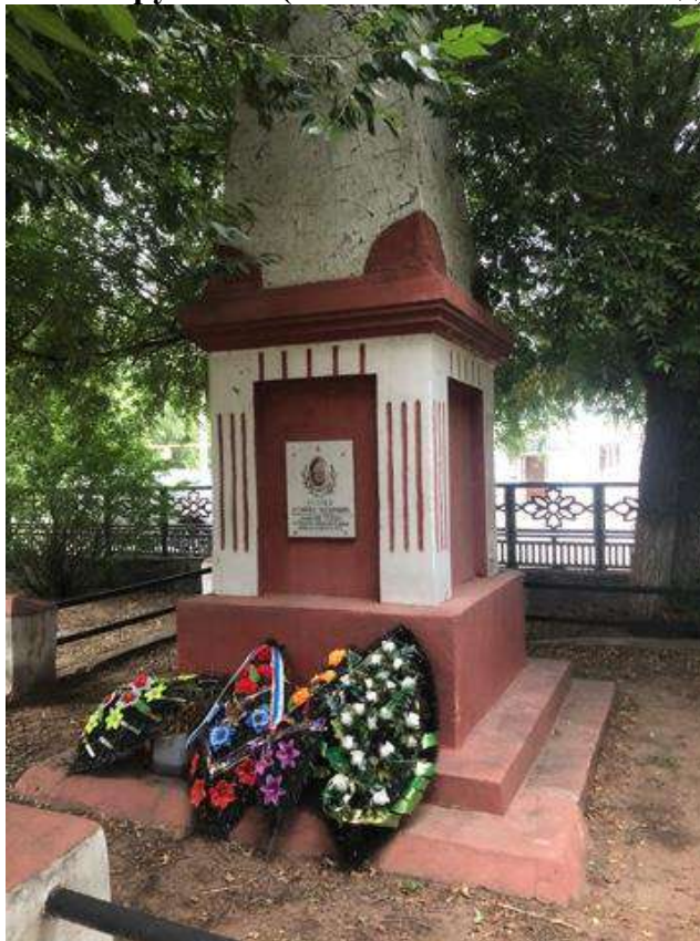
Общий вид Объекта исследования
