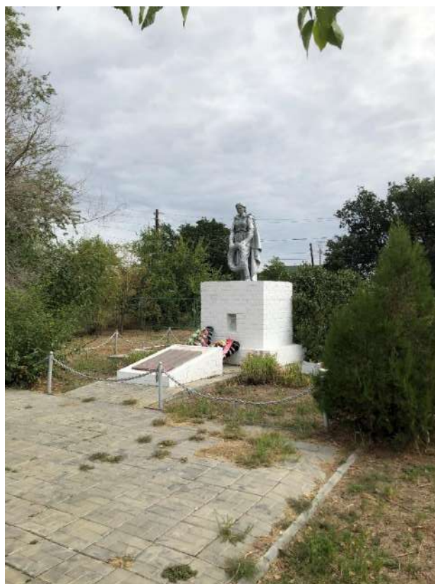
Вид с юго-западной стороны.
