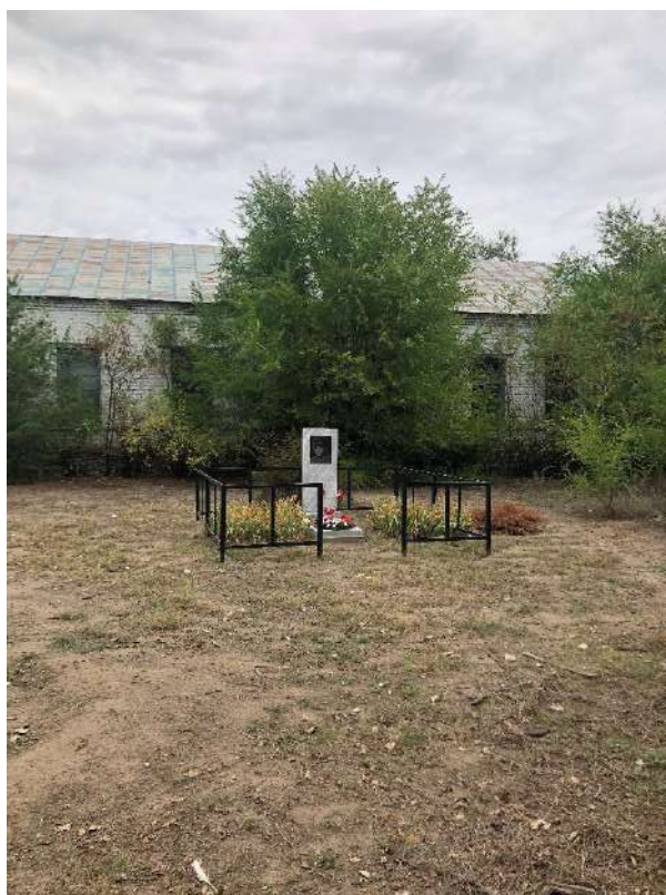
Общий вид с западной стороны.
