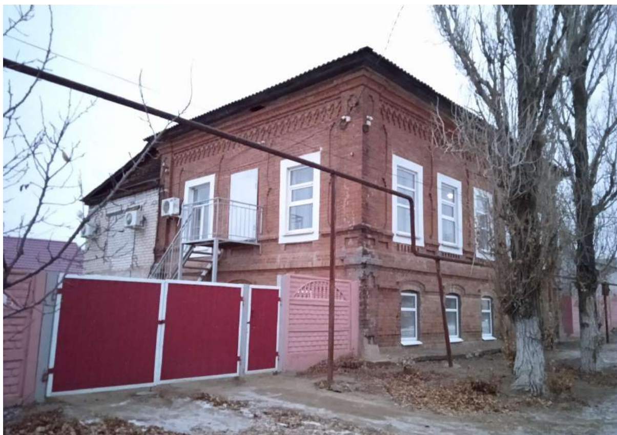
Фото 2. Вид на восточный угол здания по ул. Дзержинского, 3
