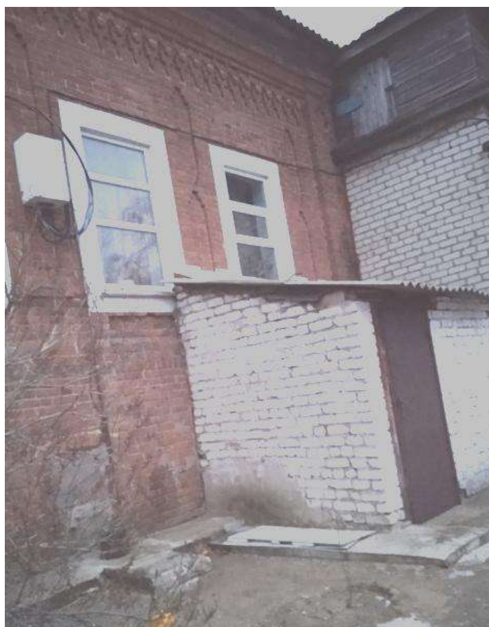
Пристройка к северо-западному фасаду здания
