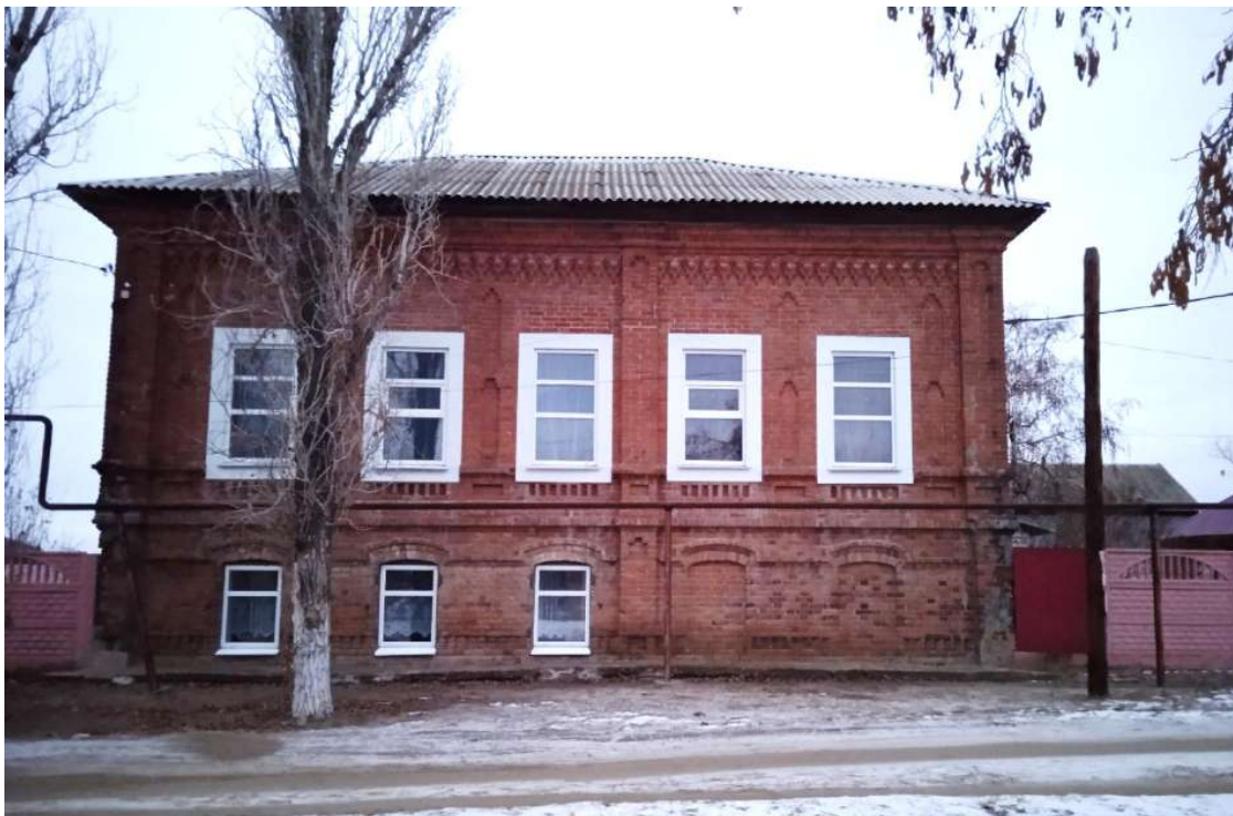
Общий вид на главный северо-восточный фасад
