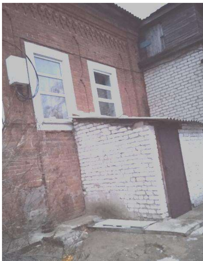
Фото 6. Пристройка к северо-западному фасаду здания по ул. Дзержинского, 3 Фрагмент.
