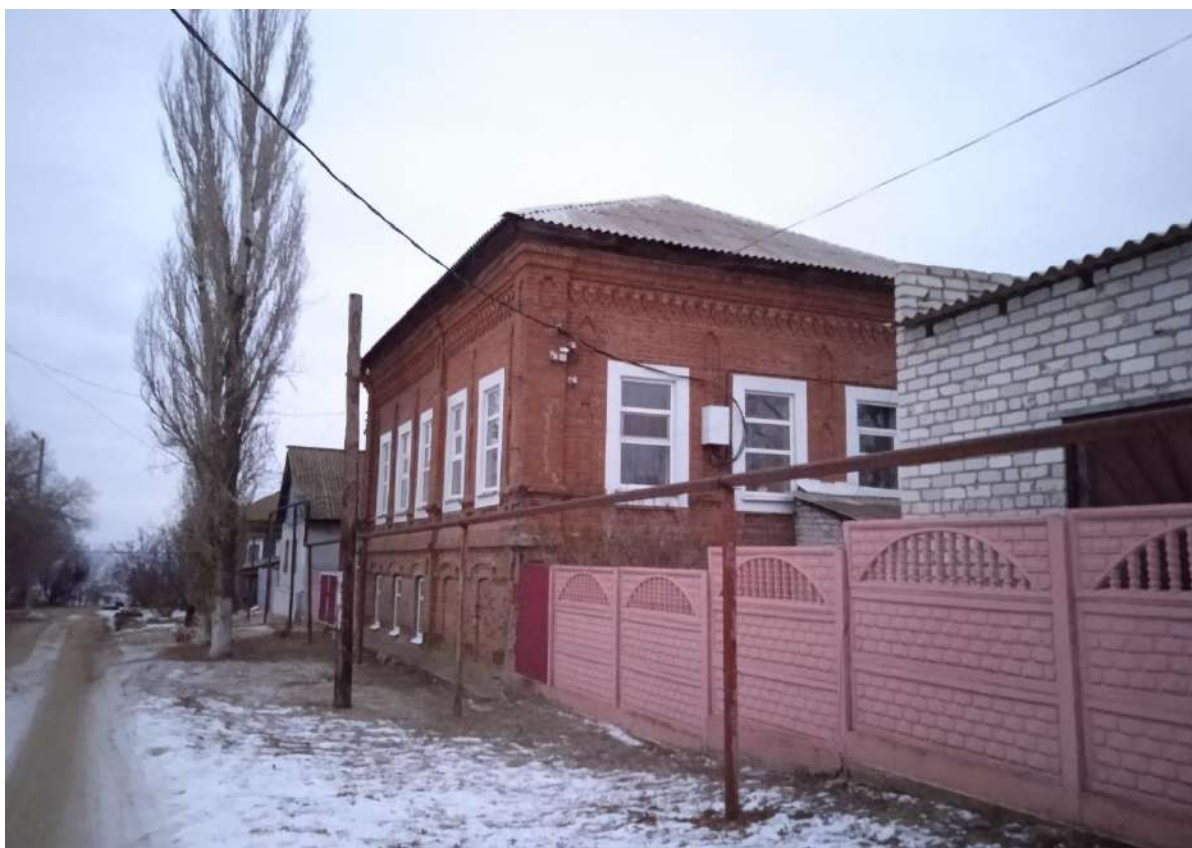
Фото 5. Вид на северный угол здания по ул. Дзержинского, 3
