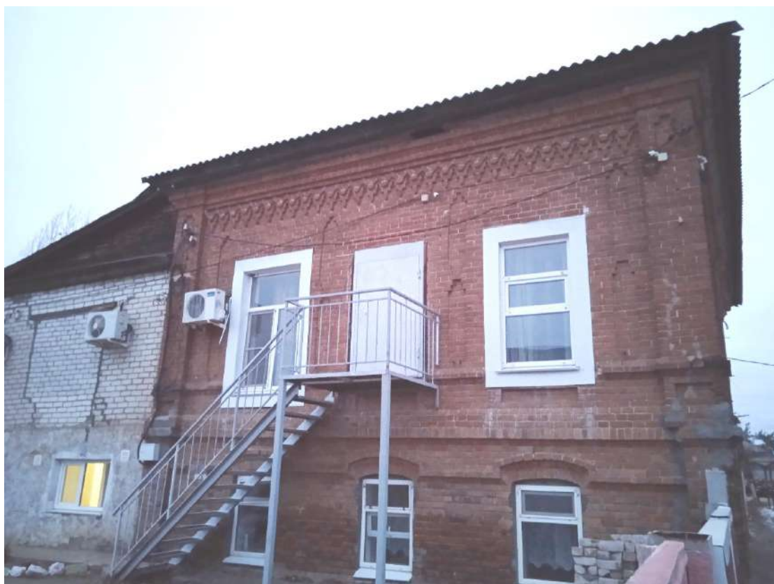
Вид на юго-восточный фасад здания
