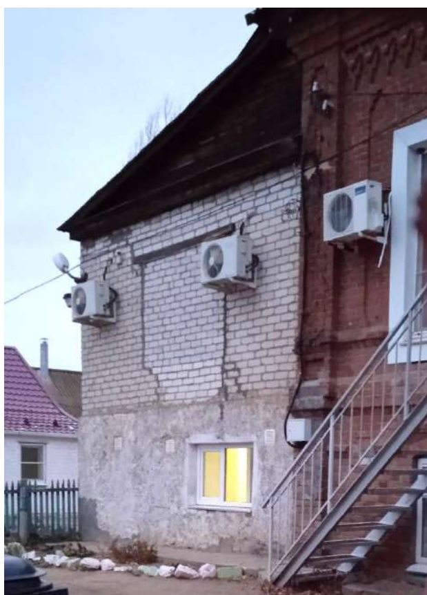
Фото 4. Пристройка к юго-восточному фасаду. Фрагмент
