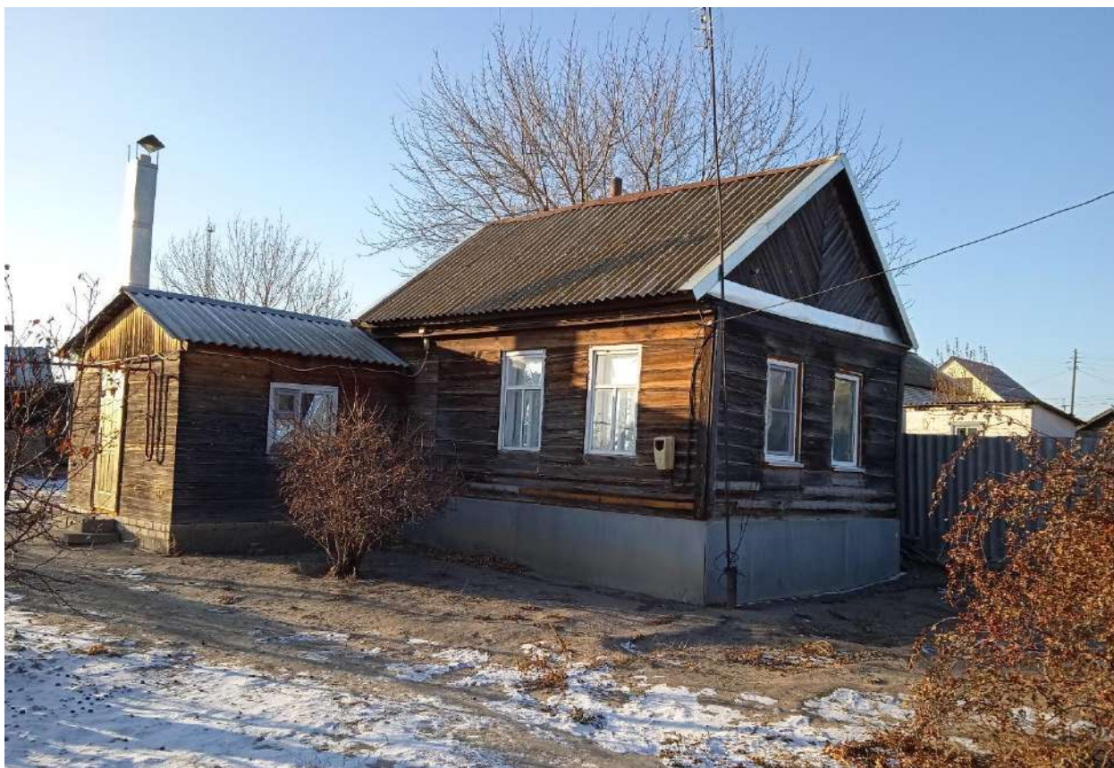
Фото 11. Тип прилегающей застройки по ул. Санджирова (нечетная сторона улицы)
