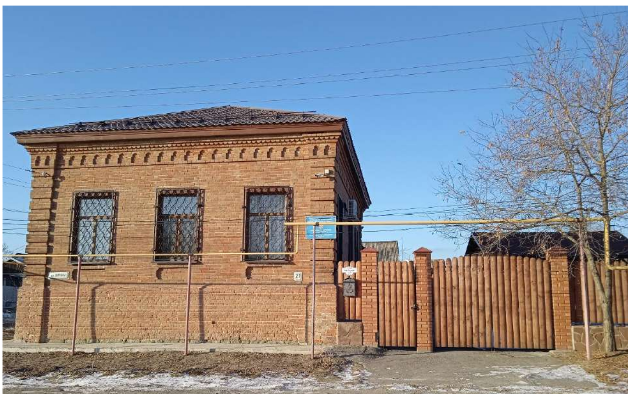
Фото 2. Общий вид главный юго-восточный фасад здания по ул. Кирова, 27
