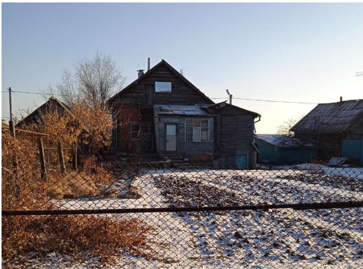
Фото 10. Тип прилегающей застройки по ул. Санджирова (нечетная сторона улицы)
