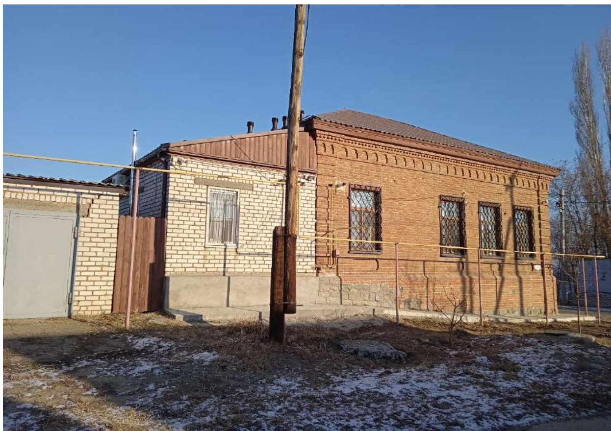
Фото 8. Вид на юго-западный фасад здания с пристройкой к северо-западному дворовому фасаду
