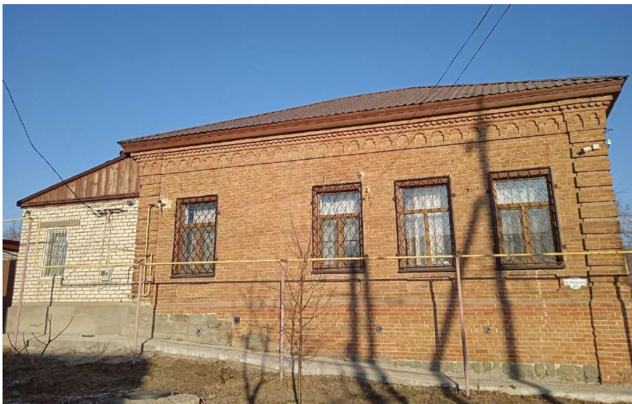
Фото 7. Вид на главный юго-западный фасад здания по ул. Санджирова с пристройкой
