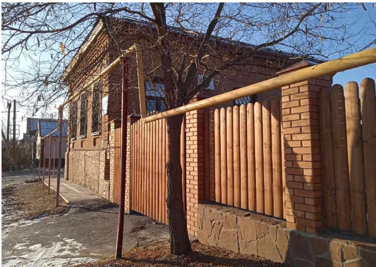
Фото 4. Вид вдоль фасада по ул. Кирова в юго-западном направлении с газопроводом в надземном исполнении
