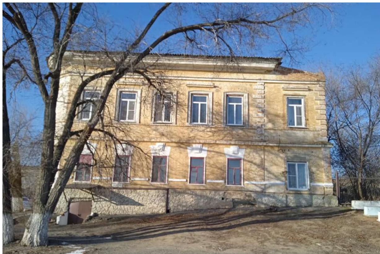
Фото 10. Вид на главный юго-восточный фасад здания, выходящий на ул. им. Кирова
