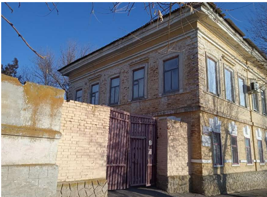
Фото 4. Вид на часть северо-западного фасада и въездные ворота на дворовую территорию
