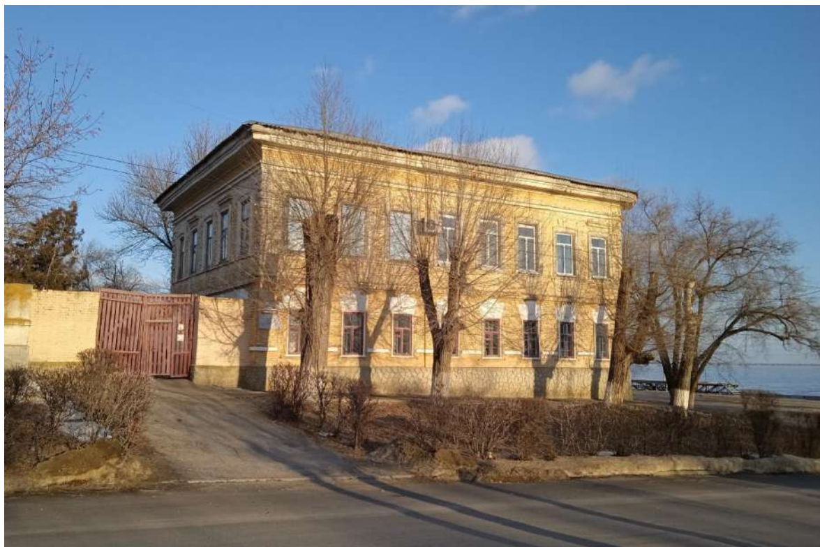
Вид на главный юго-западный фасад
