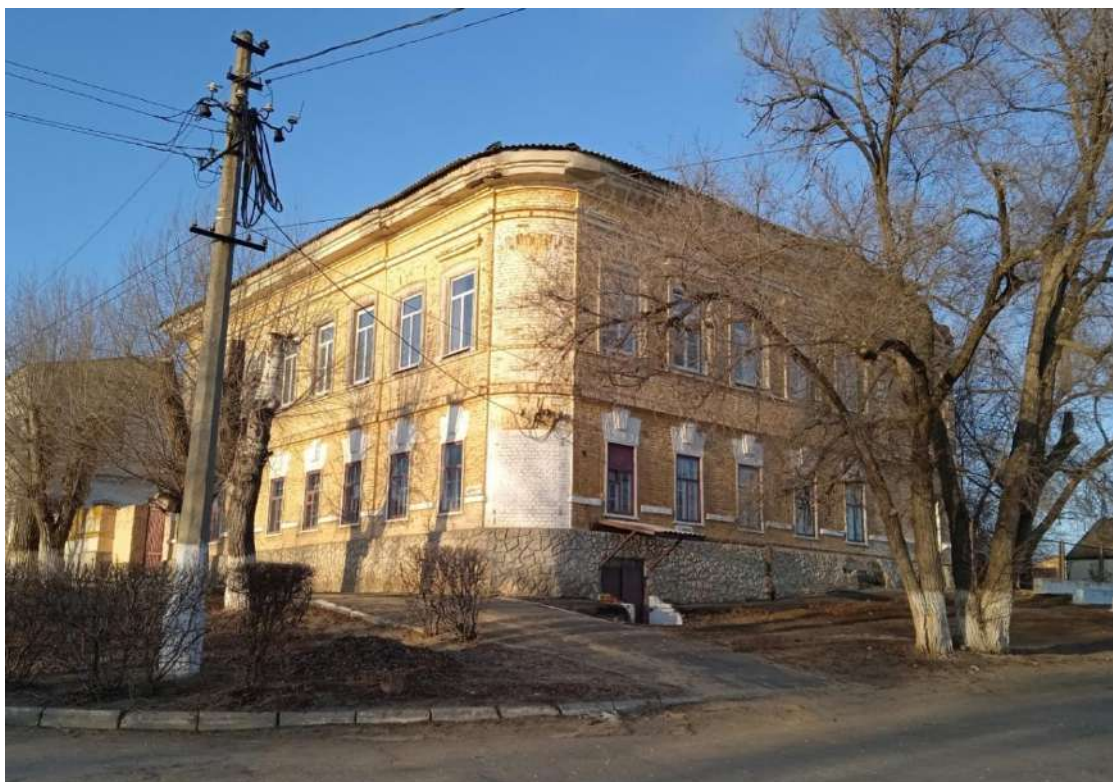
Фото 1. Вид на угловой южный фасад выявленного объекта культурного наследия «Дом купцов [А.А., и Н.А.] Ваагов», 1821 г. по адресу ул. Московская, 2
