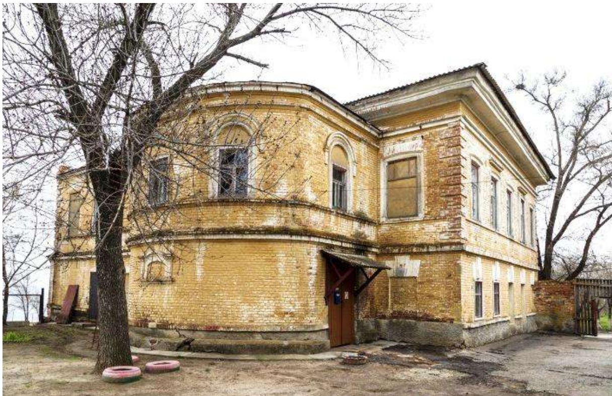
Вид с дворовой территории на северо-западный и северо-восточный (с полукруглой пристройкой лестничной клетки) дворовые фасады здания
