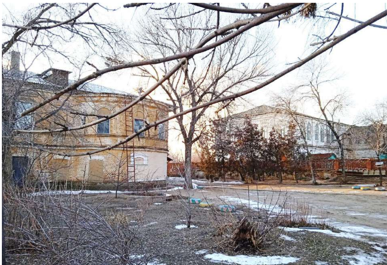
Фото 6. Вид на часть дворового северо-восточного фасада
