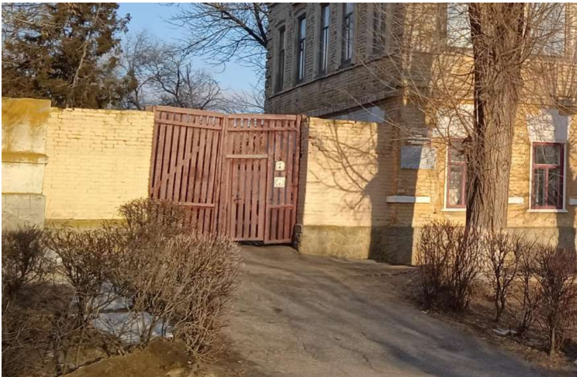
Фото 3. Въездные ворота на дворовую территорию здания по ул. Московская, 2. Вид с юго-запада
