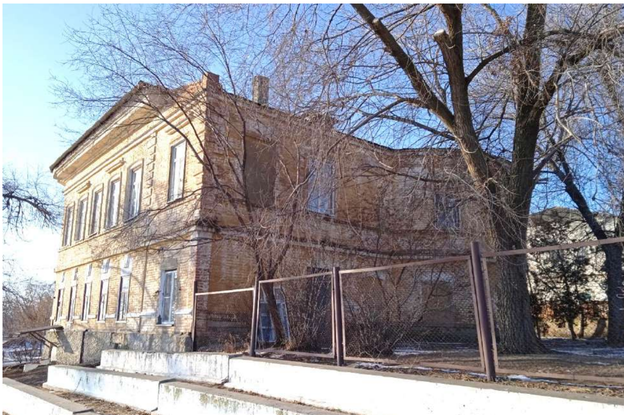
Фото 9. Вид вдоль ул. им. Кирова на восточный угол здания
