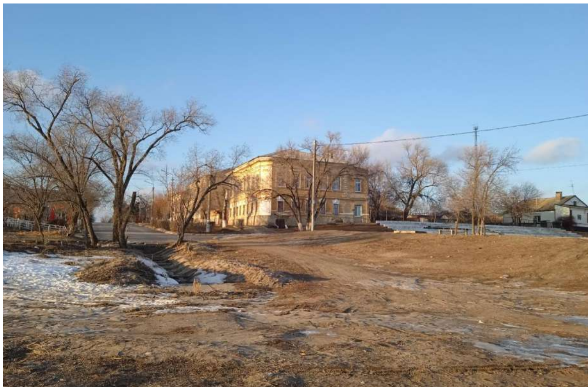
Фото 13. Дальний вид на здание со стороны набережной реки Волга
