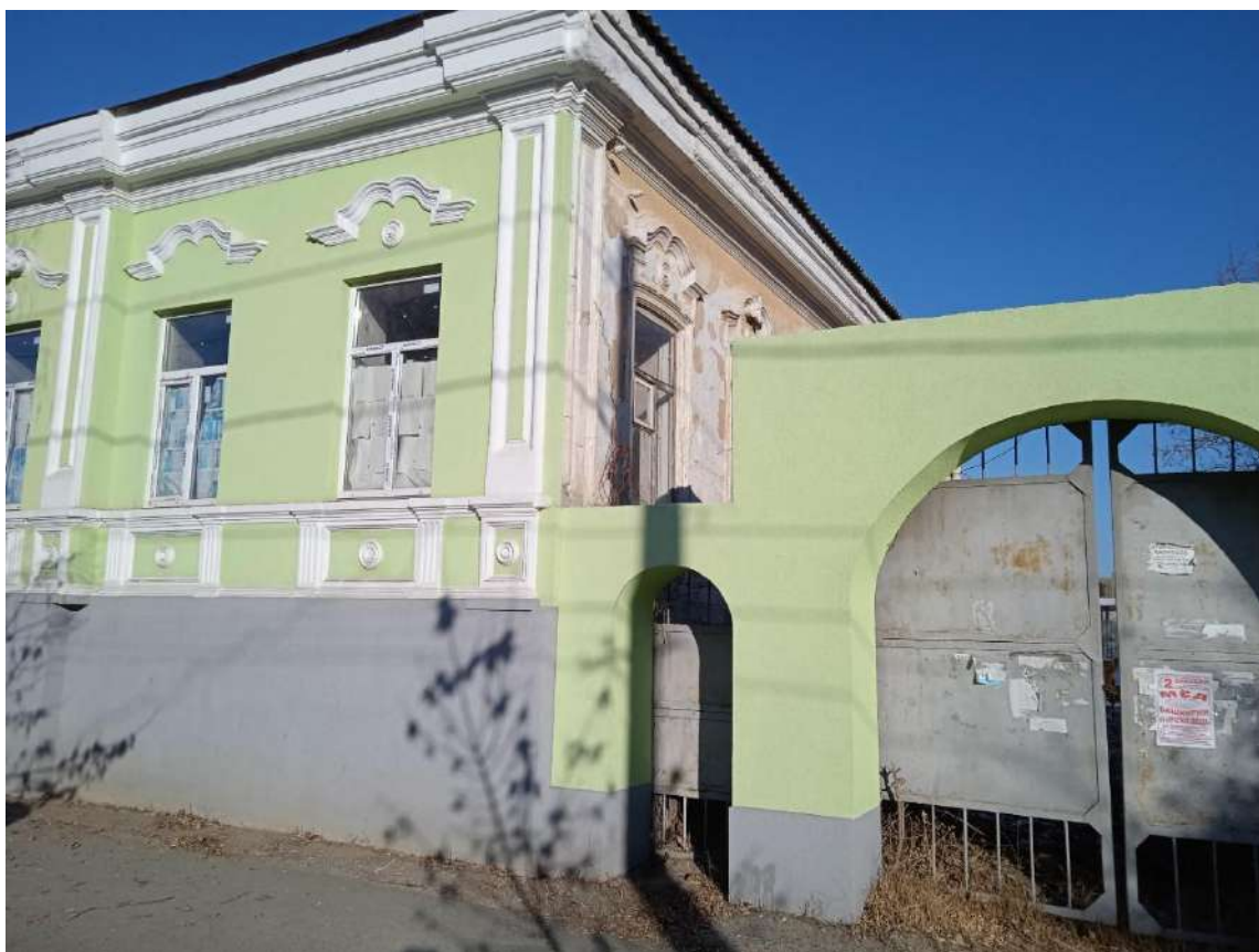
Фото 9. Вид на южный угол здания и главные въездные ворота (фрагмент) на дворовую территорию
