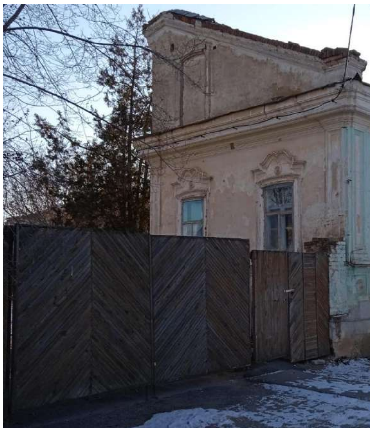
Фото 5. Вид на северо-восточный торец здания и ворота на дворовую территорию
