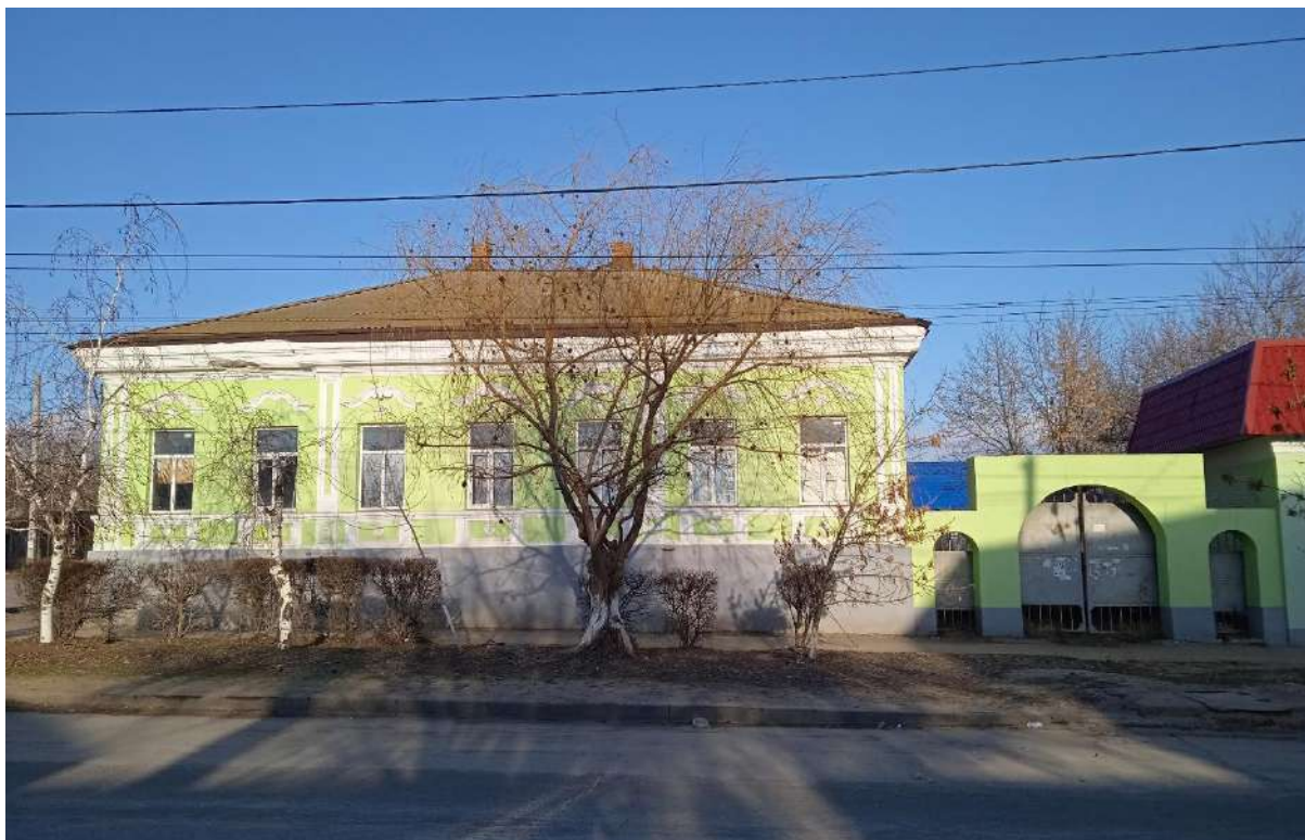
Фото 1. Общий вид на юго-западный фасад здания выявленного объекта культурного наследия – «дом Марчукова», ворота и флигель (фрагмент) по ул. Московская, 24
