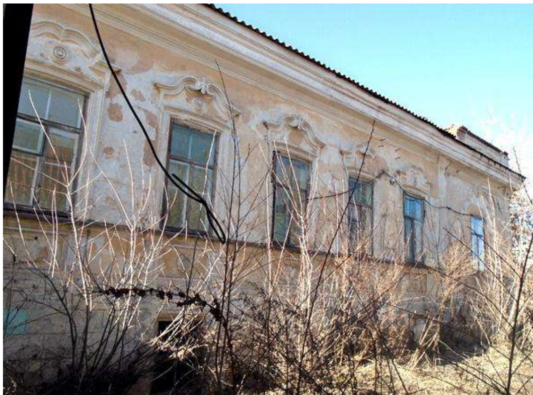
Вид на дворовый юго-восточный фасад
