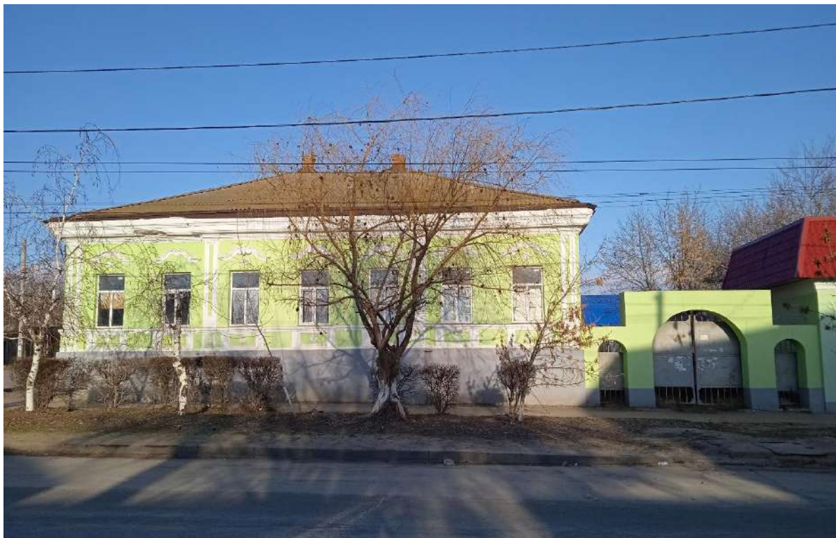
Общий вид на юго-западный фасад здания
