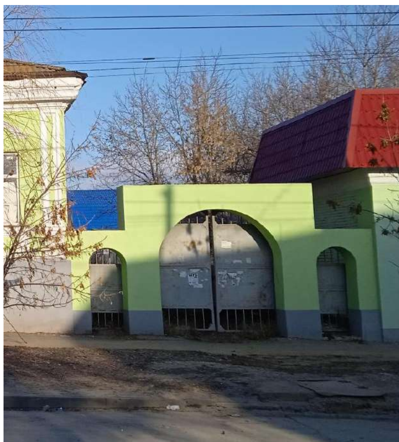
Фото 10. Главные въездные ворота со стороны ул. Московская
