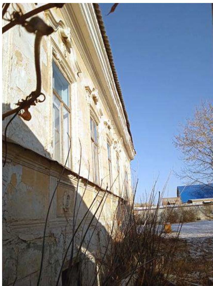
Фото 8. Вид на дворовый юго-восточный фасад (фрагмент) и часть двора сквозь главные ворота по ул. Московская
