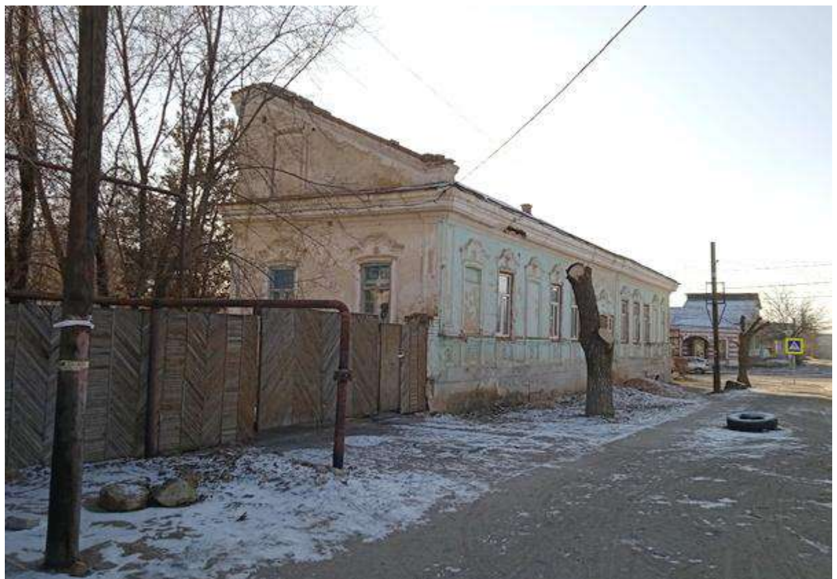
Фото 4. Общий вид на северо-восточный торец здания и фасад по ул. Республиканская
