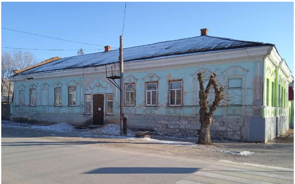
Фото 3. Вид северо-западный фасад здания
