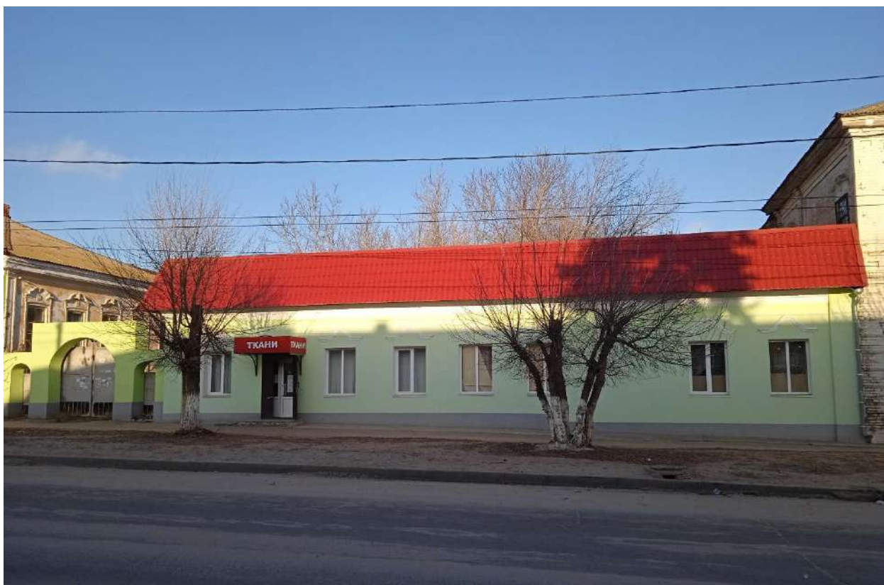
Фото 11. Флигель здания по ул. Московская, 24. Вид с юго-запада
