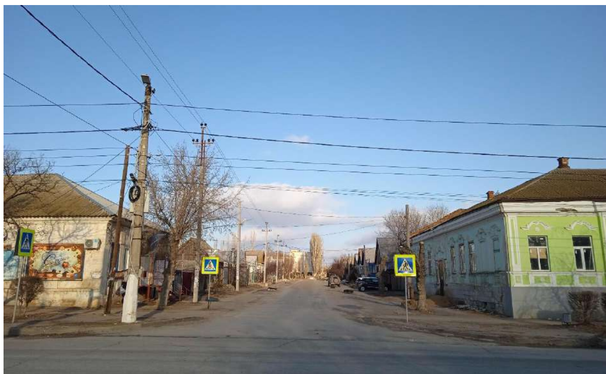
Фото 2. Вид на западный угол здания и вдоль северо-западного фасада по ул. Республиканская
