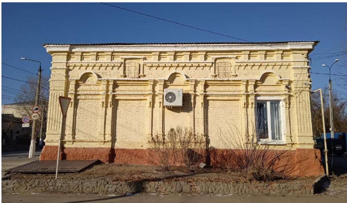
Фото 5. Вид на боковой юго-восточный фасад здания
