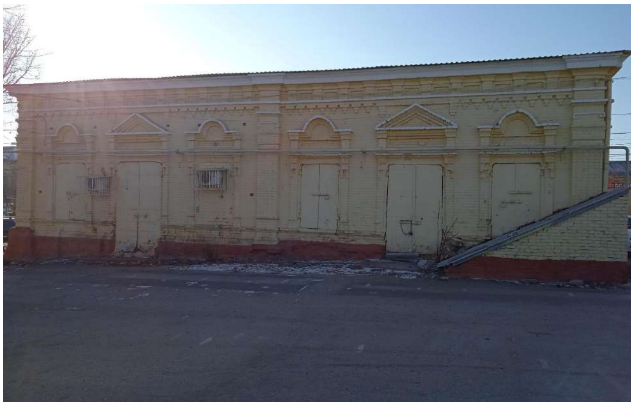
Фото 4. Вид на северо-восточный фасад здания
