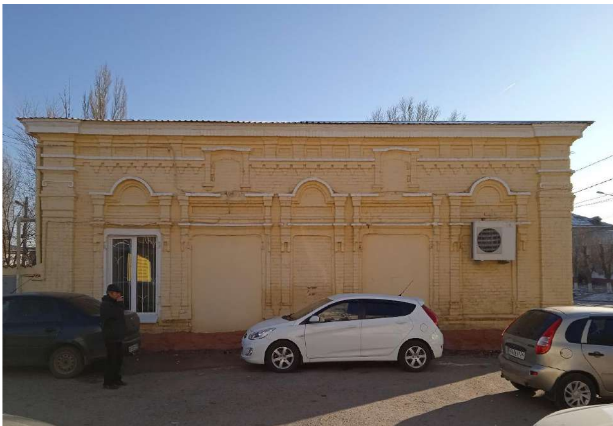
Фото 3. Вид на боковой северо-западный фасад здания
