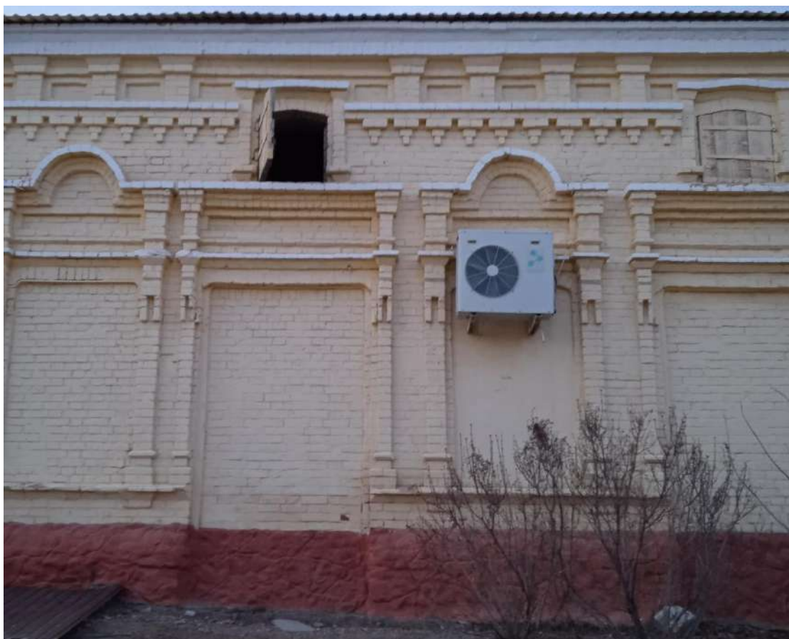
Фото 11. Чердачные окна на юго-восточном фасаде здания
