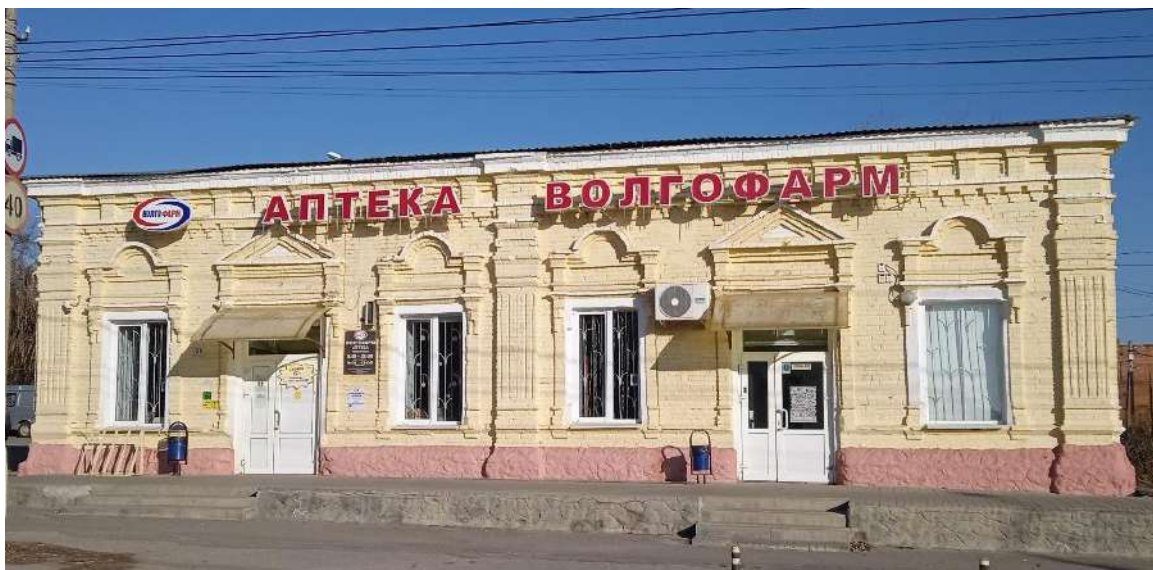
Вид на главный юго-западный фасад
