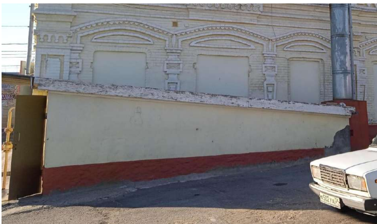
Фото 7. Вход в подвал со стороны северо-восточного фасада
