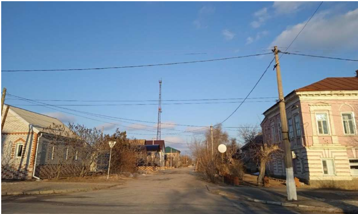
Фото 4. Вид вдоль северо-западного фасада здания на ул. им. Минина
