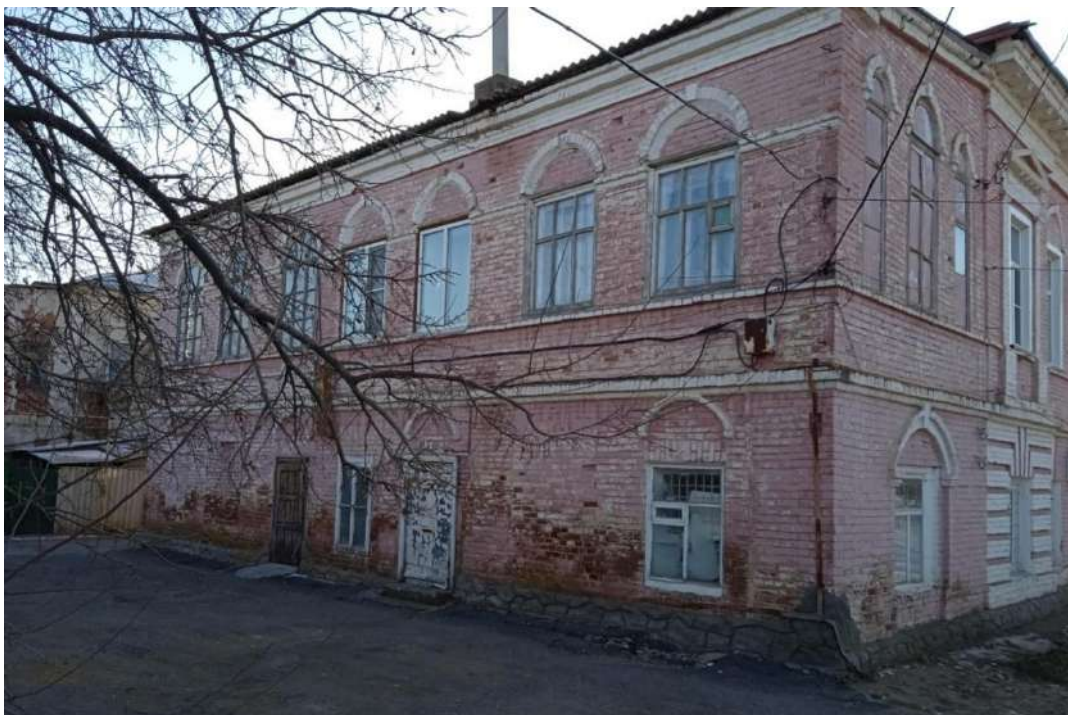
Вид на северо-восточный дворовый фасад
