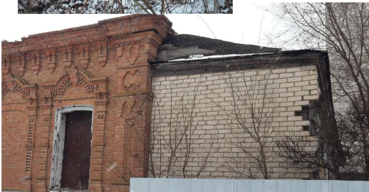
Фото 8. Вид на северо-восточную стену деревянной пристройки к зданию по ул. Октябрьская, 17а (облицованной белым силикатным кирпичом)
