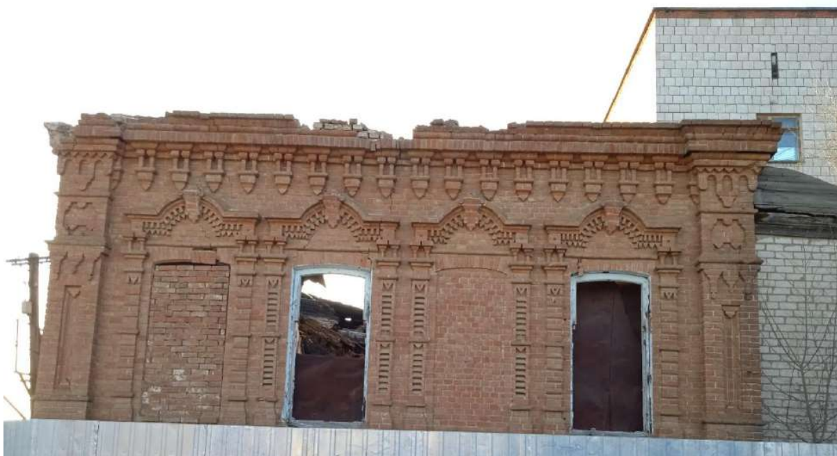
Вид на северо-восточный фасад
