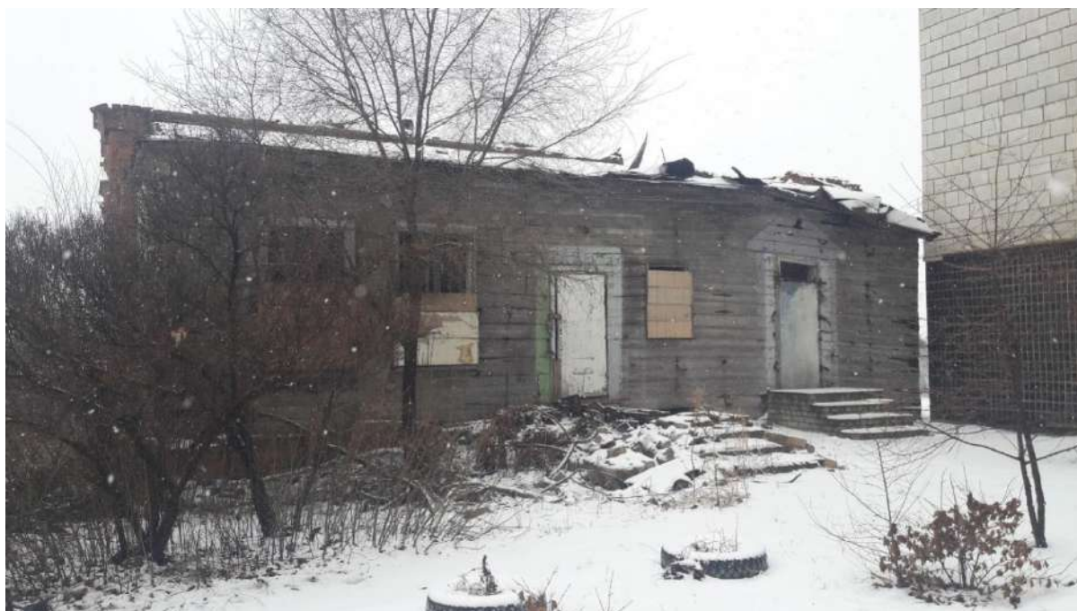
Фото 6. Вид с северо-запада на деревянную пристройку к зданию по ул. Октябрьская, 17а
