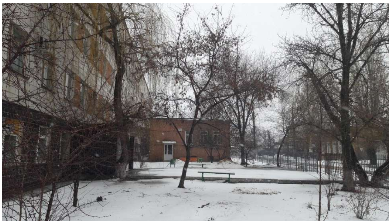
Фото 12. Вид от деревянной пристройки на северо-запад вдоль фасада здания Дубовской ЦРБ
