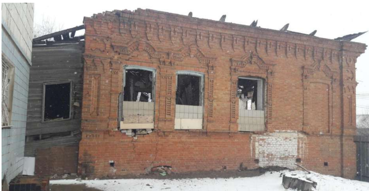
Вид на главный юго-восточный фасад
