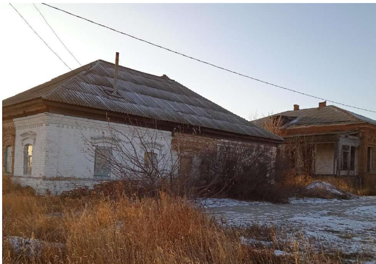
Фото 8. Вид на юго-западный фасад флигеля (с погребом) жилого дома
