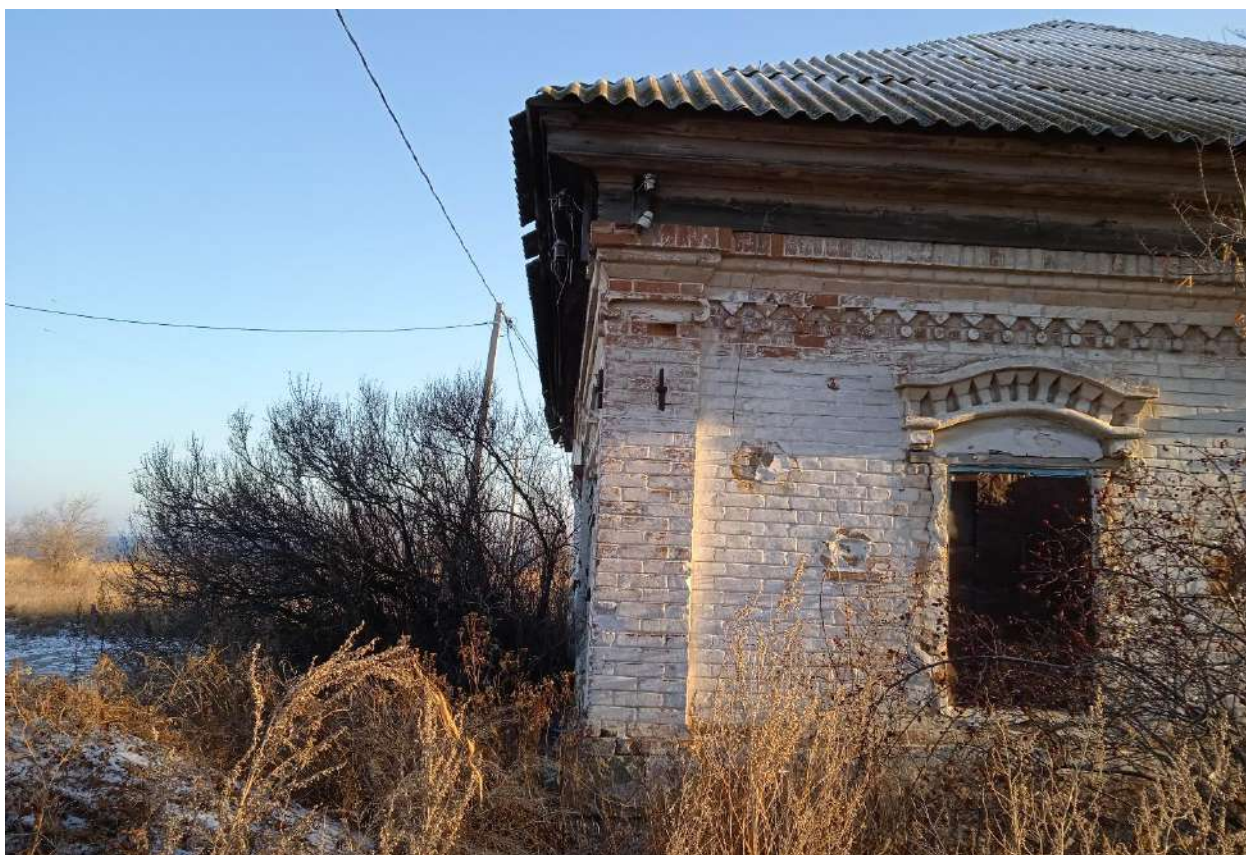
Фото 7. Вид на северный угол флигеля (с погребом) жилого дома
