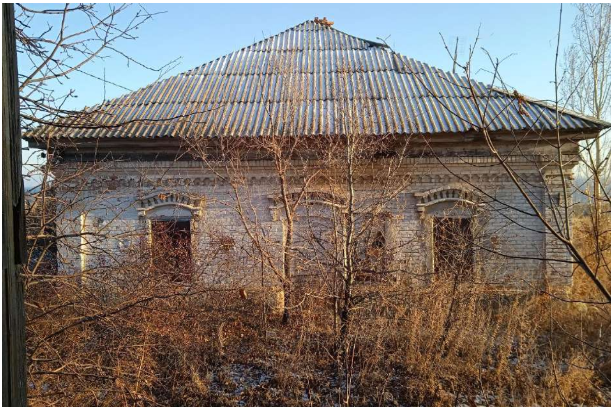
Фото 6. Вид на северо-западный фасад флигеля (с погребом) жилого дома
