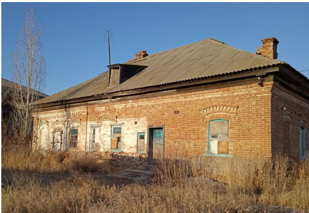
Вид на юго-западный фасад флигеля (с погребом) жилого дома
