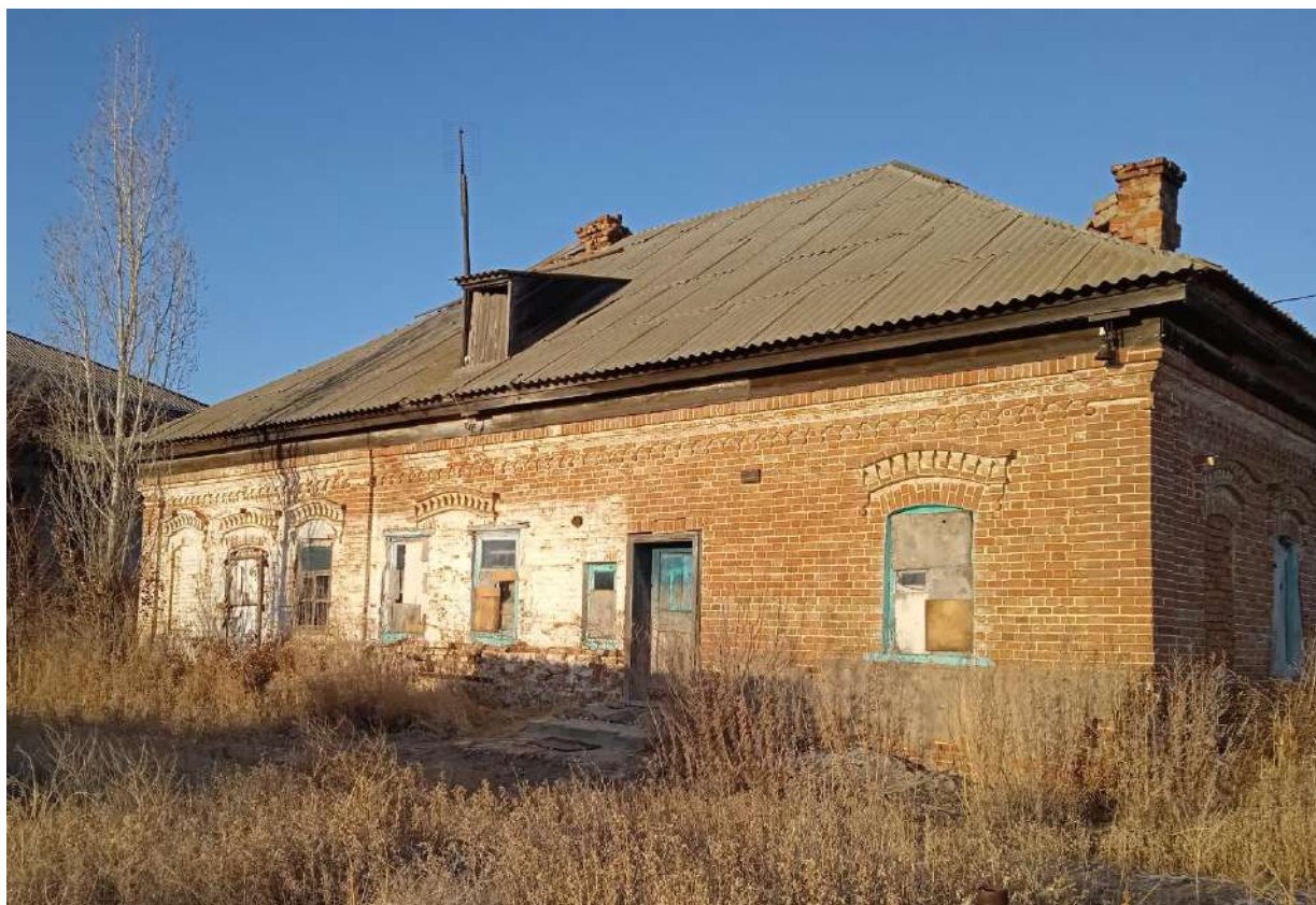
Фото 4. Вид на юго-западный фасад флигеля (с погребом) жилого дома
