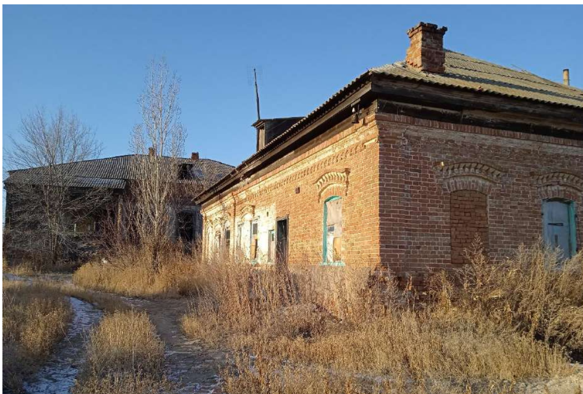
Фото 3. Вид на южный угол флигеля (с погребом) жилого дома
