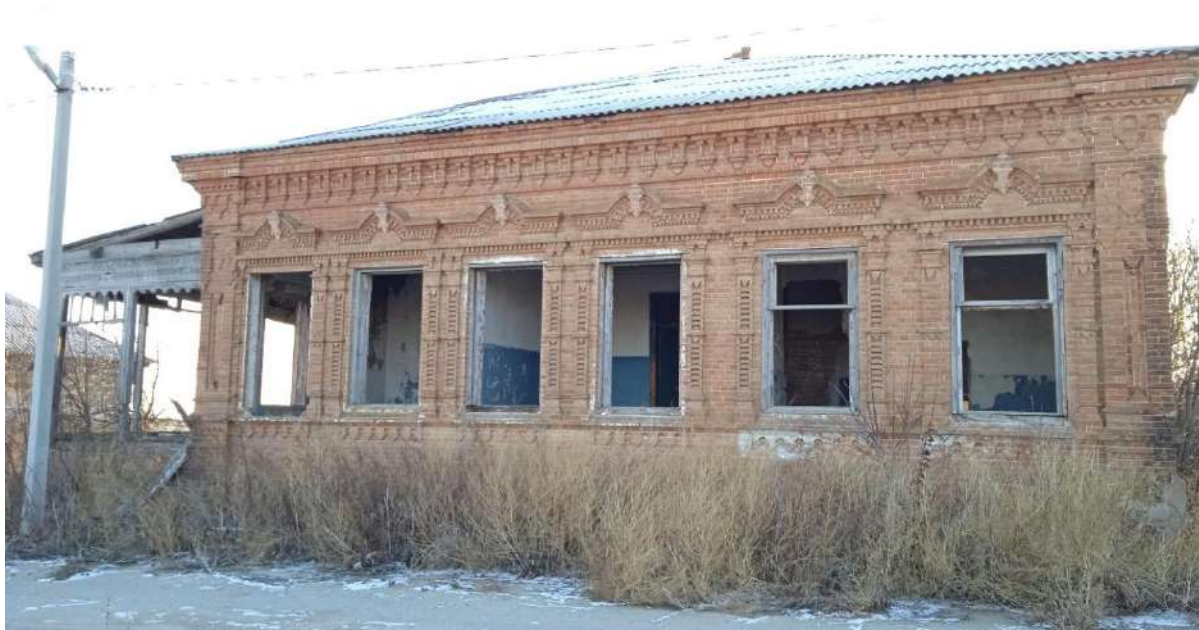
Вид на северо-восточный фасад
