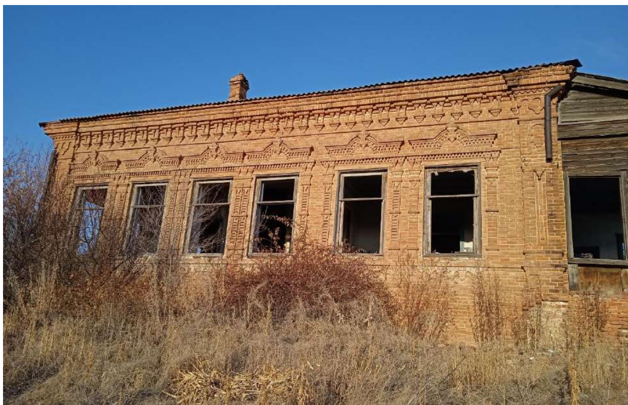
Фото 6. Вид на юго-западный фасад здания
