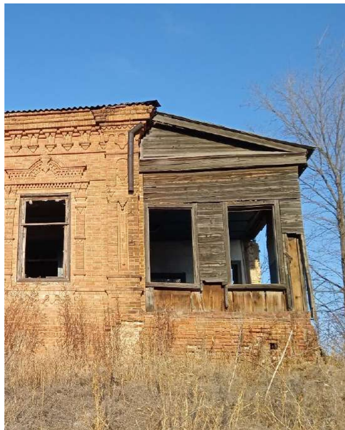
Фото 4. Вид на юго-западный фасад (фрагмент) здания с деревянной пристройкой – верандой
