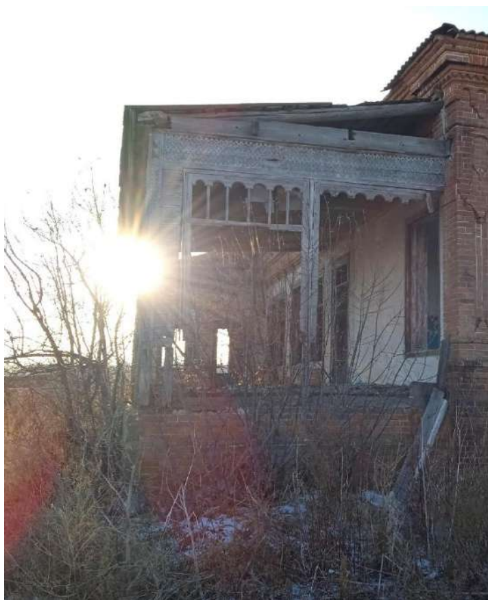
Фото 10. Вид со стороны северо-восточного фасада на деревянную пристройку-веранду к зданию
