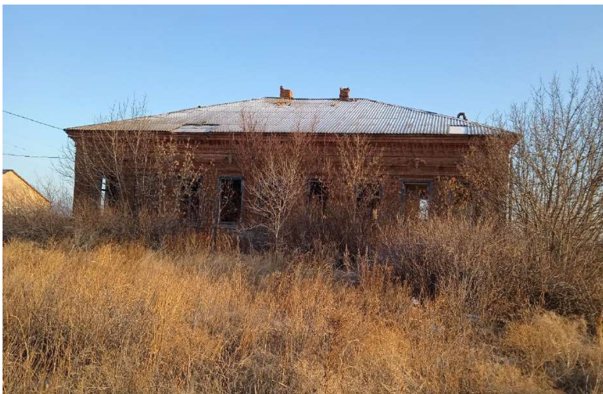
Фото 7. Вид на северо-западный фасад здания с пристройкой-верандой
