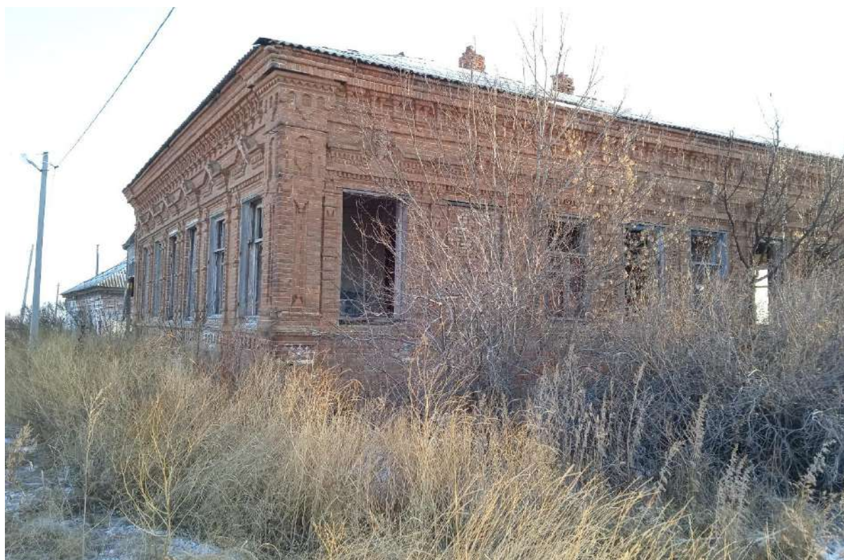
Фото 8. Вид на северный угол здания с пристройкой-верандой
