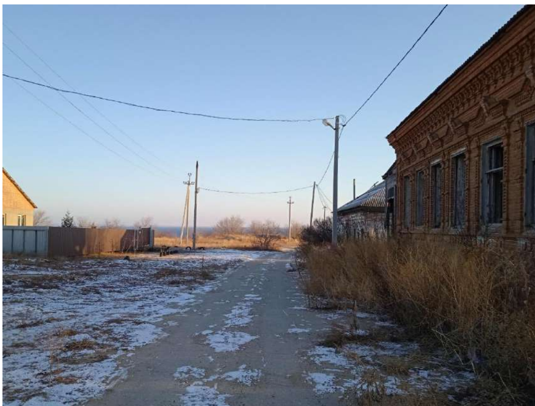
Фото 9. Вид в юго-восточном направлении вдоль ул. Степная со стороны северо-восточного фасада здания (в сторону р. Волга)
