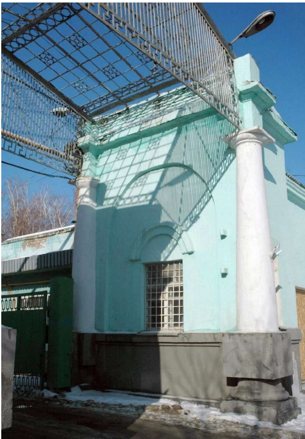
. Вид на северо-восточный пилон с бывшей проходной главных ворот метизного завода
