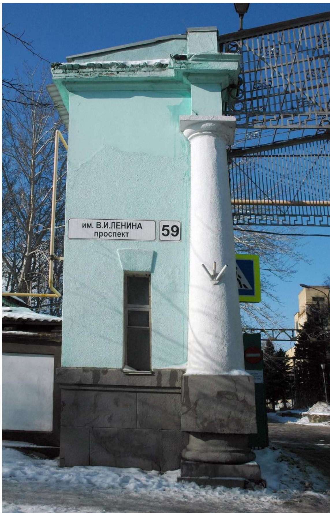
Фото 4. Фронтальный вид со стороны проспекта им. В.И. Ленина на юго-западный пилон с постом охраны главных ворот метизного завода.
