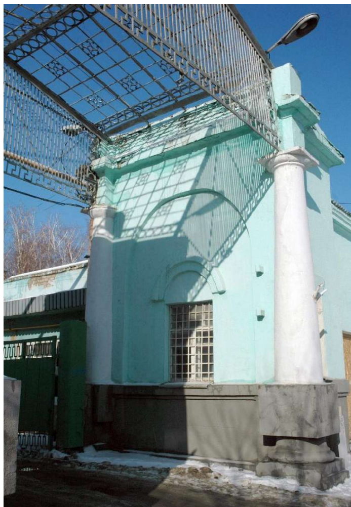
Фото 5. Цоколь пилона, нижняя часть и база колонны юго-западного пилона с постом охраны главных ворот метизного завода
