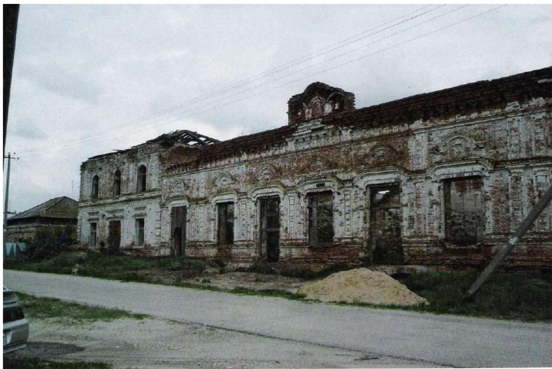
Рис. 3. Волгоградская область, Иловлинский район, Станица Качалинская. Дом купца Бабушкина, 2003 г.
