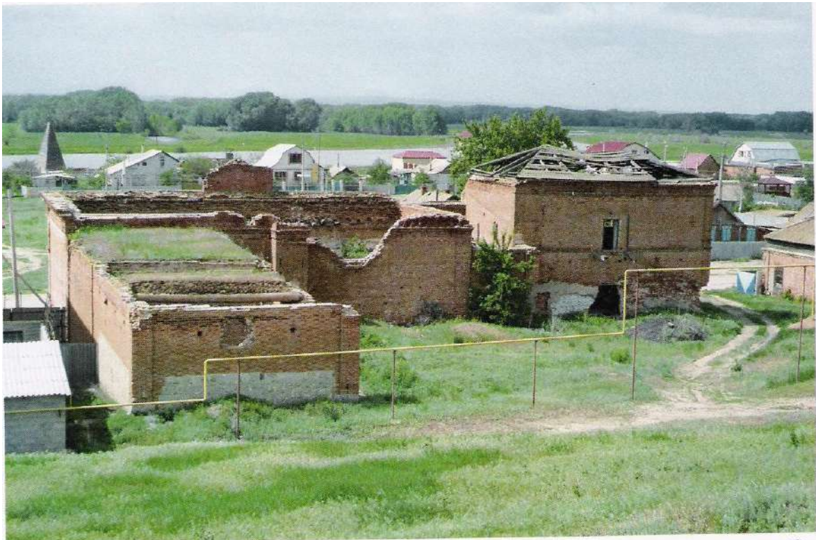
Рис. 5. Волгоградская область, Иловлинский район, Станица Качалинская. Дом купца Бабушкина, торговая лавка, лабазы. Вид со стороны Колокольной. 2010 г.
