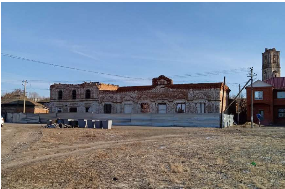
Фото 3. Дальний вид на северо-западный фасад выявленного объекта культурного наследия – «Домовладение купца Бабушкина» и колокольню церкви св. Троицы с юго-запада
