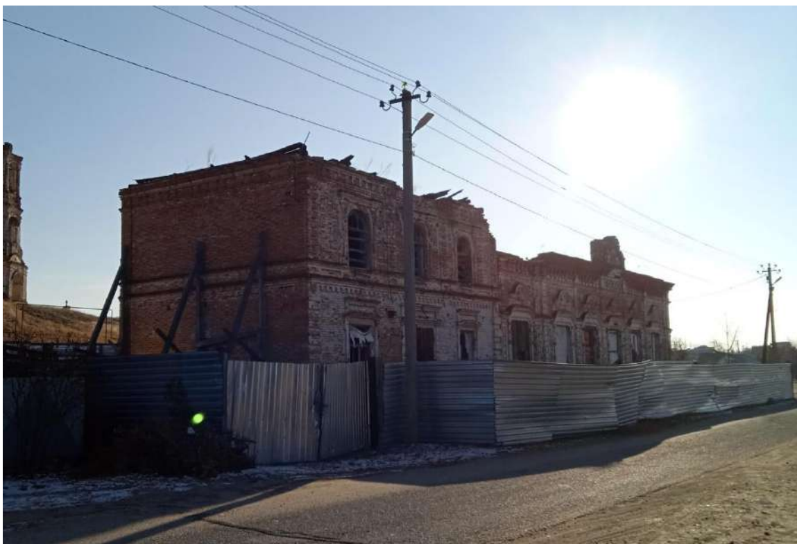
Фото 5. Вид на северо-восточный (торцевой) и северо-западный (главный) фасады здания выявленного объекта культурного наследия – «Домовладение купца Бабушкина» с севера
