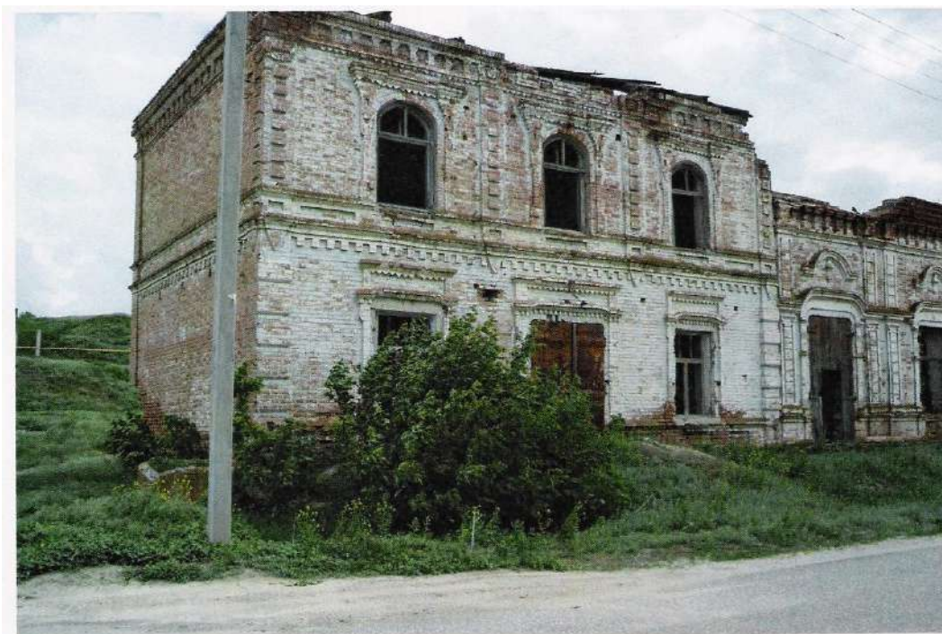
Рис. 2. Волгоградская область, Иловлинский район, Станица Качалинская. Дом купца Бабушкина, 2003 г.
