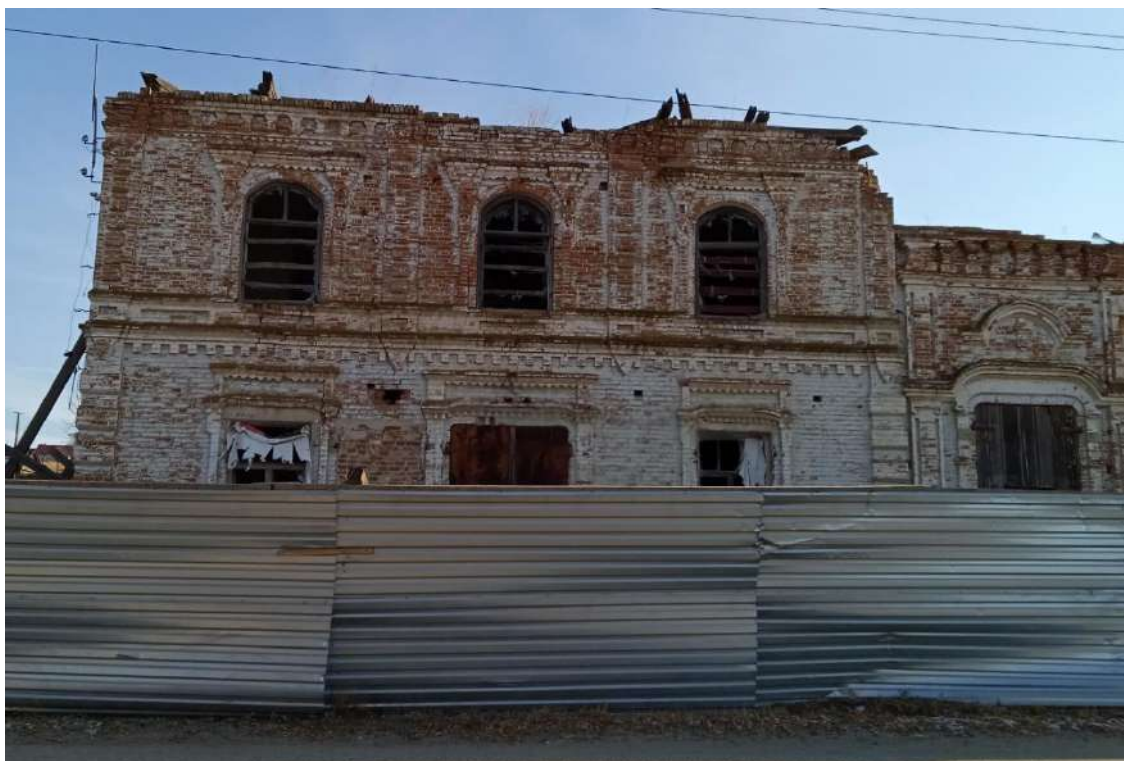
Фото 4. Вид на двухэтажную (северо-западную) часть выявленного объекта культурного наследия – «Домовладение купца Бабушкина» с северо-запада
