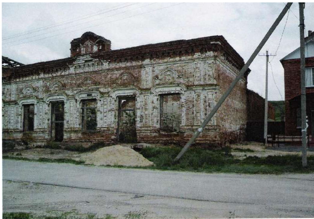
Рис. 1. Волгоградская область, Иловлинский район, Станица Качалинская. Дом купца Бабушкина, 2003 г.
