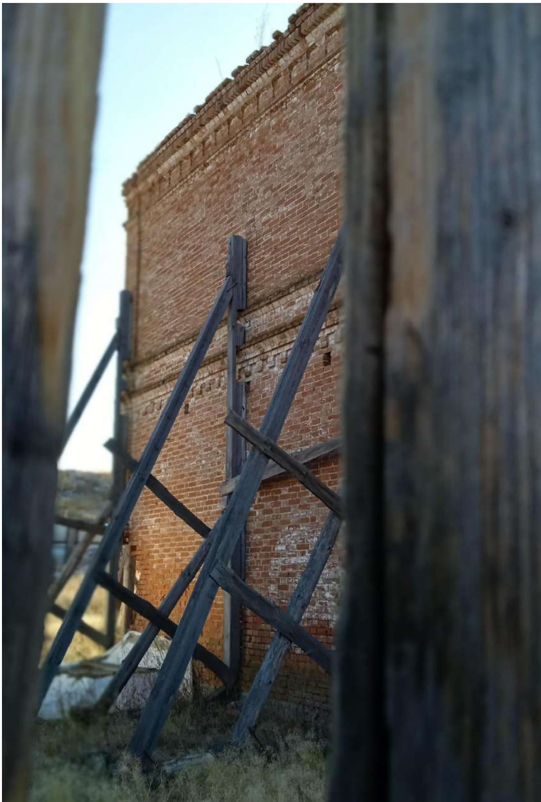
Фото 7. Северо-восточный фасад здания выявленного объекта культурного наследия – «Домовладение купца Бабушкина» с временными страховочными деревянными контрфорсами
