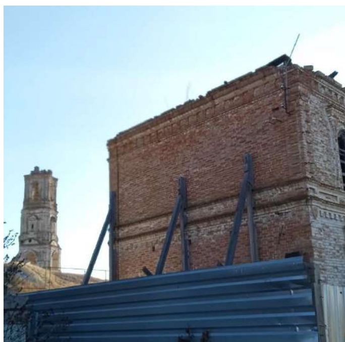
Общий вид на северо-восточный фасад здания с пристройкой
