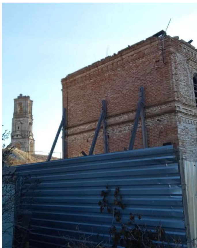
Фото 6. Вид с севера на северо-восточный фасад здания выявленного объекта культурного наследия – «Домовладение купца Бабушкина» и колокольню церкви св. Троицы
