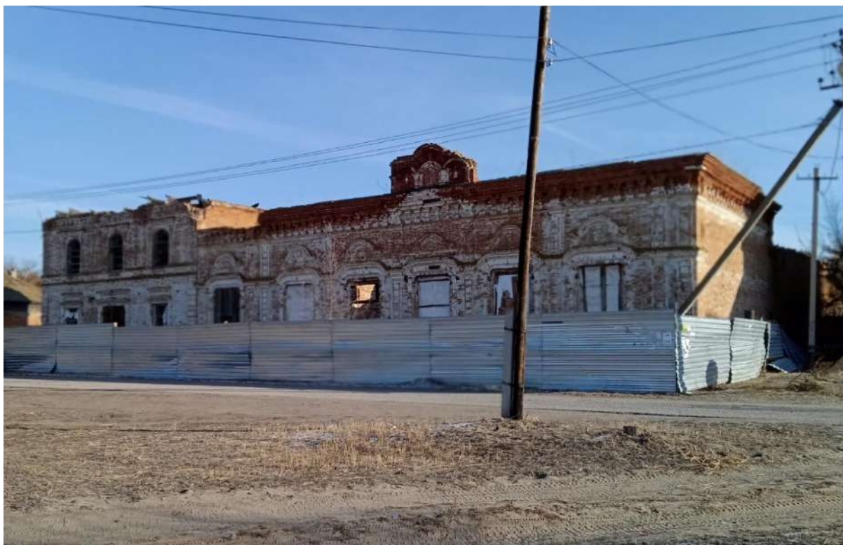
Общий вид на лицевой северо-западный фасад
