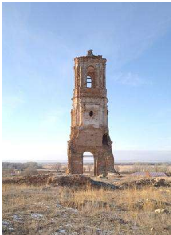
Фото 2. Вид на восточный фасад Колокольни Церкви Святой Троицы
