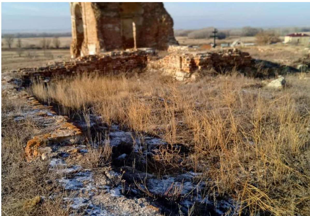
Фото 7. Вид на руины трапезной Церкви Святой Троицы с юго-восточной стороны
