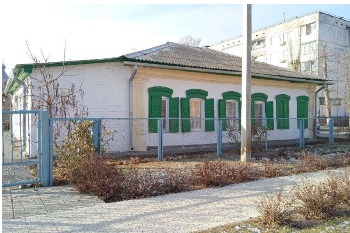
Общий вид на северо-восточный фасад здания с пристройкой
