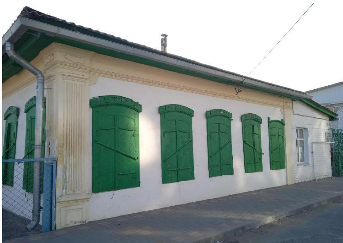
Фото 2. Вид на северный угол здания
