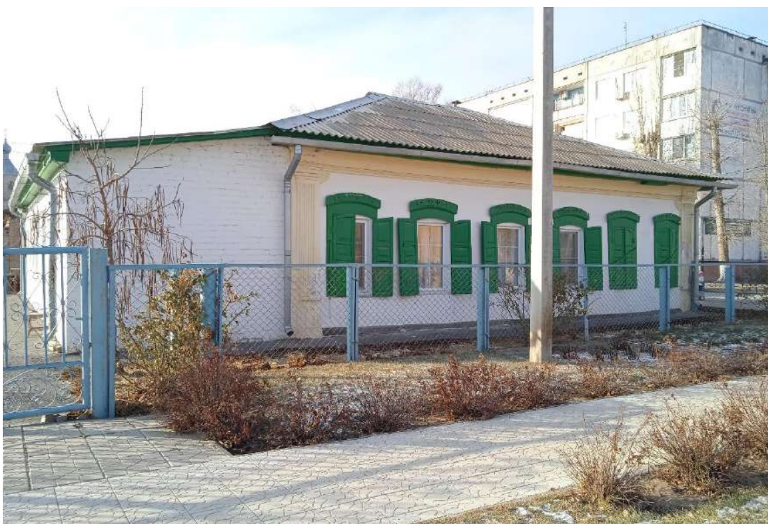
Фото 4 Общий вид на северо-восточный фасад здания с пристройкой
