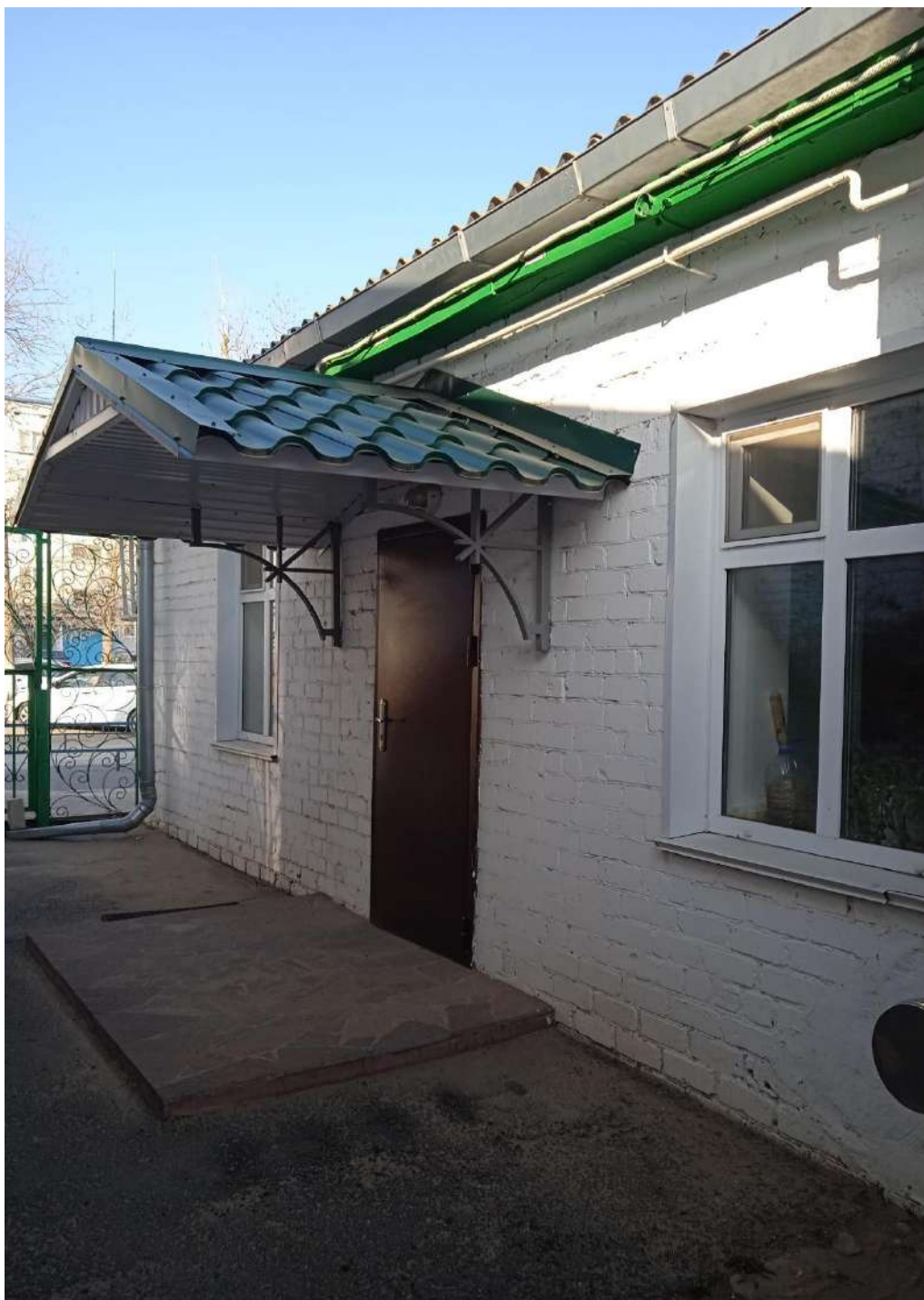
Фото 7. Вход в пристройку с юго-западной стороны здания
