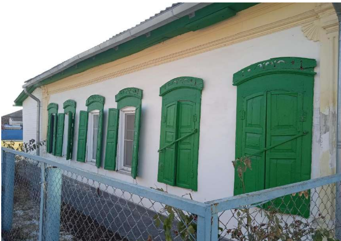
Фото 3. Вид на северо-восточный фасад здания
