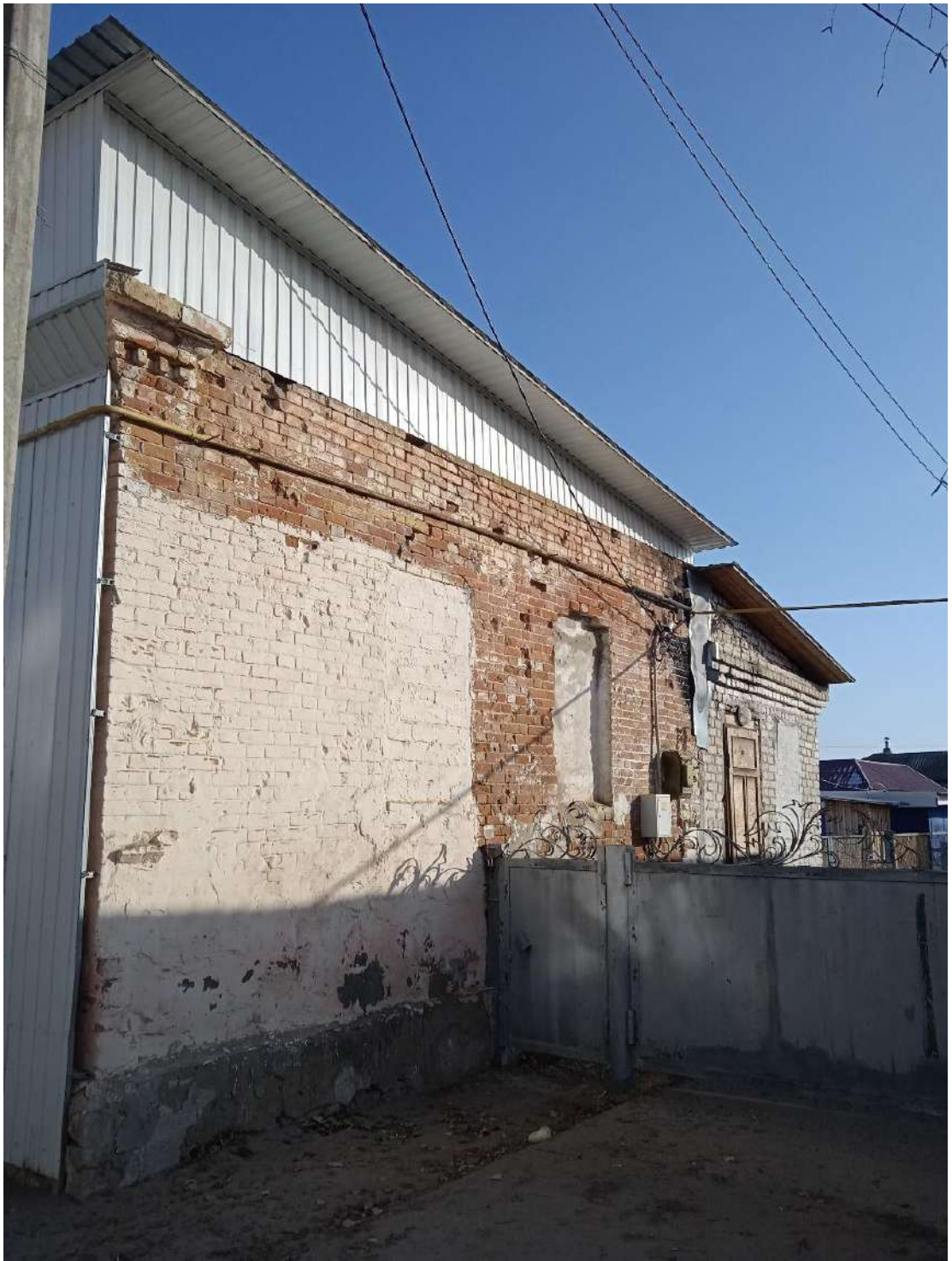
Вид на юго-западный фасад
