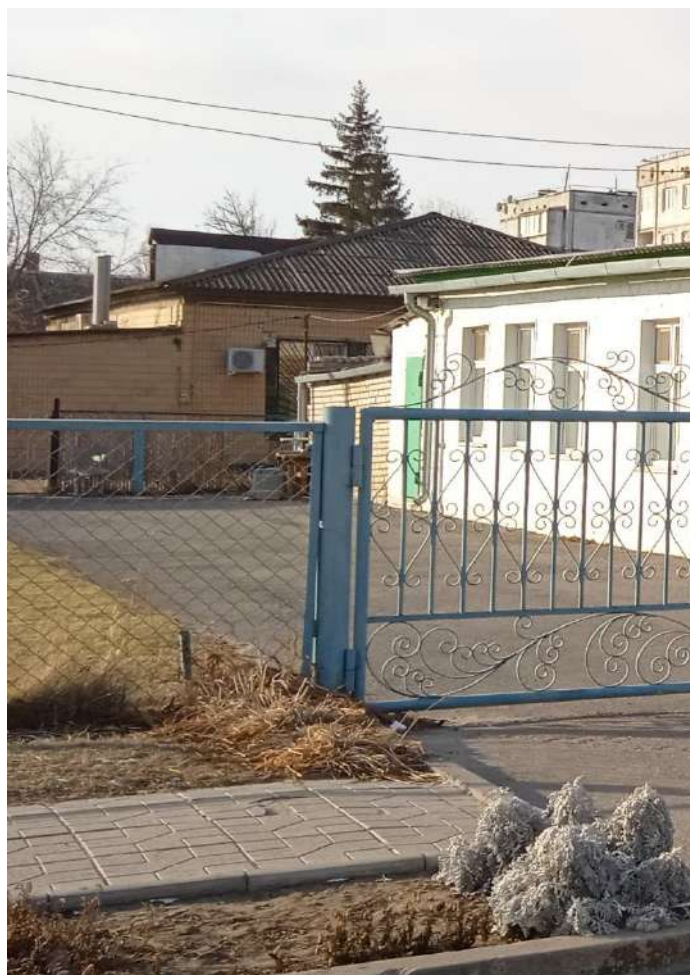
Фото 4. Вид на юго-восточные фасады пристроек к зданиям по ул. Буденного, 49 и 51
