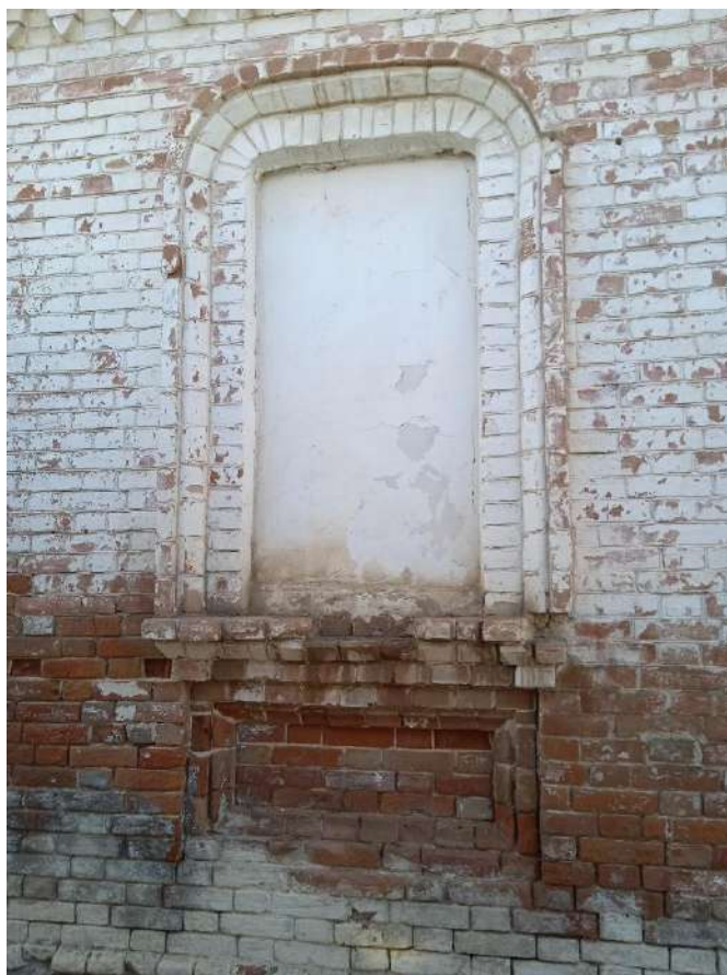
Фото 13. Здание по ул. Буденного, 51. Заложенное окно на северо-восточном фасаде
