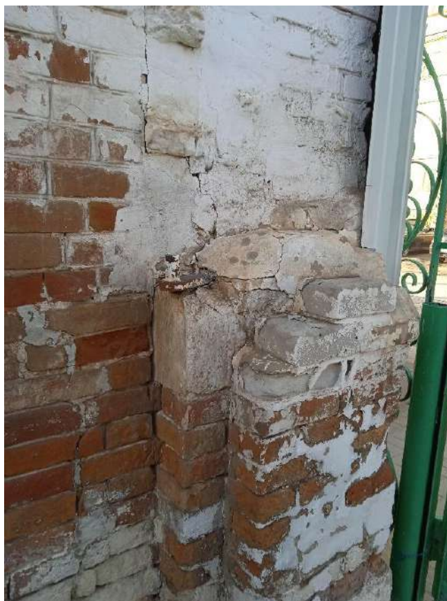
Фото 11. Фрагмент северо-восточного фасада здания по ул. Буденного, 51. Остатки кирпичных ворот с четвертью и подставом
