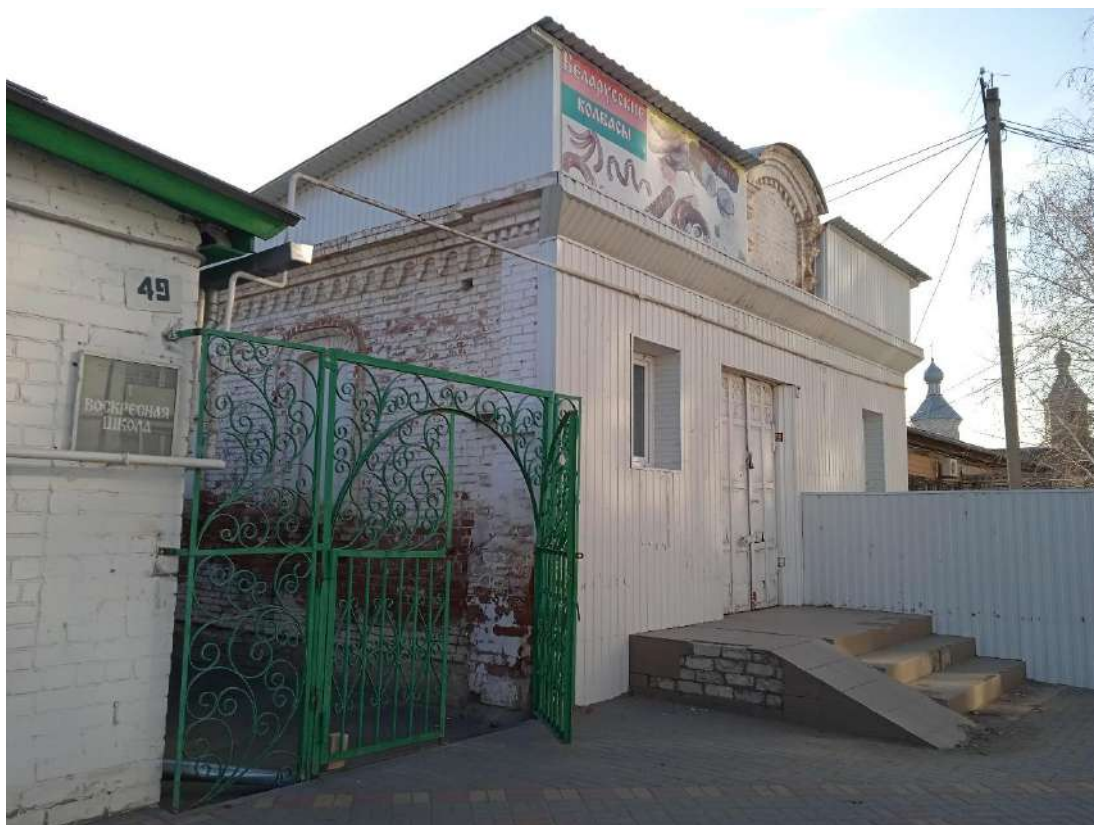
Фото 2. Вид на здание по ул. Буденного, 51 с северной стороны
