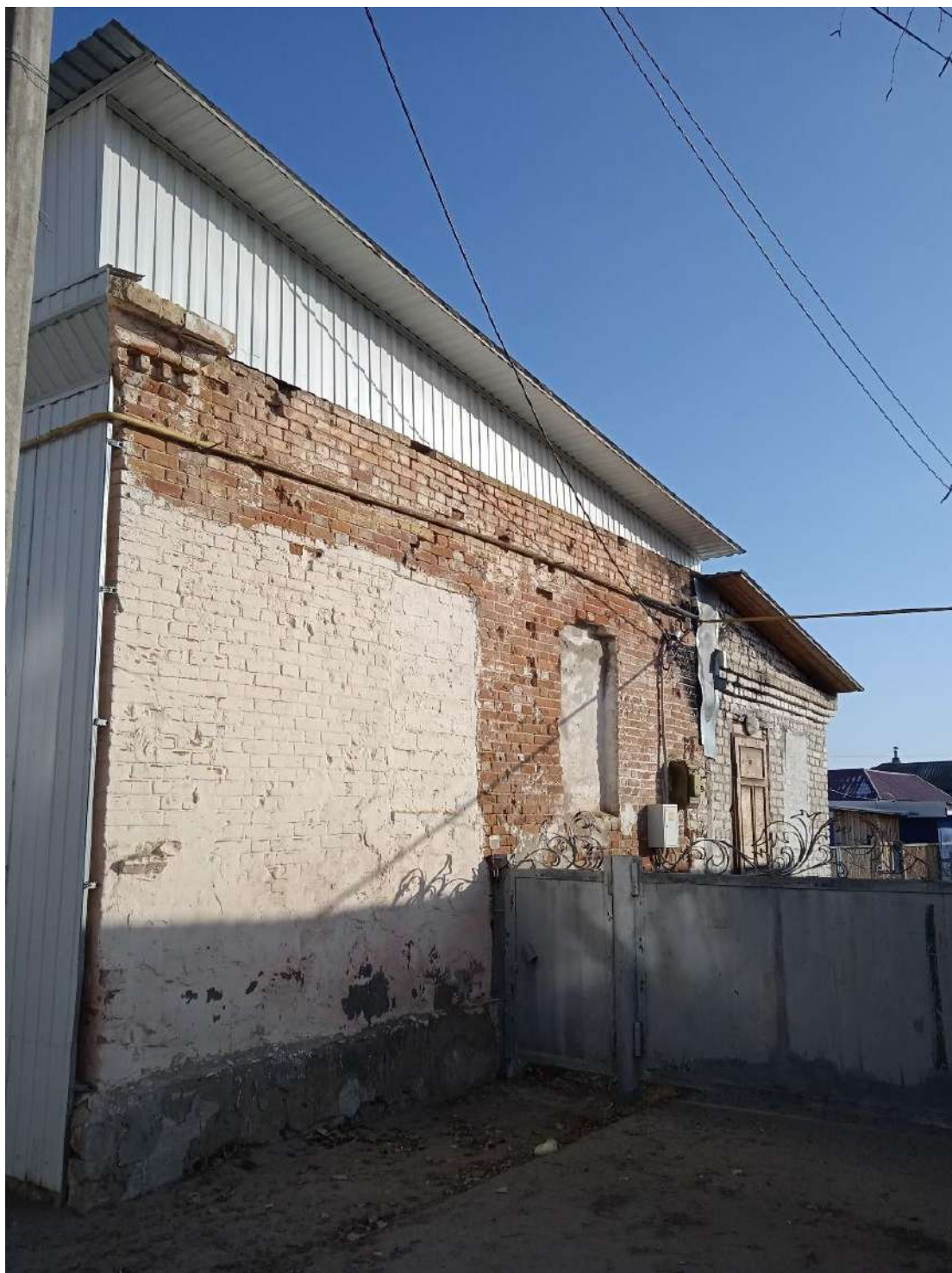
Фото 5. Вид на юго-западный фасад здания по ул. Буденного, 51
