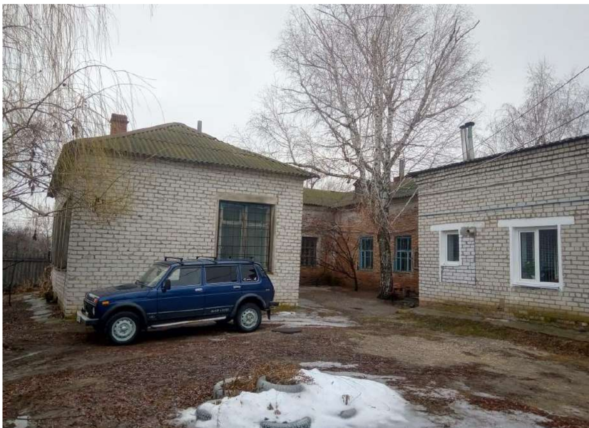
Фото 13. Вид с востока на дворовую территорию, образованную пристройками: к северо-восточному и юго-восточному фасадам здания по ул. Буденного, 71.
