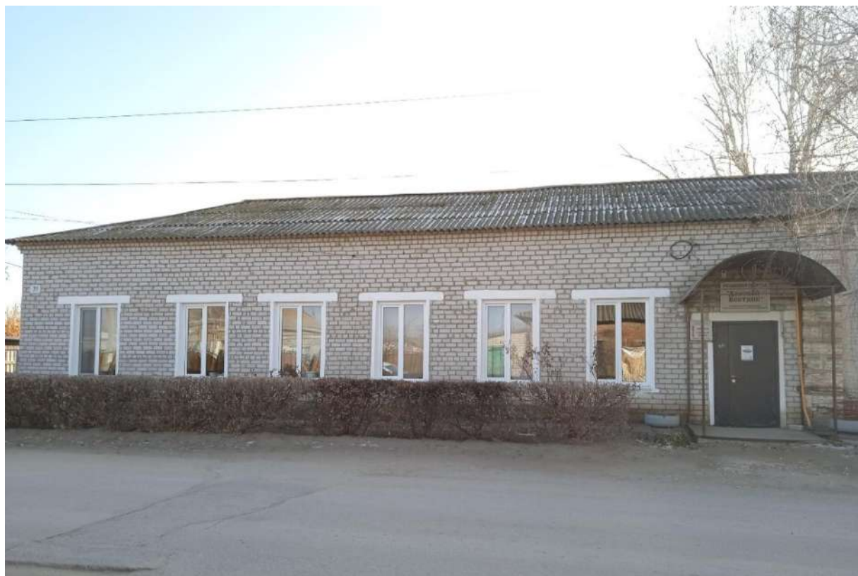
Фото 9. Вид с северо-запада на пристройку к северо-восточному фасаду здания по адресу ул. Буденного, 71.
