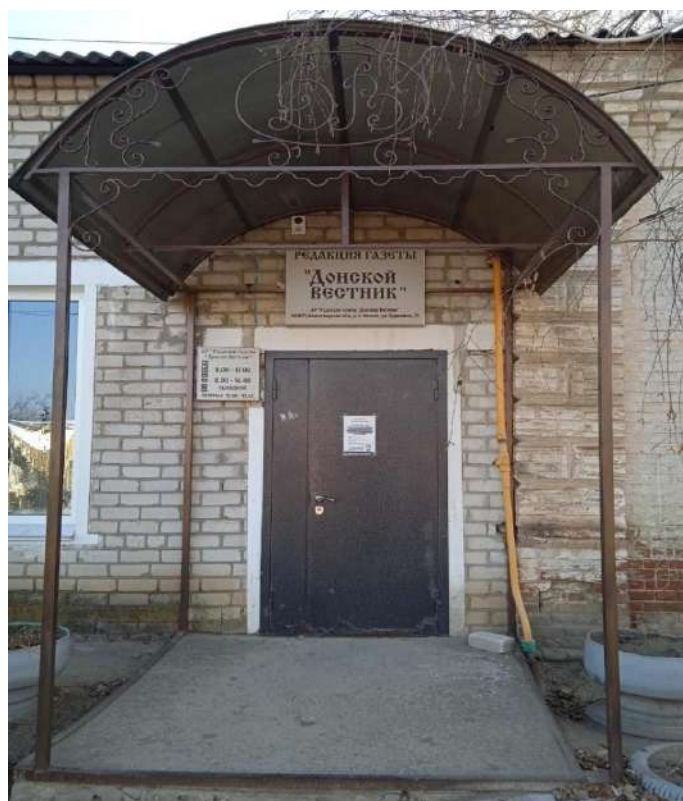
Фото 8. Ближний вид на главный вход в помещение редакции газеты «Донской вестник» на северо-западном фасаде пристройки.
