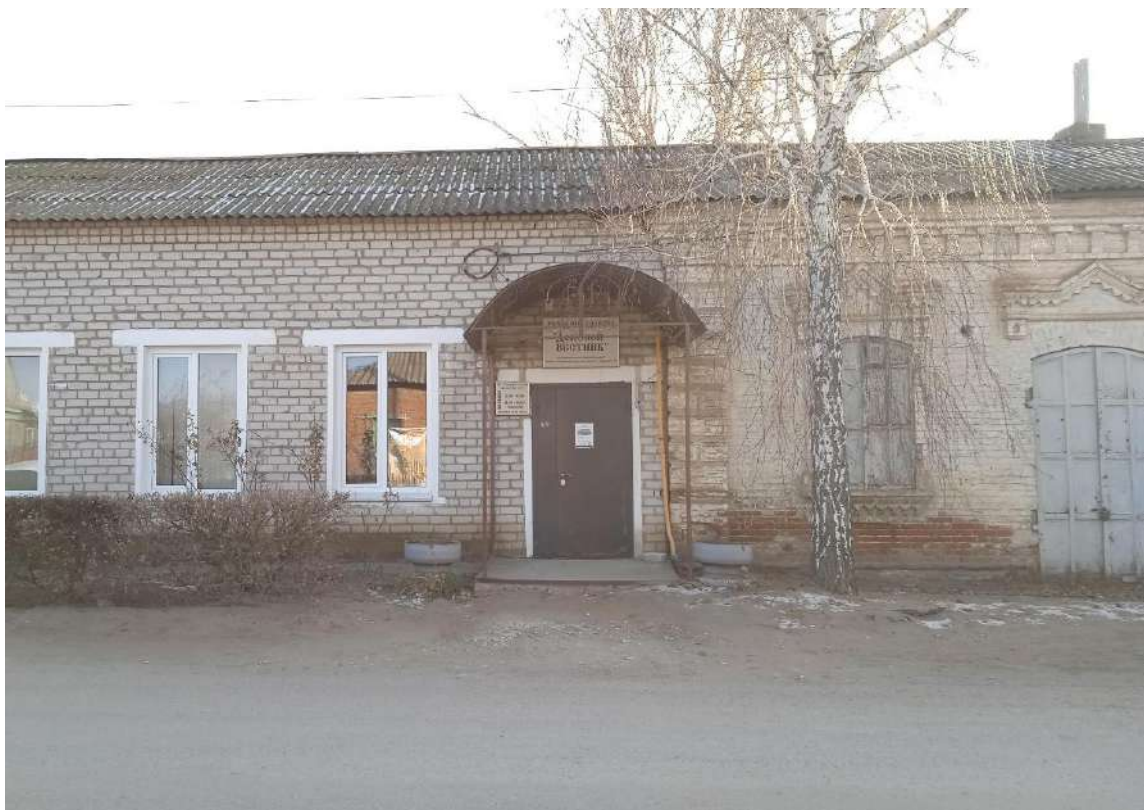
Фото 7. Вид на примыкание пристройки (в настоящее время - редакция газеты «Донской вестник») к зданию бывшей торговой лавки по ул. Буденного, 71.
