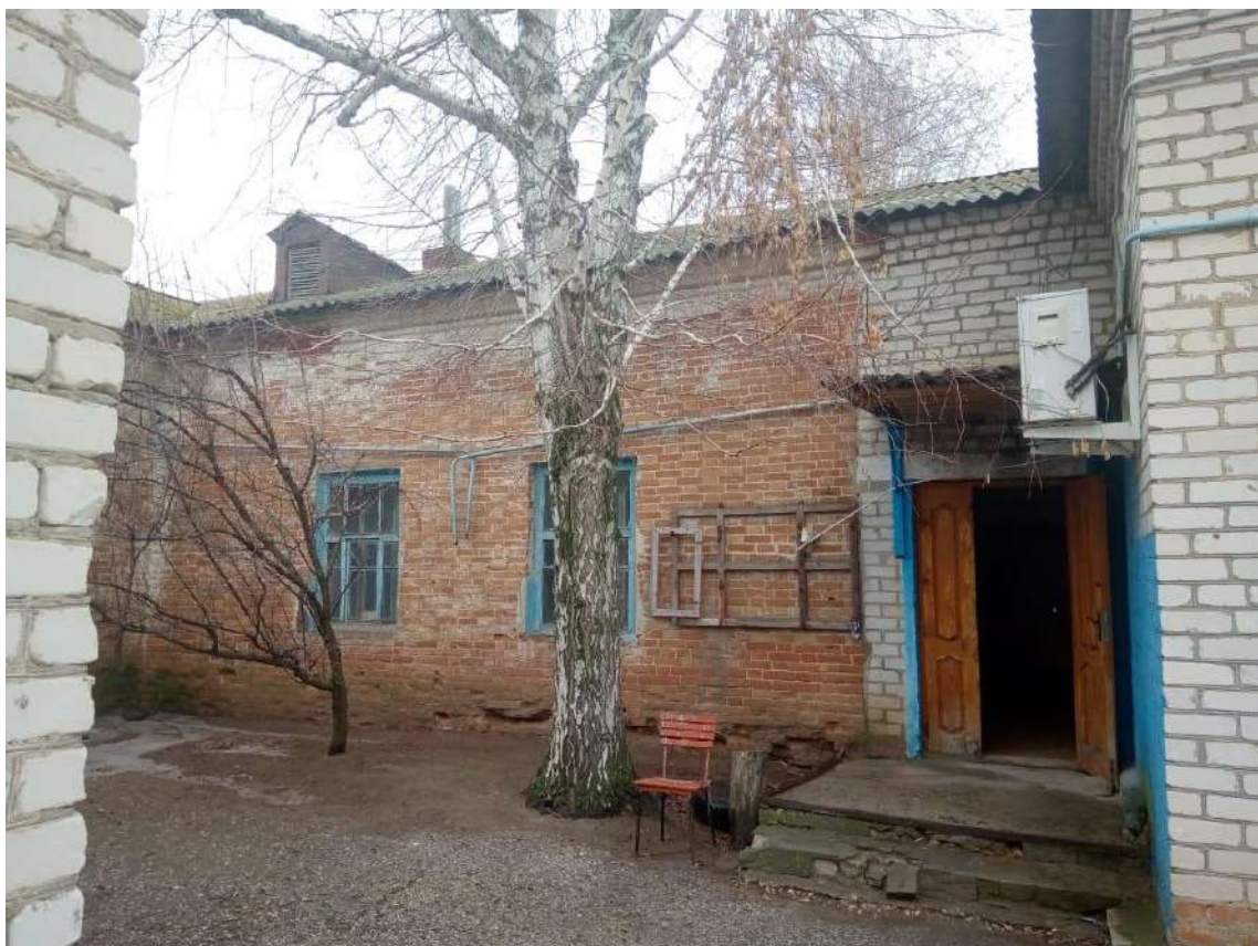
Фото 15. Дворовый фасад здания по ул. Буденного, 71 в месте примыкания к северо-восточному торцевому фасаду.
