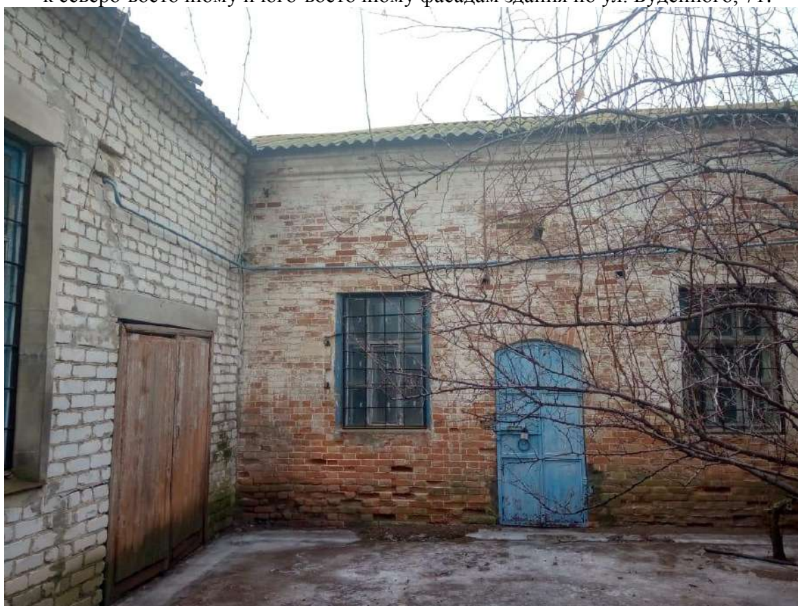
Фото 14. Вид на северо-восточный фасад дворового флигеля здания по ул. Буденного, 71 (фрагмент) и часть пристройки к его юго-восточному фасаду.
