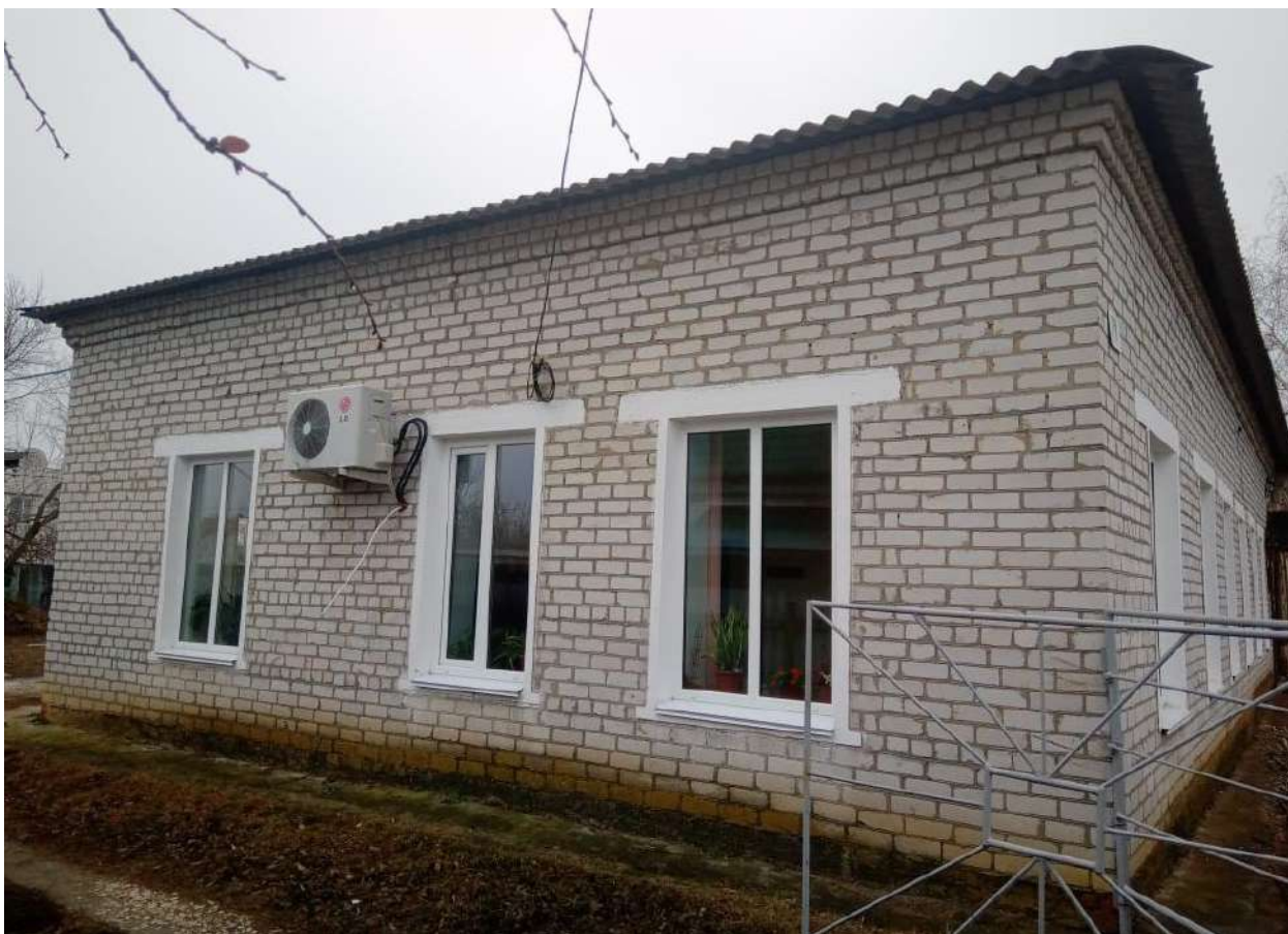
Фото 11. Вид на северо-восточный фасад пристройки.
