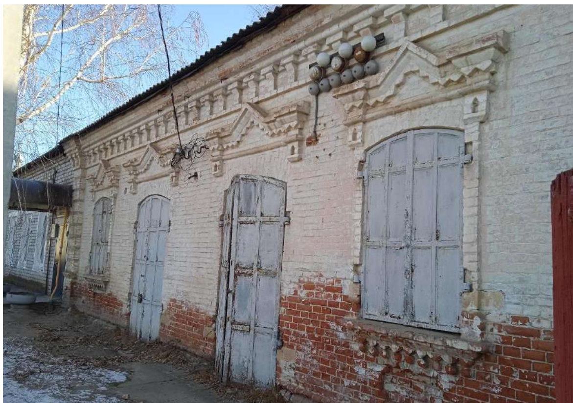
Фото 6. Кованые ставни на двери и окна северо-западного фасада здания по ул. Буденного, 71. Фрагмент.
