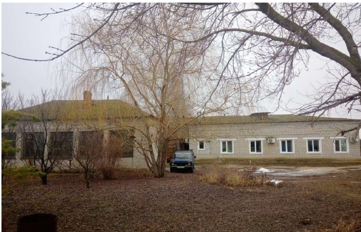
Фото 12. Вид с юго-востока на дворовую территорию, образованную пристройками: к северо-восточному и юго-восточному фасадам здания по ул. Буденного, 71.
