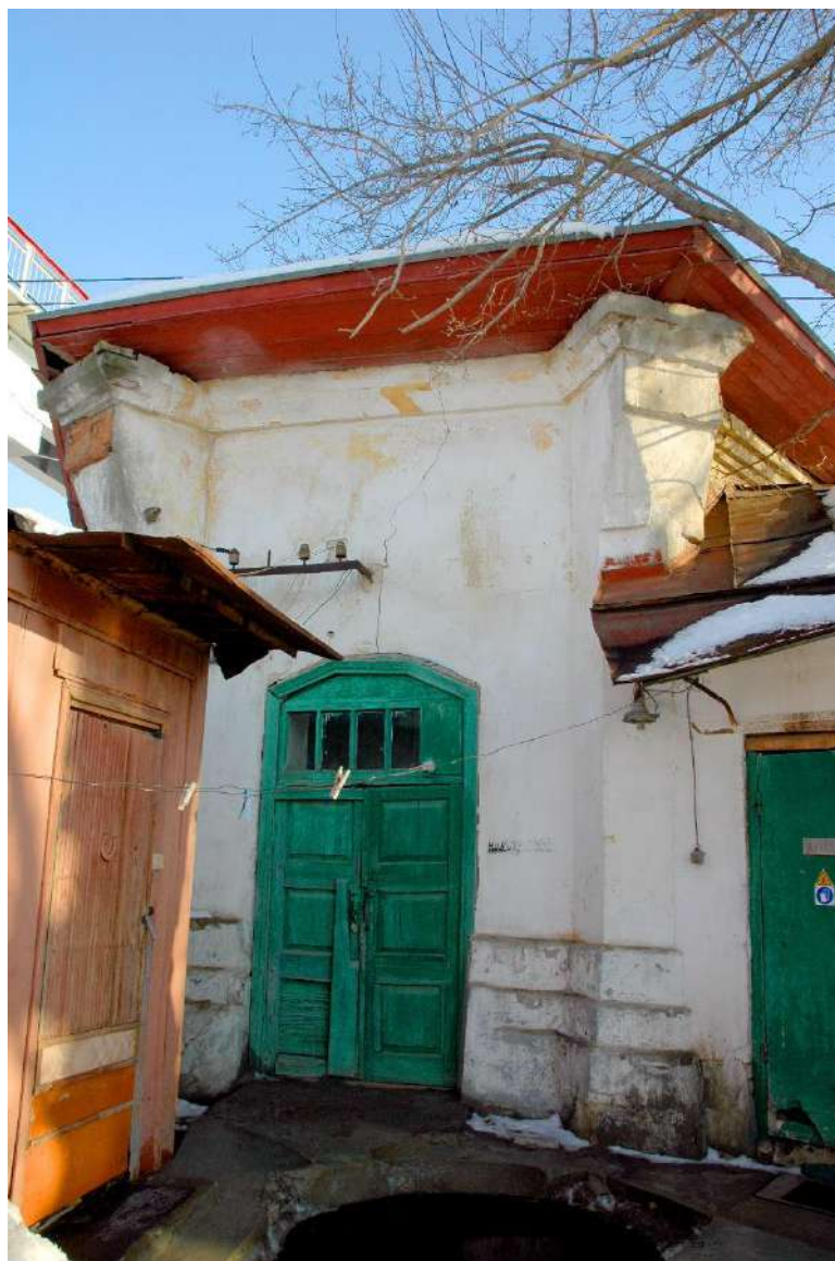
. Вид на юго-западный фасад здания насосной станции и часть пристройки к ее юго-западному фасаду
