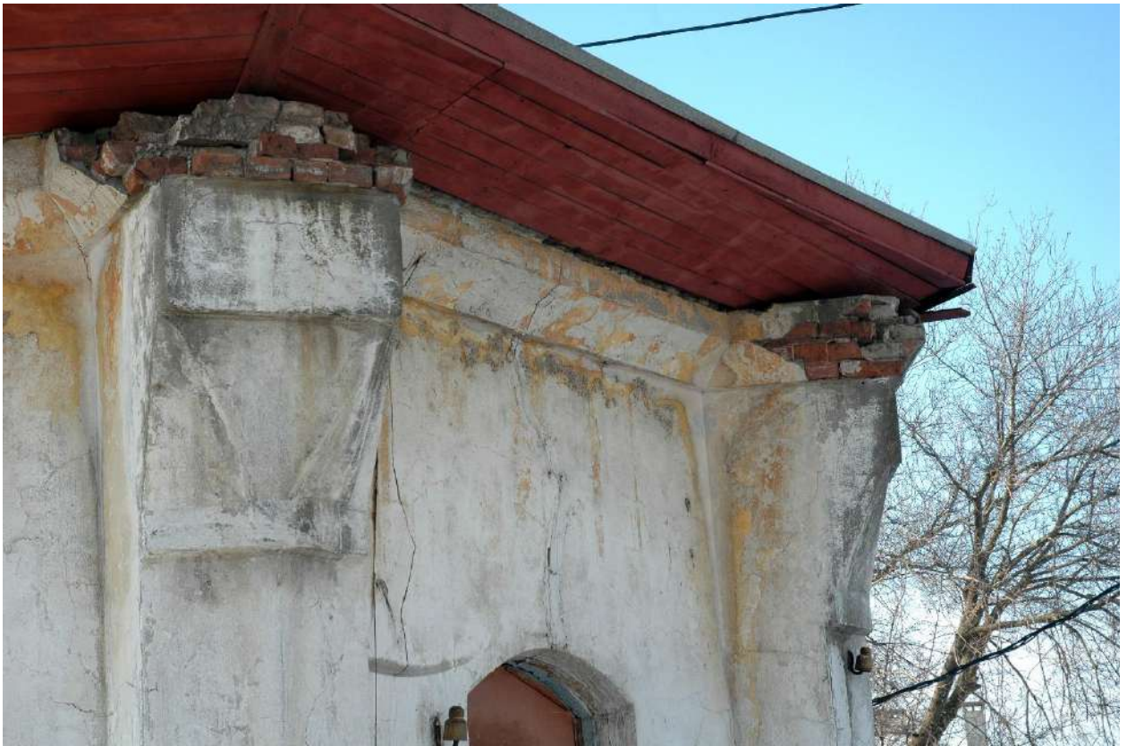
Фото 3. Декоративный кронштейн свеса кровли между северо-восточным и северным фасадами здания насосной станции
