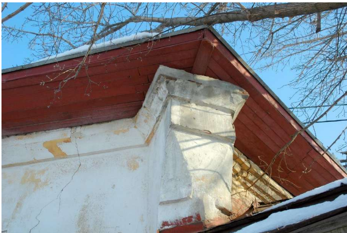
Фото 5. Кронштейн свеса кровли между юго-западным (слева) и южным фасадами здания насосной станции
