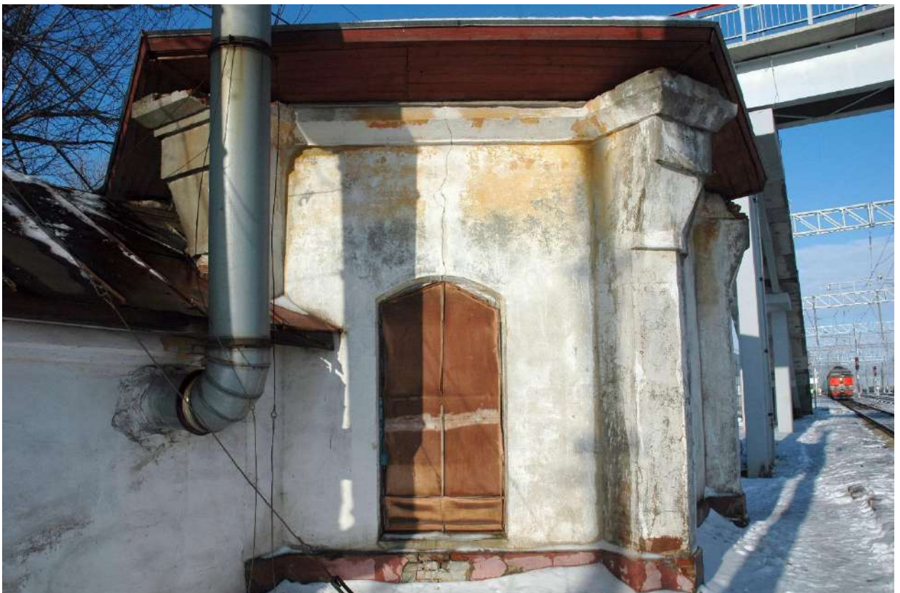
Фото 4. Вид на юго-восточный фасад здания насосной станции и пристройку
