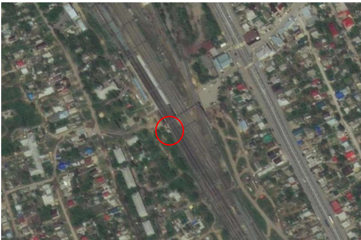
Схема 4. Схема местоположения выявленного объекта культурного наследия «Насосная станция на станции Гумрак Грязе-Царицынской железной дороги», 1871 г, расположенного по адресу: Волгоградская область, г. Волгоград, Дзержинский район, п. Гумрак. (Аэрофотосъемка)
