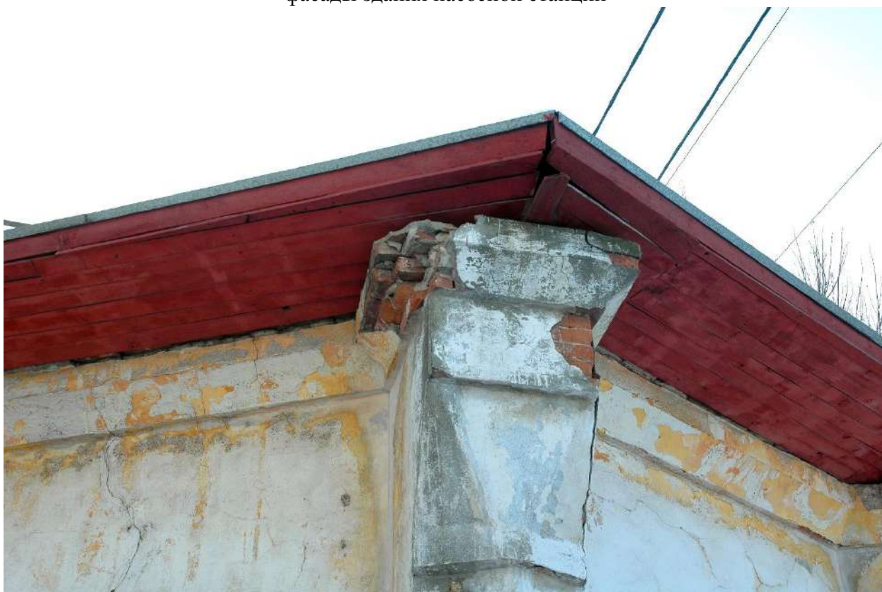
Фото 10. Кронштейн свеса кровли между северным (слева) и северо-западным фасадами здания насосной станции
