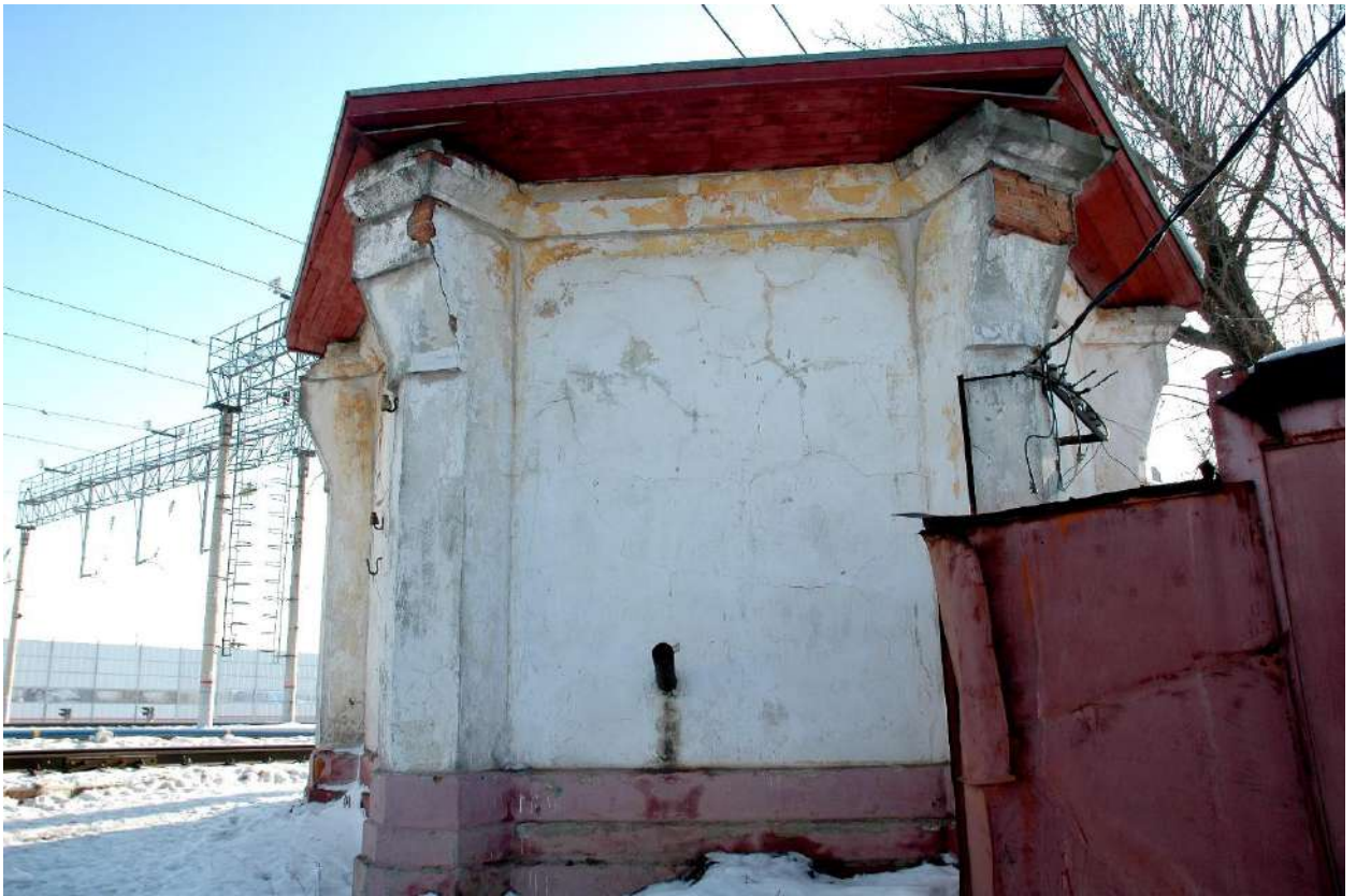
Вид на северо-западный фасад здания насосной станции
