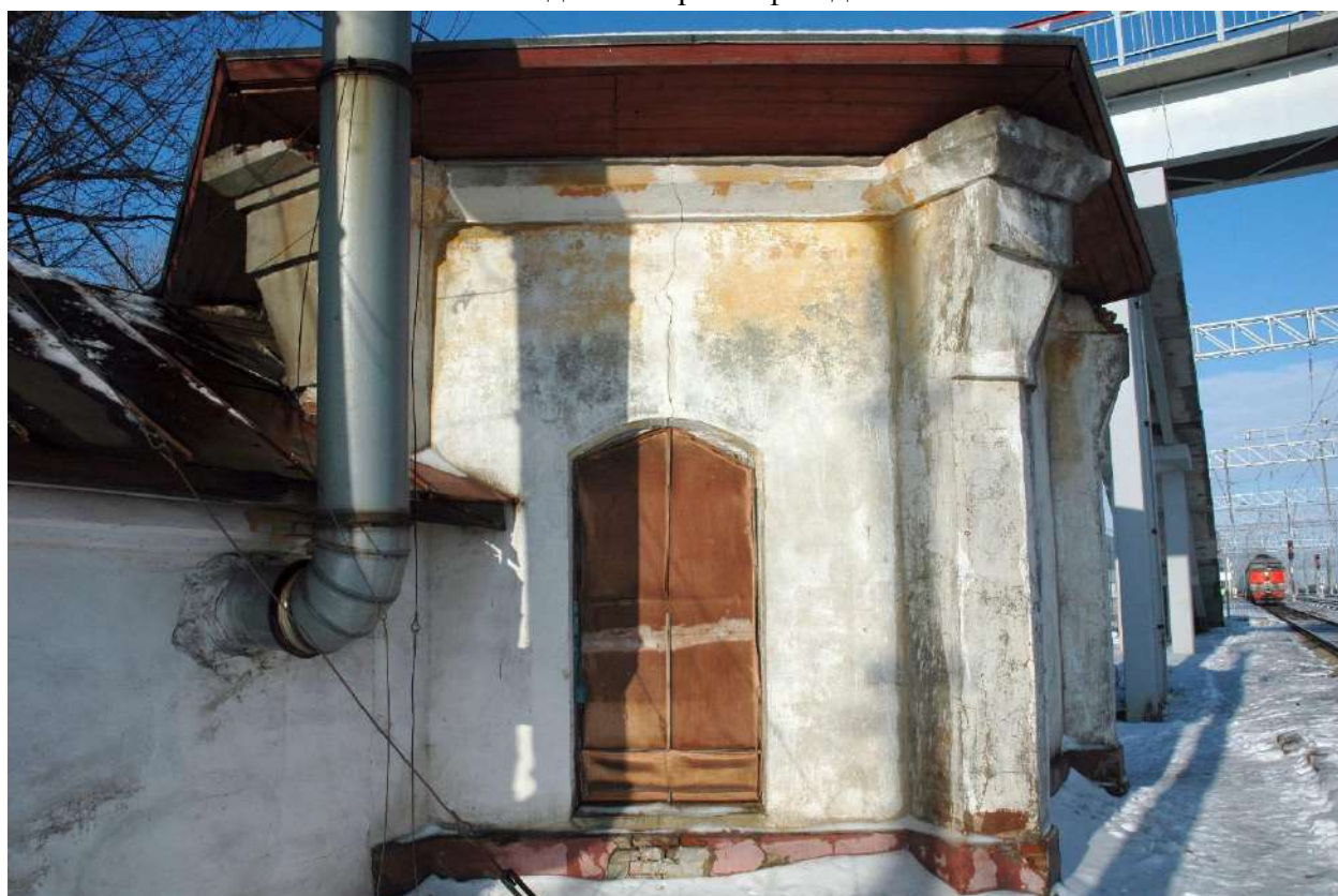
Вид на юго-восточный фасад здания насосной станции и пристройку
