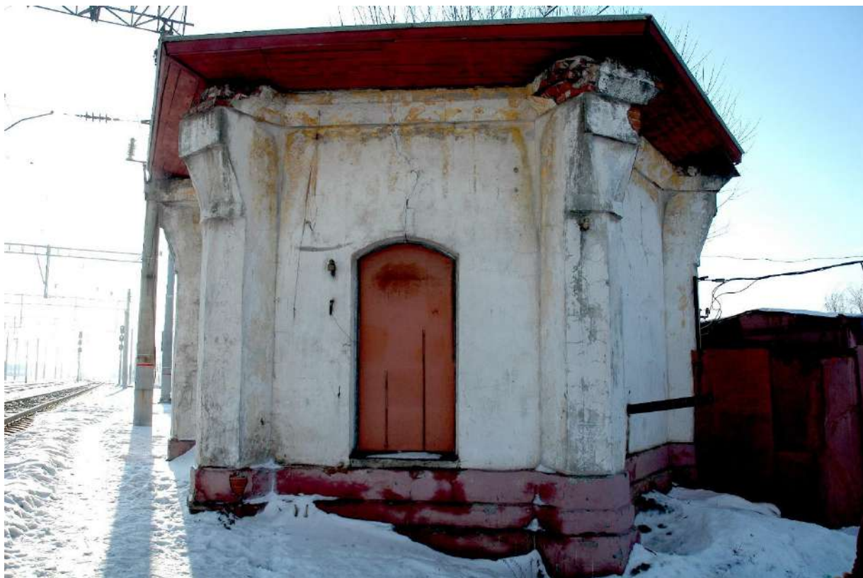
Фото 1. Вид на северный фасад выявленного объекта культурного наследия - «Насосная станция на станции Гумрак Грязе-Царицынской железной дороги», 1871 г.
