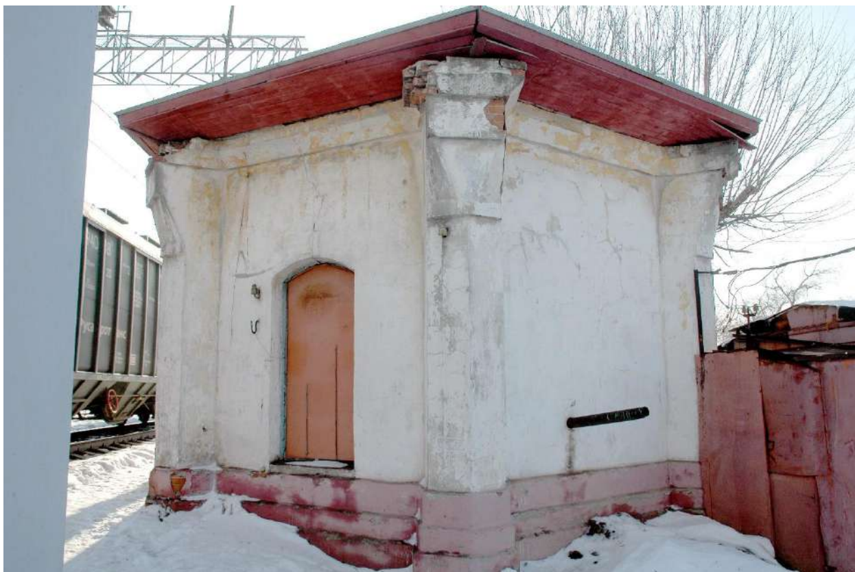
Фото 9. Ст. Гумрак. Насосная станция. Вид на северный (с окном) и северо-западный фасады здания насосной станции
