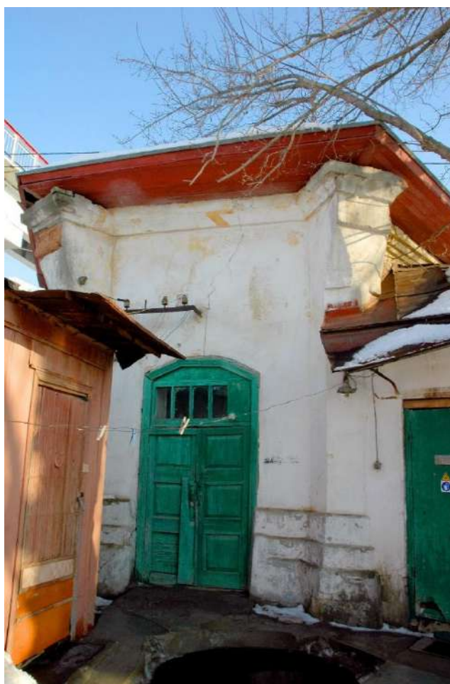
Фото 6. Вид на юго-западный фасад здания насосной станции и часть пристройки к ее южному фасаду
