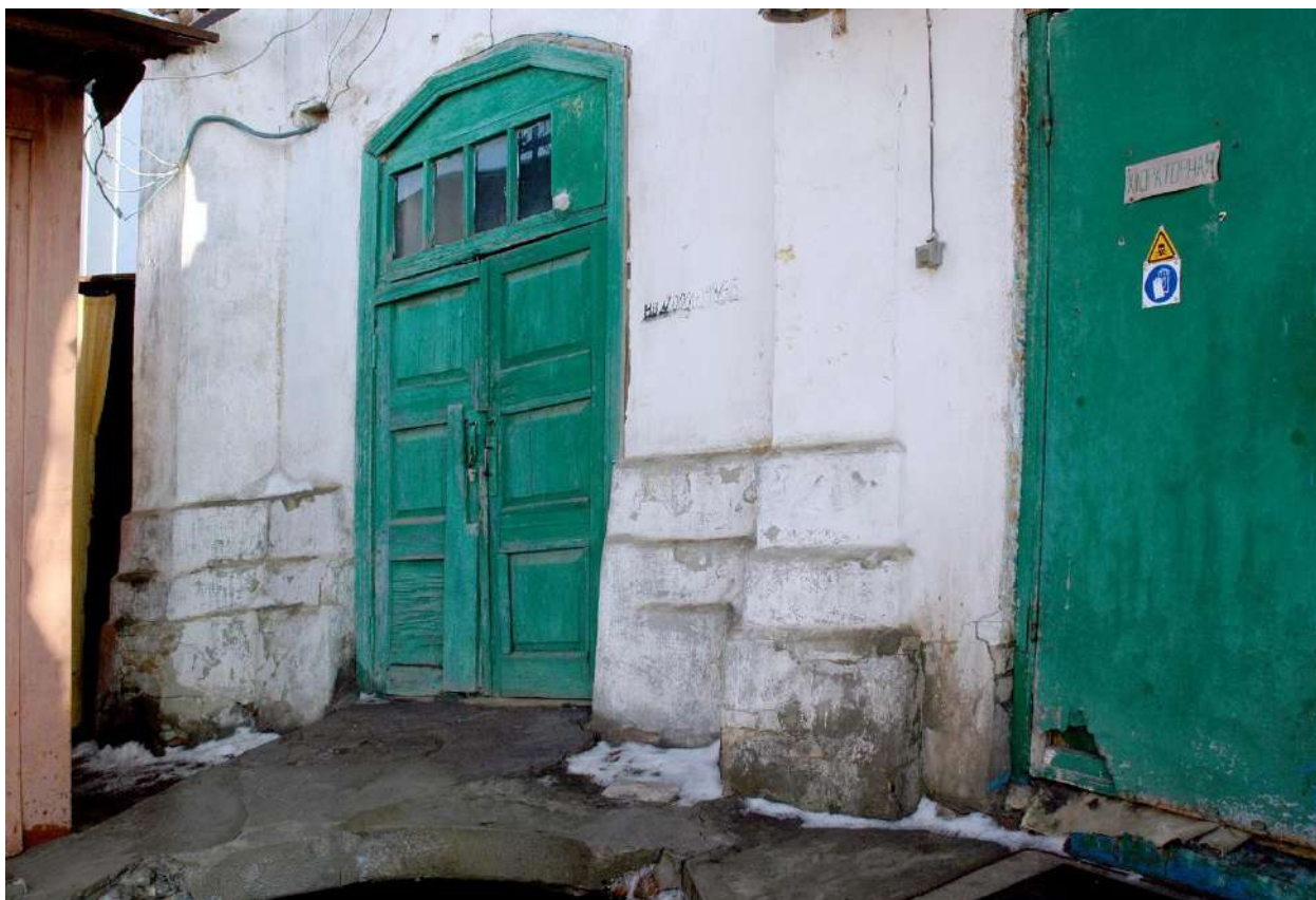
Фото 7. Вид на главный вход в здание насосной станции с юго-западной стороны
