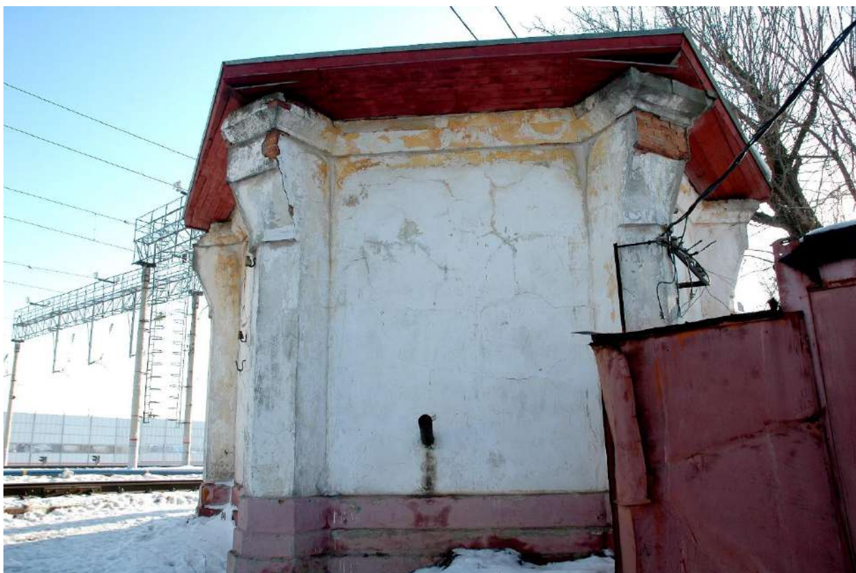
Фото 8. Вид на северо-западный фасад здания насосной станции
