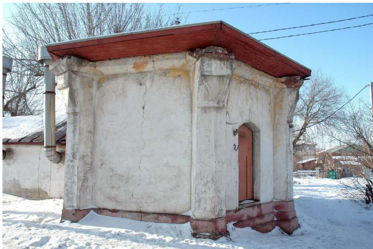
Фото 2. Вид на северный (с окном) и северо-восточный фасады здания насосной станции
