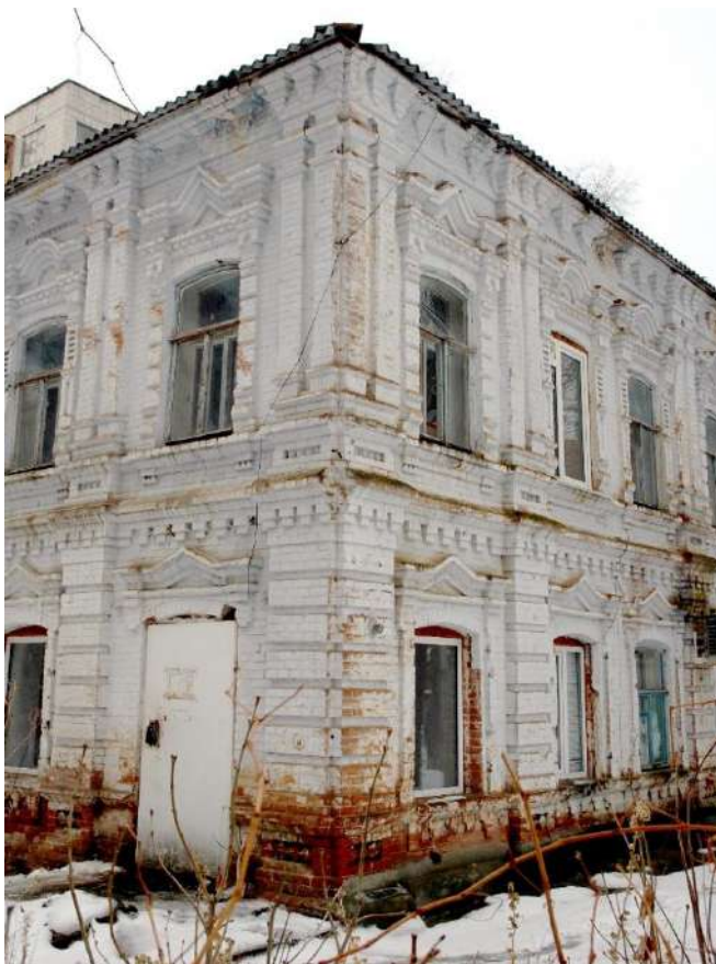
Фото 8. Вид на восточный угол здания
