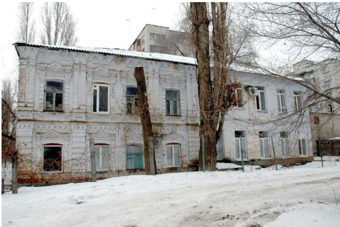
Фото 4. Вид на северо-восточный фасад здания и пристройку (объектом культурного наследия не является) к северо-западному дворовому фасаду
