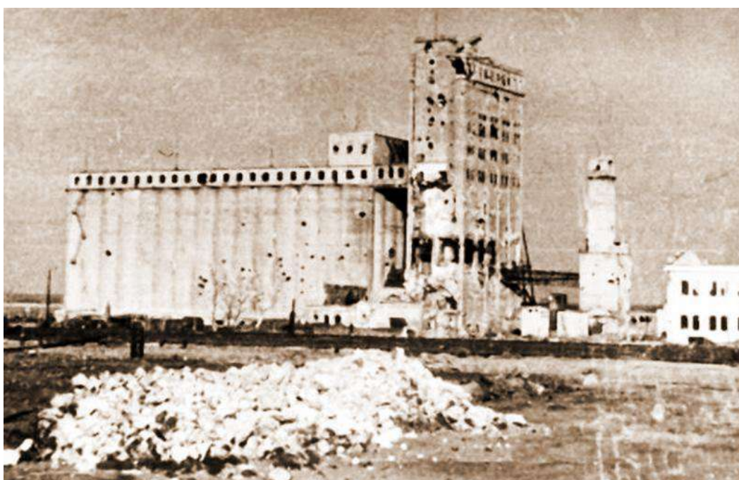
Рис. 2. На фотографиях хорошо видны пробоины в западной стене от 88-мм «флаков» проломы в южном фасаде - результат обстрела 105-мм гаубицами
