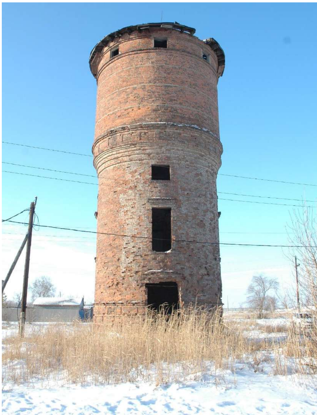
. Вид с северо-востока со стороны железной дороги
