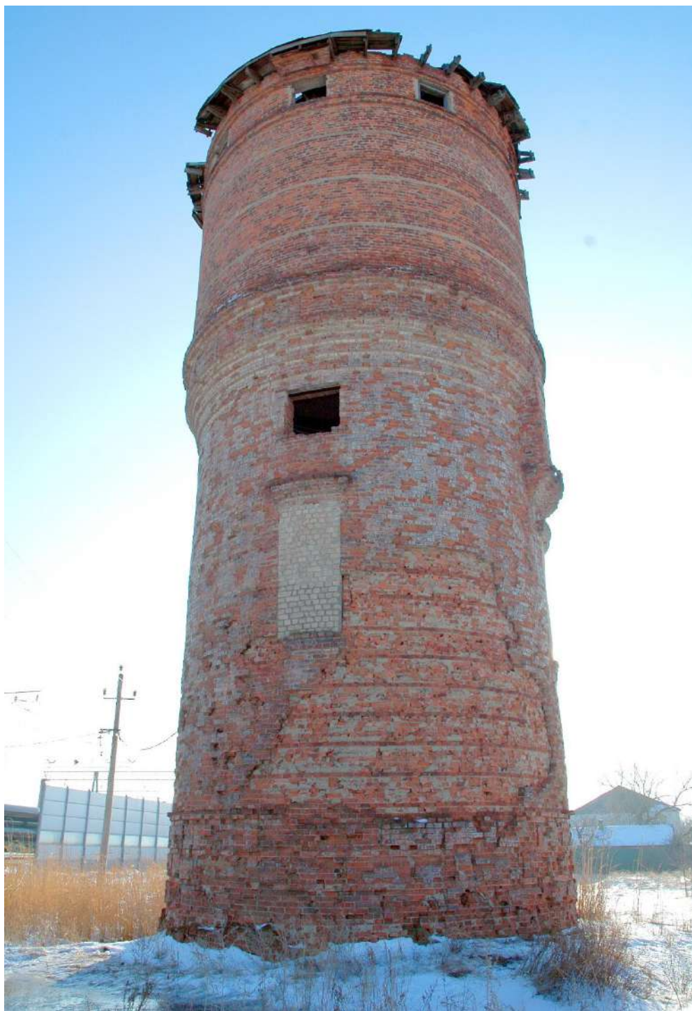
Вид на водонапорную башню с северо-запада
