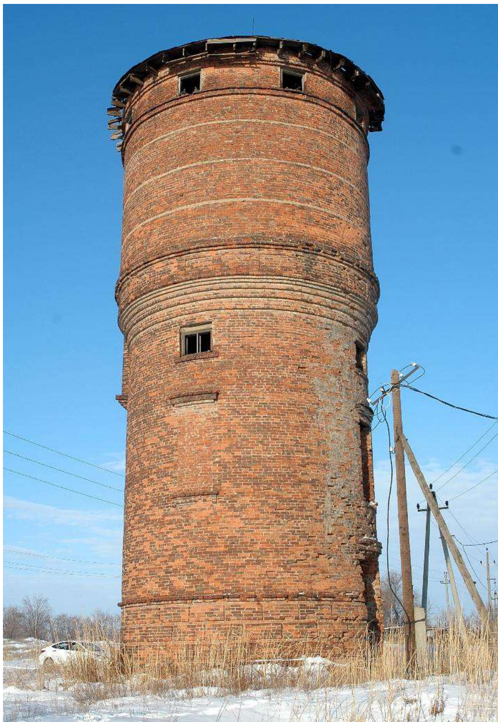
Вид на водонапорную башню с юго-востока
