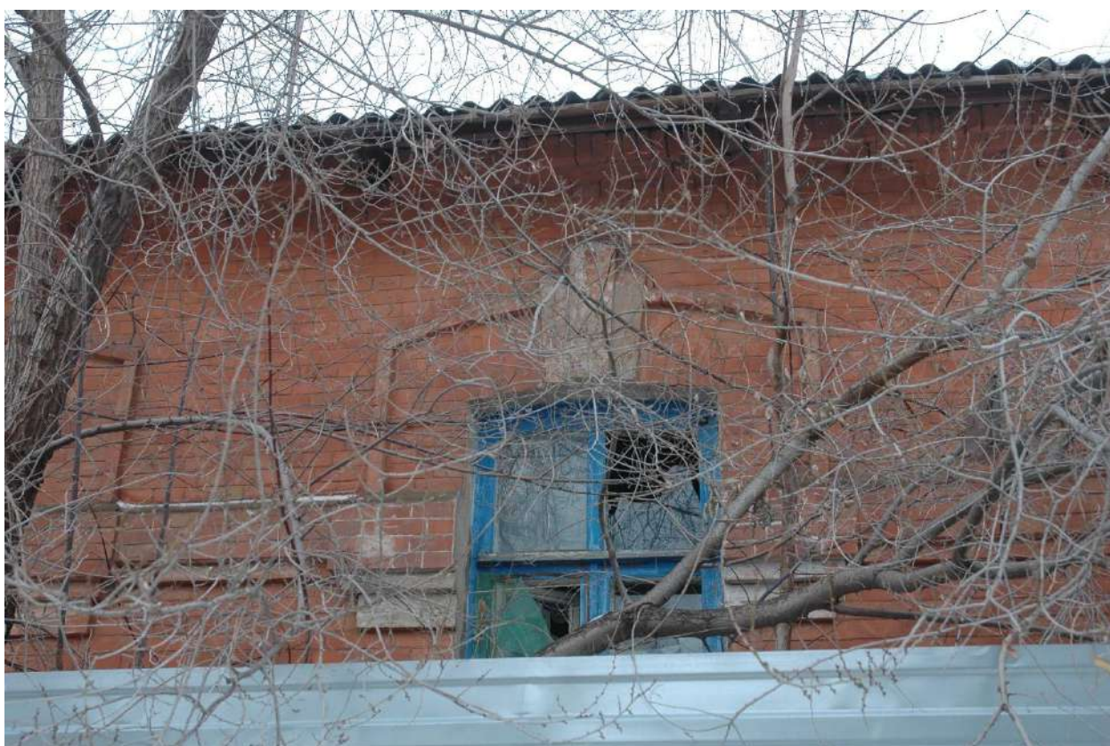
Фото 2. Фрагмент главного фасада (1-я световая ось справа)
