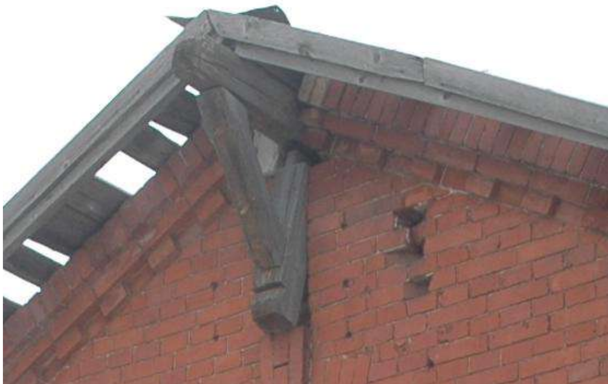
Фото 6. Кронштейн конька свеса кровли на фронте юго-западного фасада
