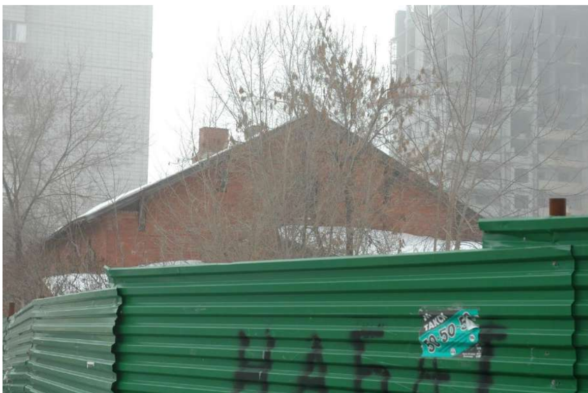
Фото 8. Фрагмент северо-восточного торцевого фасада
