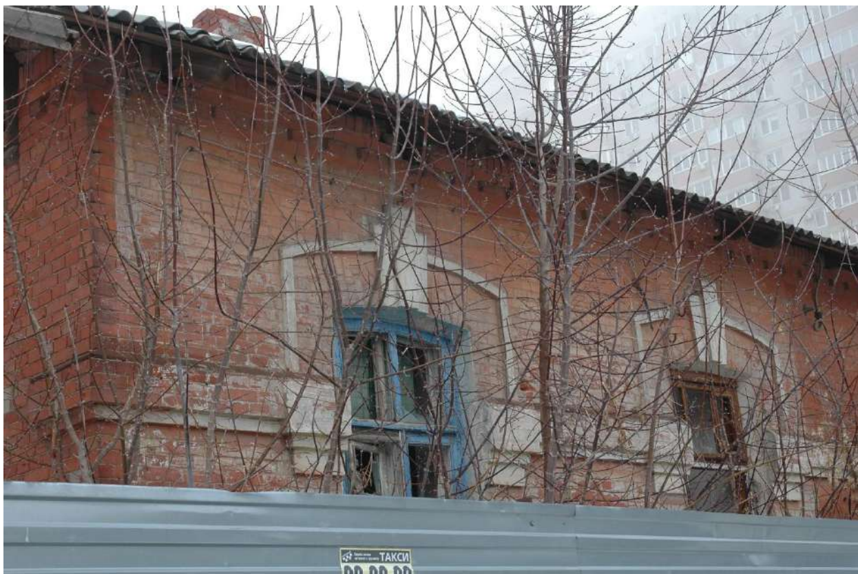
Фото 3. Фрагмент главного юго-восточного фасада
