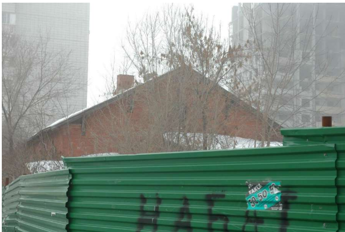
. Фрагмент северо-восточного торцевого фасада
