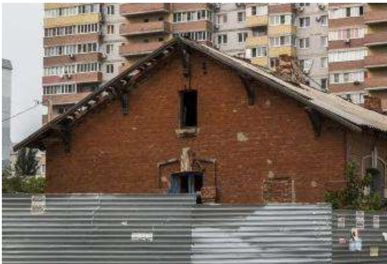
Фото 4. Торцевой юго-западный фасад
