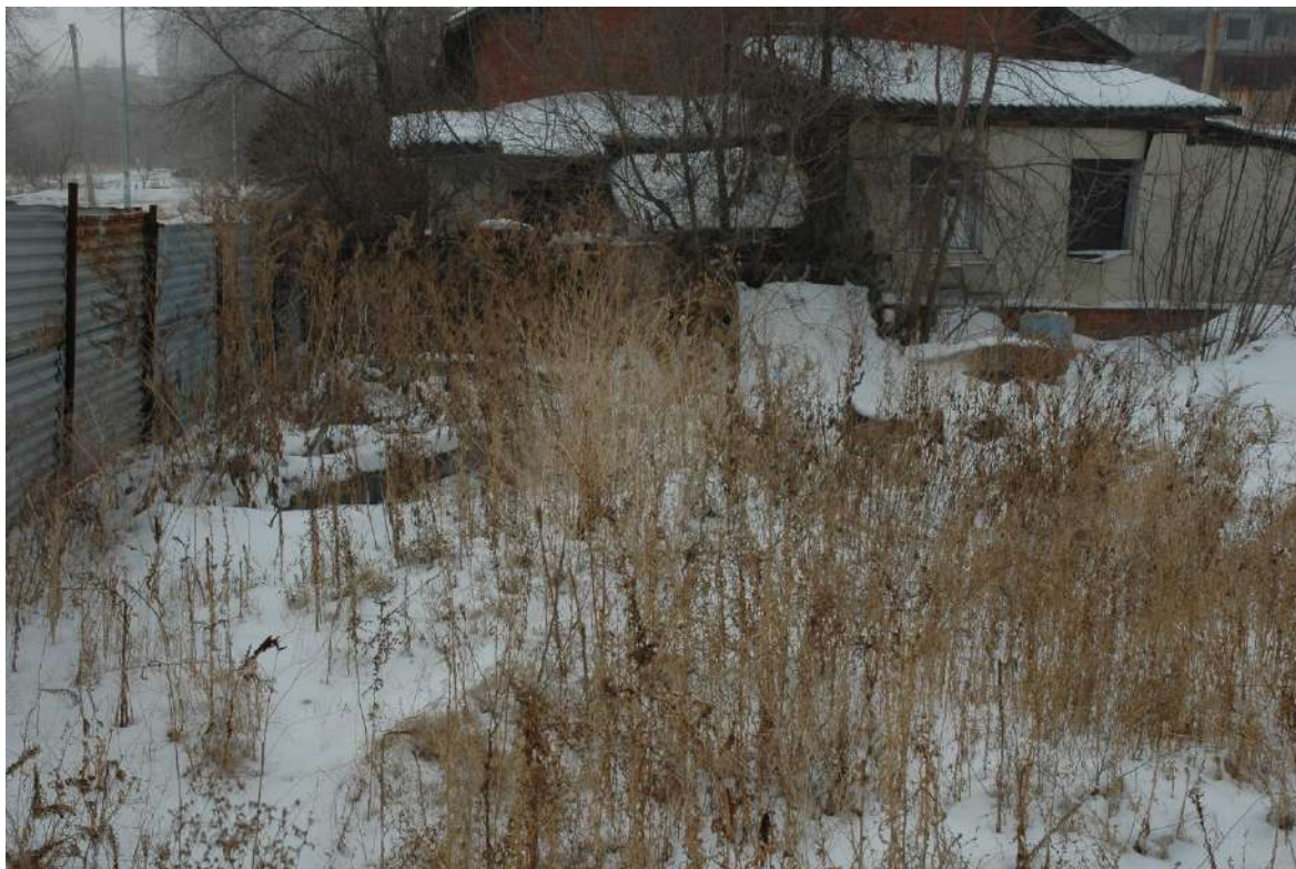
Вид на пристройки к северо-восточному фасаду здания
