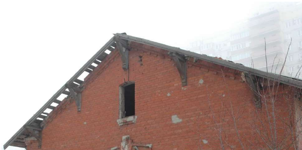
Фото 7. Фронтон юго-западного фасада здания
