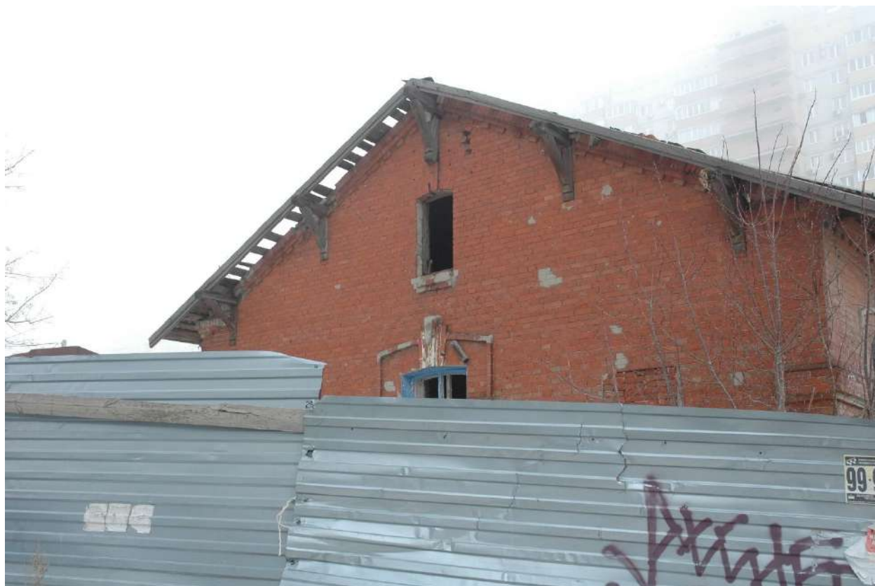
Фото 5. Фрагмент торцевого юго-западного фасада
