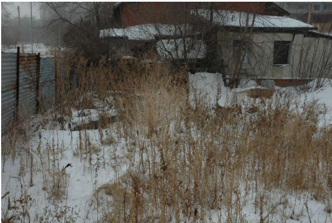
Фото 9. Вид на пристройки к северо-восточному фасаду здания
