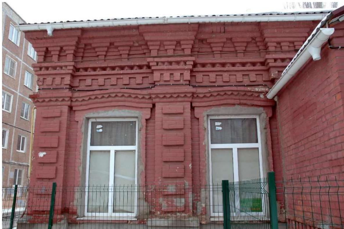
Фото 3. Главный фасад. Фрагмент левой части (1-я и 2-я световые оси)
