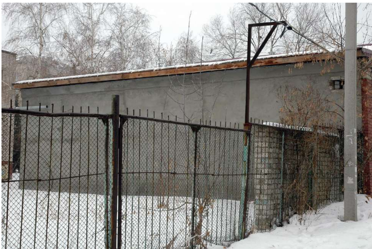
Фото 10. Юго-восточный фасад пристройки к зданию
