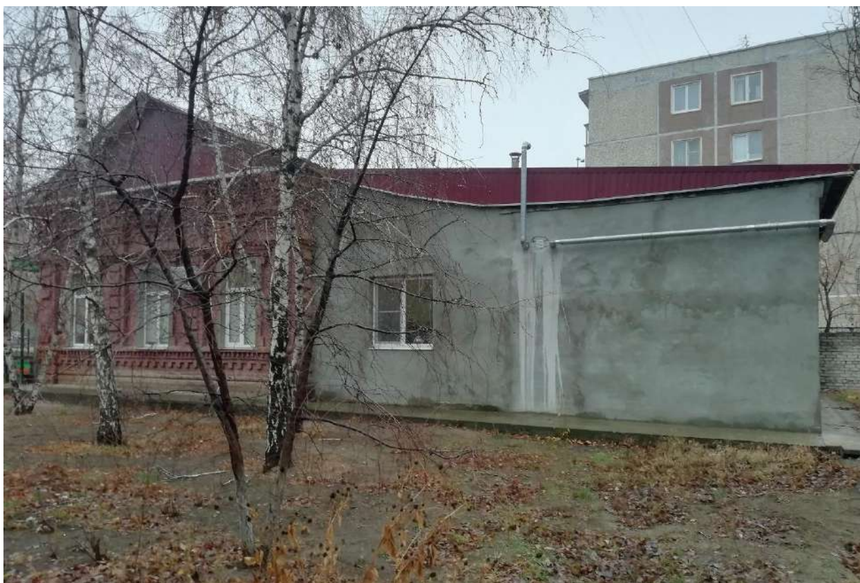
Фото 12. Вид на юго-западный фасад здания с пристройкой в 1 световую ось с территории детского сада
