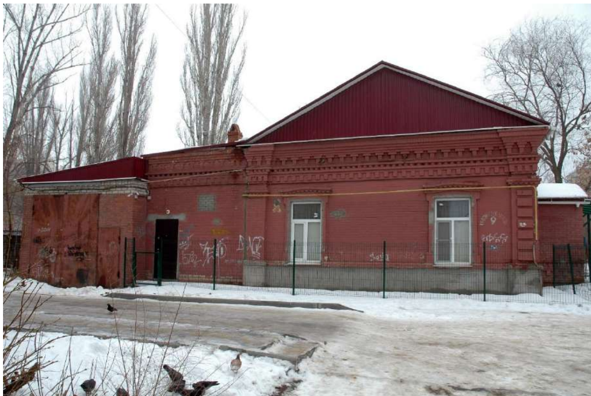
Фото 7. Северо-восточный фасад здания с пристройками к основному объему здания
