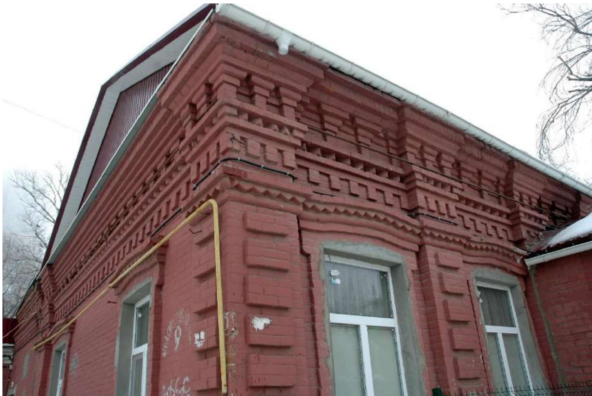
Фото 5. Северный угол здания
