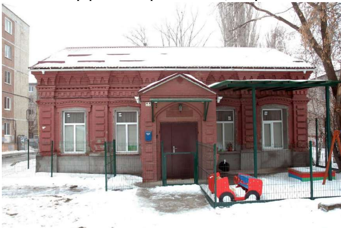
Главный северо-западный фасад здания – выявленного объекта культурного наследия «Дом жилой», кон. XIX – нач. XX вв. по ул. Краснослободская, 9
