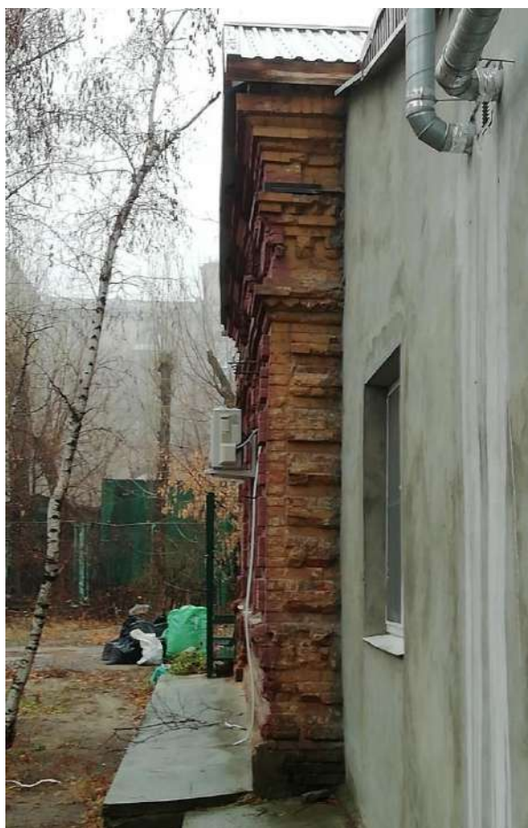
Фото 14. Вид со стороны юго-восточного фасада на выступающий угловой фрагмент здания
