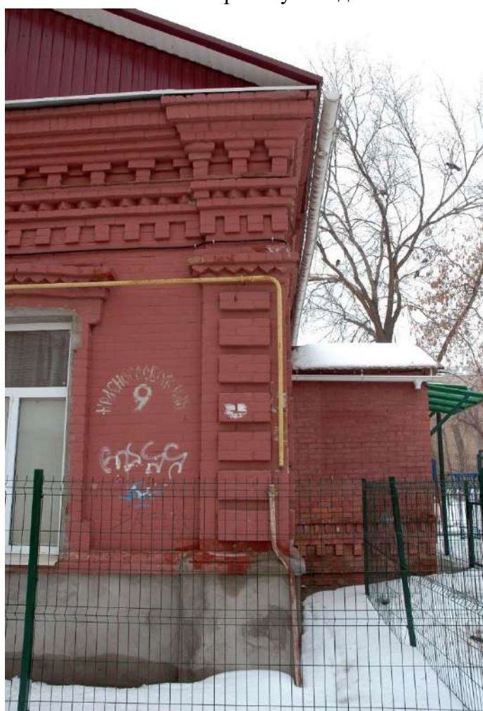
Фото 6. Фрагмент северо-восточного фасада здания
