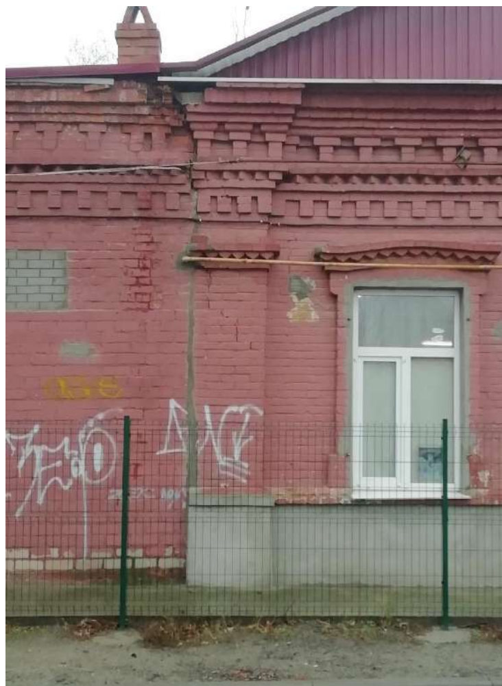
Фото 8. Примыкание пристройки со стороны юго-восточного фасада здания. Фрагмент
