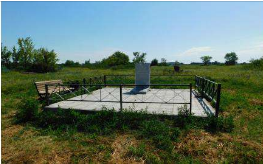
Вид на объект культурного наследия по текущему его состоянию
