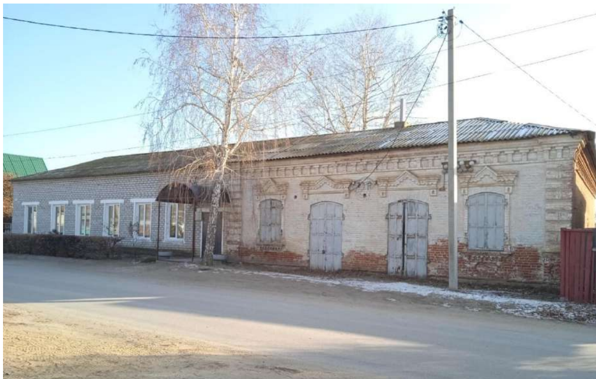
Общий вид на лицевой северо-западный фасад
