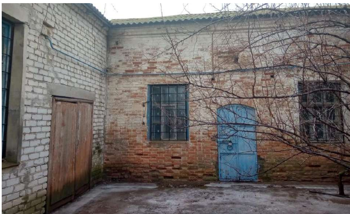
Общий вид на северо-восточный фасад дворового флигеля здания по ул. Буденного, 71
