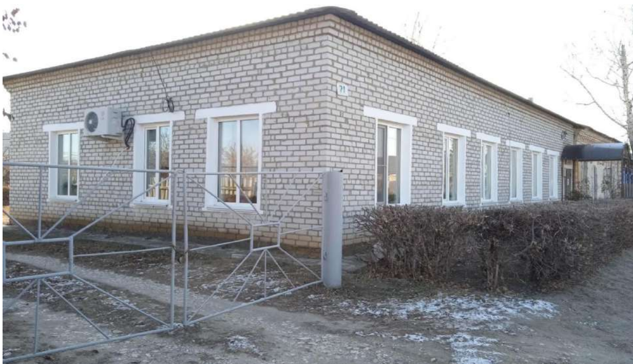
Фото 10. Вид на пристройку к зданию по адресу ул. Буденного, 71 с севера; северо-западный и северо-восточный фасады.
