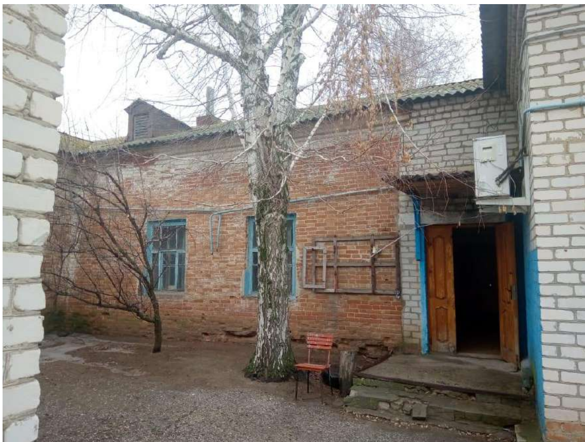
Дворовый фасад здания по ул. Буденного, 71 в месте примыкания к северо-восточному торцевому фасаду
