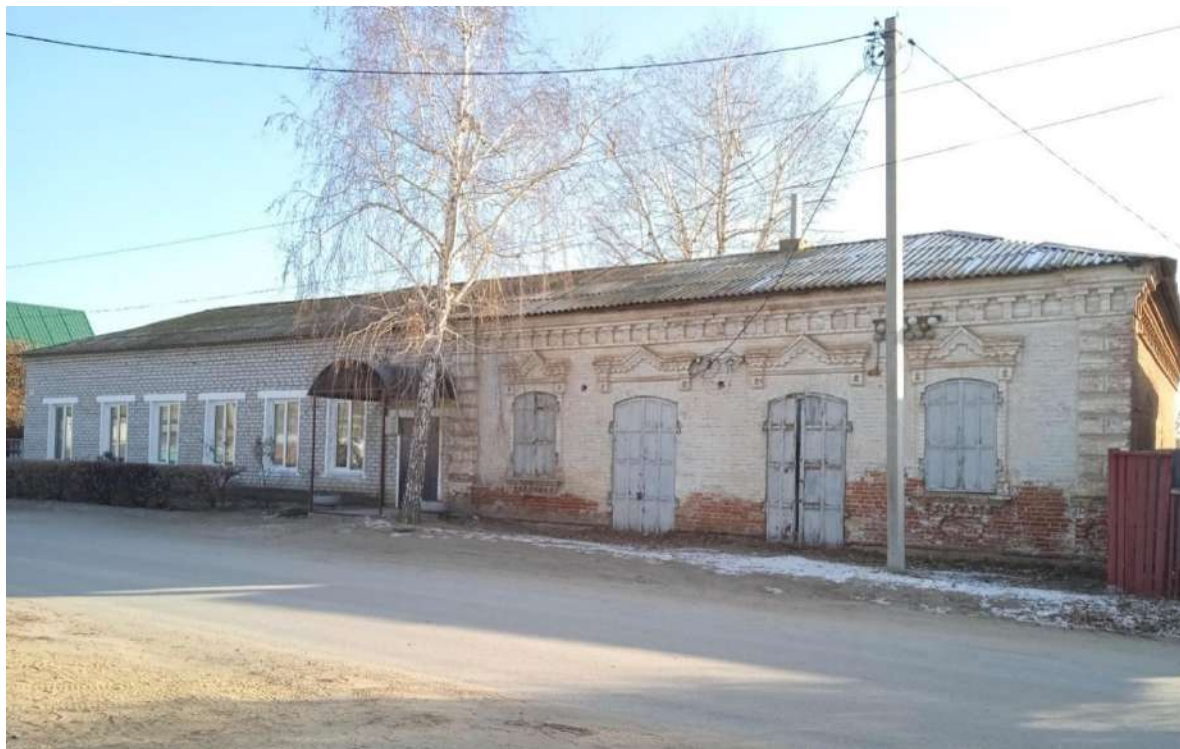
Фото 5. Вид на главный северо-западный фасад здания выявленного объекта культурного наследия - «Лавка торговая», кон. XIX в. по адресу ул. Буденного, 71 с пристройкой к торцевой северо-восточной стене.
