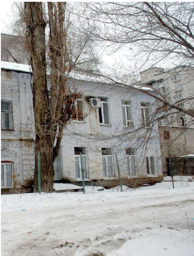
Фото 7. Пристройка (объектом культурного наследия не является) к северо-западному дворовому фасаду
