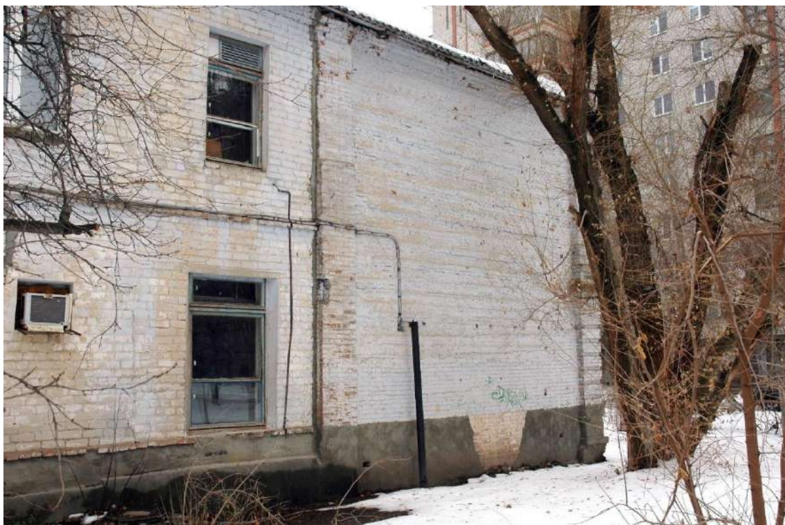
Фото 3. Вид на юго-западный фасад (фрагмент) – место примыкания пристройки (объектом культурного наследия не является) к северо-западному дворовому фасаду
