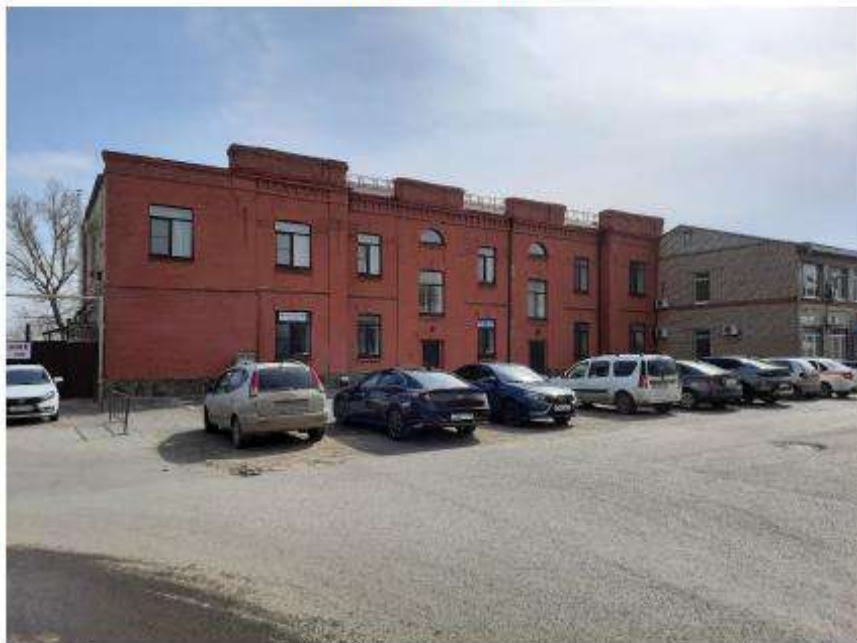
Фото 1. Здание из состава ОКН "Градостроительный комплекс по ул. Пугачевской".
