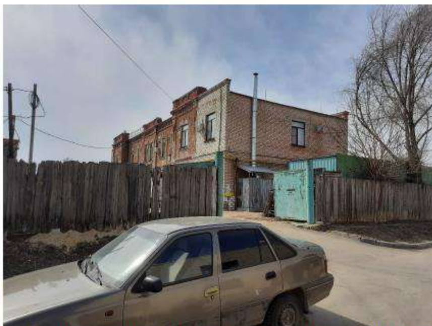
Фото 2. Здание из состава ОКН "Градостроительный комплекс по ул. Пугачевской".
