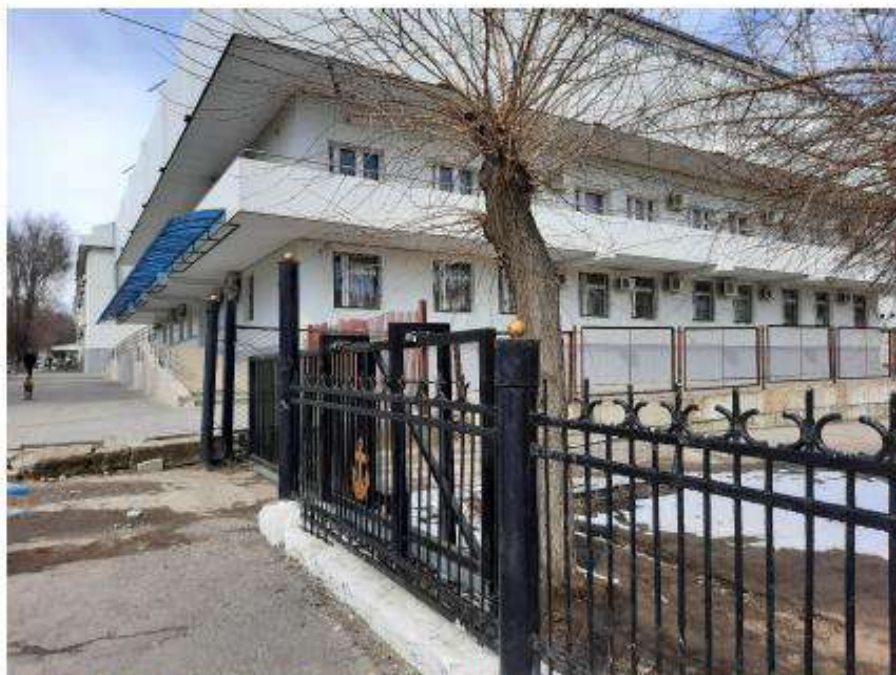
Фото 17. Вид на место, где располагался ОКН "Конторское здание (Волгоградское протезно-ортопедическое предприятие)".
